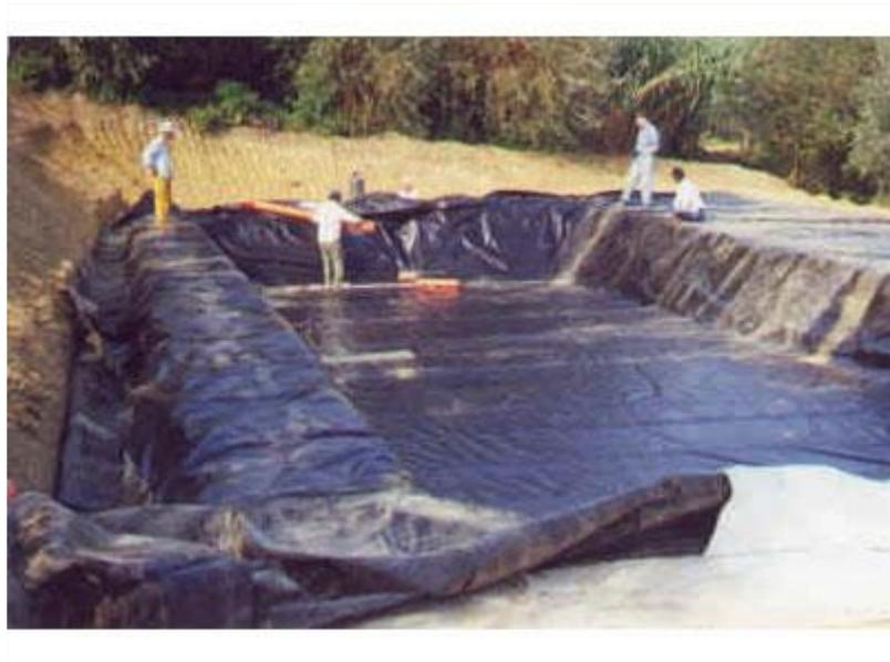
*Figura 3.73: Vasca in terra con telo in PVC in fase di realizzazione (vasca "tipo").*
