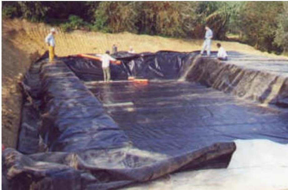
*Figura 3.78: Vasca in terra con telo in PVC in fase di realizzazione (vasca "tipo").*
