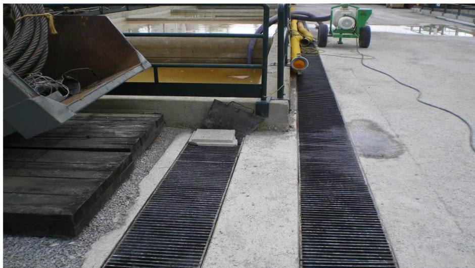
Figura 3.77: Canaletta “tipo” realizzata protetta con griglia per raccolta acque di lavaggio impianto.
