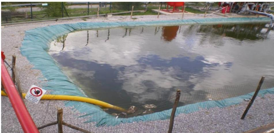
*Figura 3.79: Vasca in terra con telo in PVC (vasca "tipo" realizzata).*
