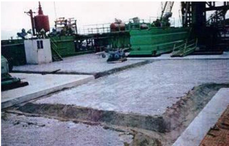
*Figura 3.75: Predisposizione solette perimetrali in cls e canalette in fase di costruzione.*
