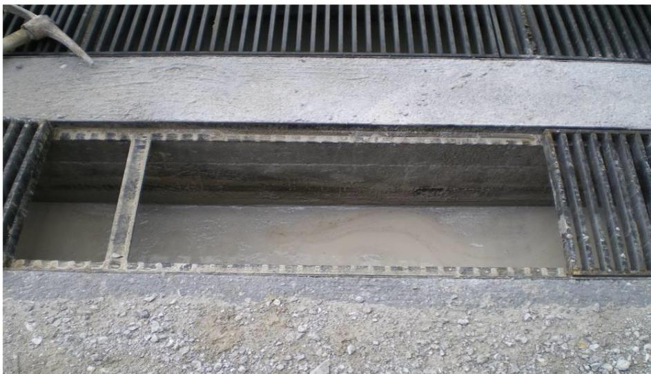
*Figura 3.76: Canaletta tipo realizzata.*
