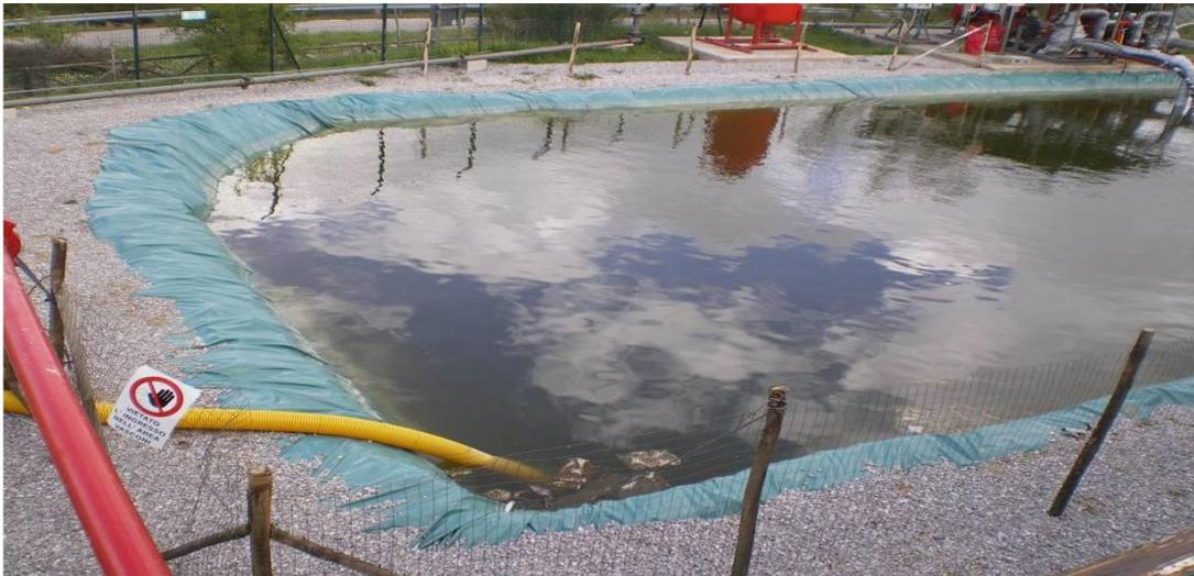
Figura 3.74: Vasca in terra con telo in PVC (vasca “tipo” realizzata).
