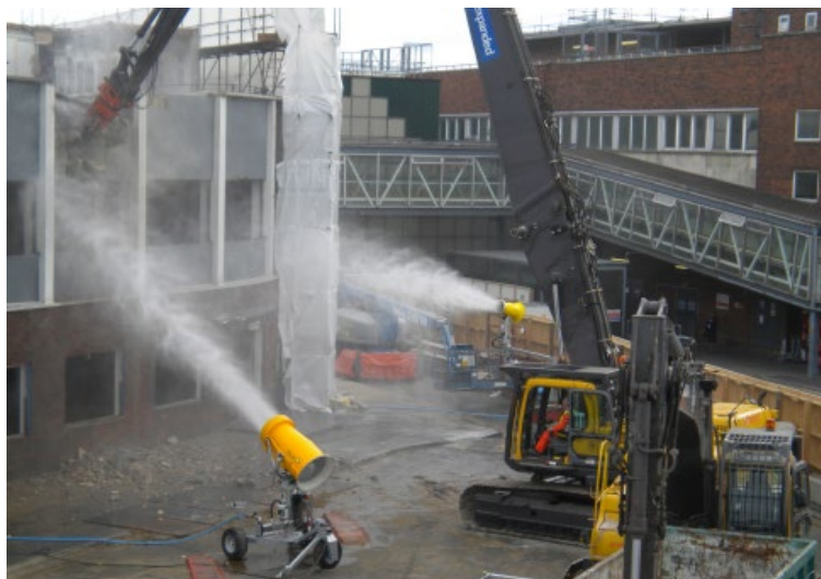
Figura 12 – Esempio di sistemi di abbattimento polveri in funzione durante le operazioni di demolizione
