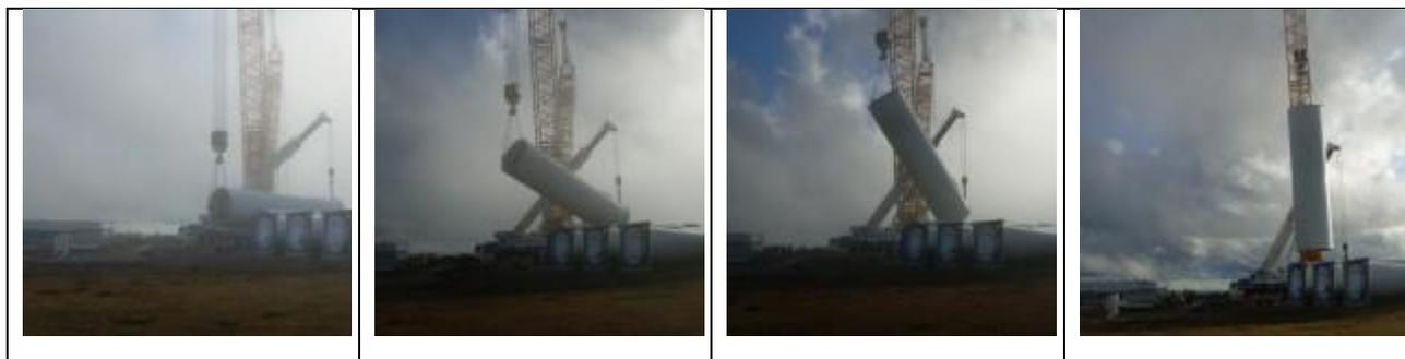
Figura 5-25 – Schema delle fasi di sollevamento dei componenti dell'aerogeneratore (Fonte sito web <http://www.windfarmbop.com/> )
