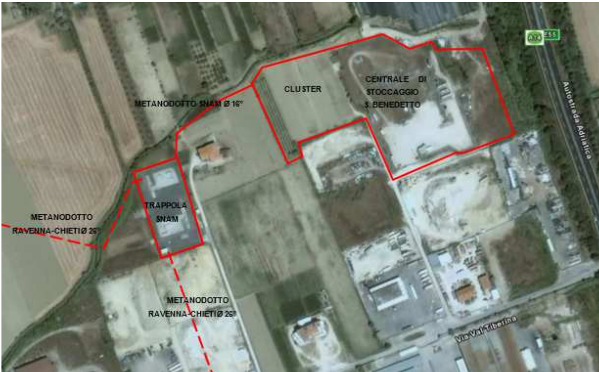
Figura 2. Localizzazione degli impianti
