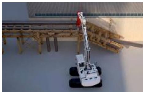
Figura 6.14 Demolizione rack con escavatore
