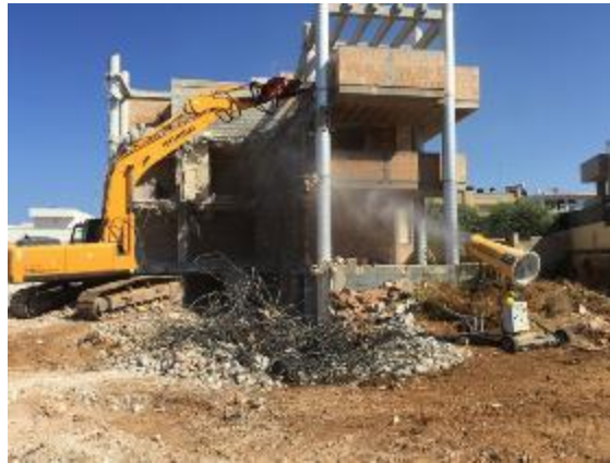
Figura 6.23 Lance nebulizzatrici per abbattimento polveri
