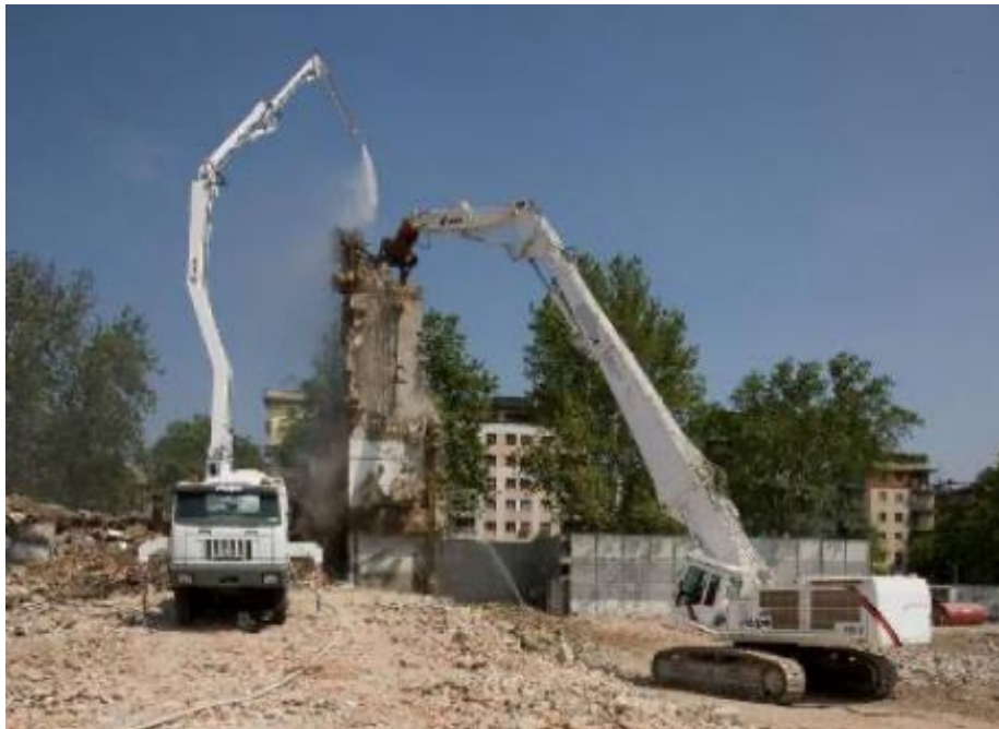
Figura 6.24 Braccio telescopico per abbattimento di polveri
