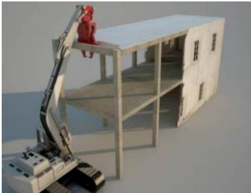
Figura 6.5- Sequenza operativa demolizione (c)
