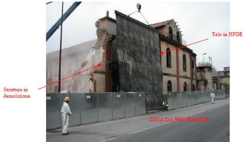
Figura 6.27 Esempio uso telo HDPE per contenimento polveri e detriti da demolizione
