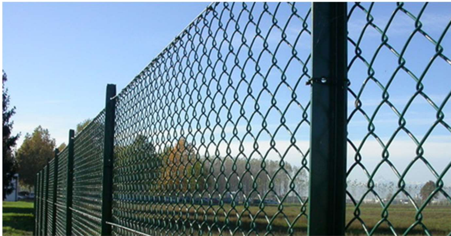
Figura 3. Esempio di recinzione perimetrale con pali ad infissione nel terreno senza utilizzo di plinti in cemento
