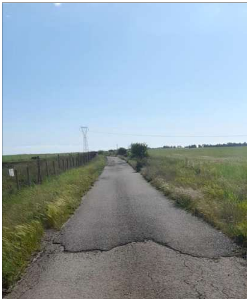
Figura 6: Ultimo tratto Strada in direzione nuova SE 220/36 kV Aglientu: larghezza pari a 4,70 metri
