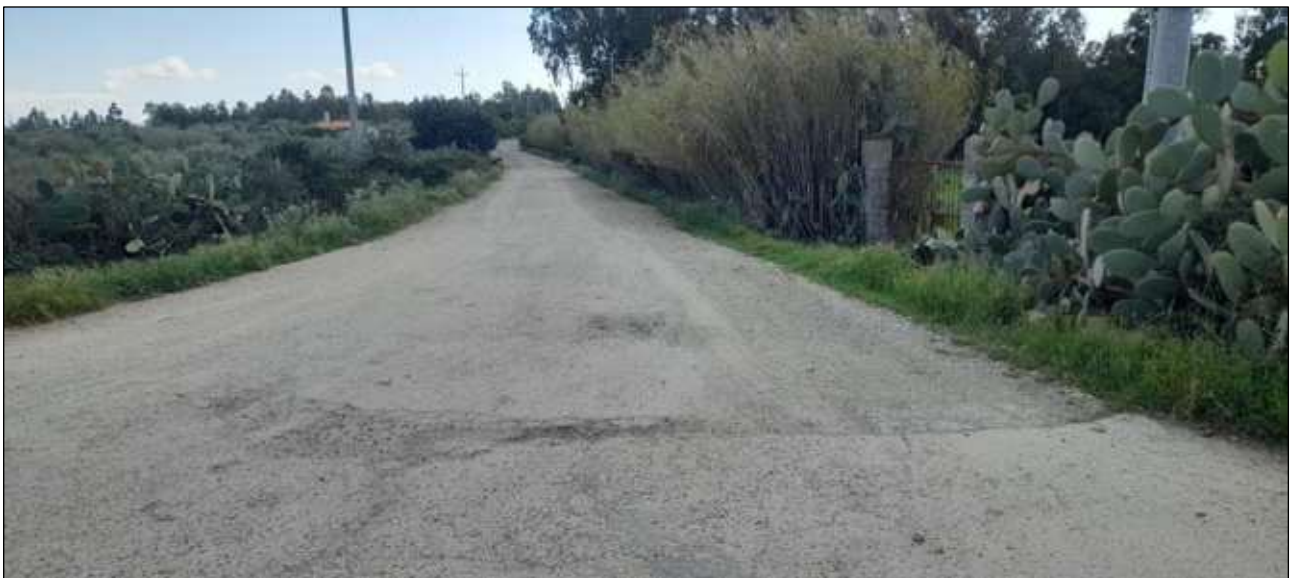
Figura 4: Ingresso da SP 15 della strada che arriva alla cava: larghezza 7,7 metri
