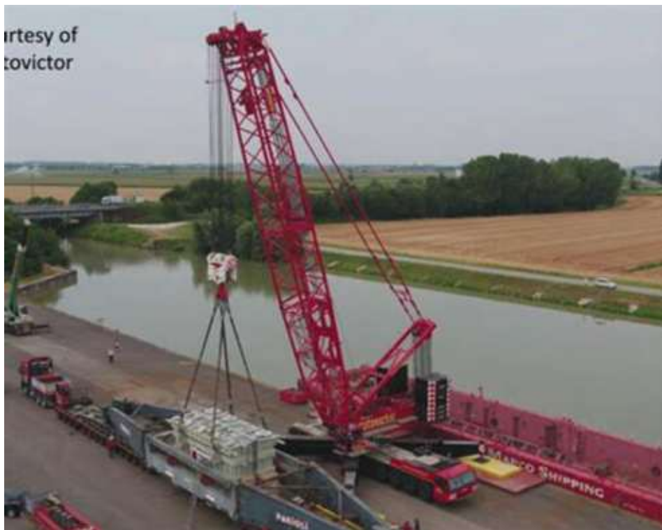
Figura 9: Trasbordo convoglio terrestre – nave con autogrù a tiro pieno
