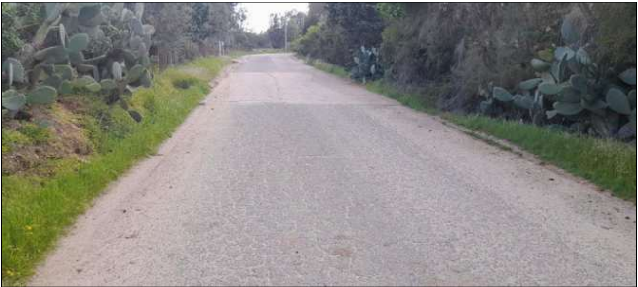
Figura 5: Strada che arriva alla cava: larghezza 5,8 metri
