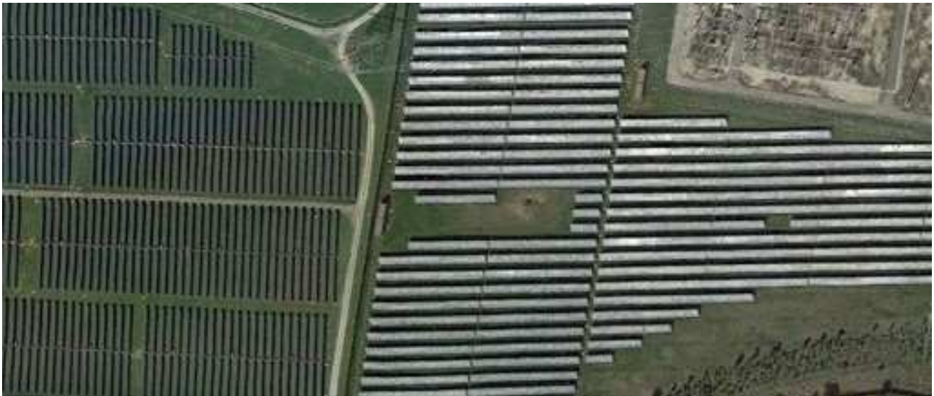
Figura 9 - Confronto impianti fotovoltaici a diversa tecnologia.
