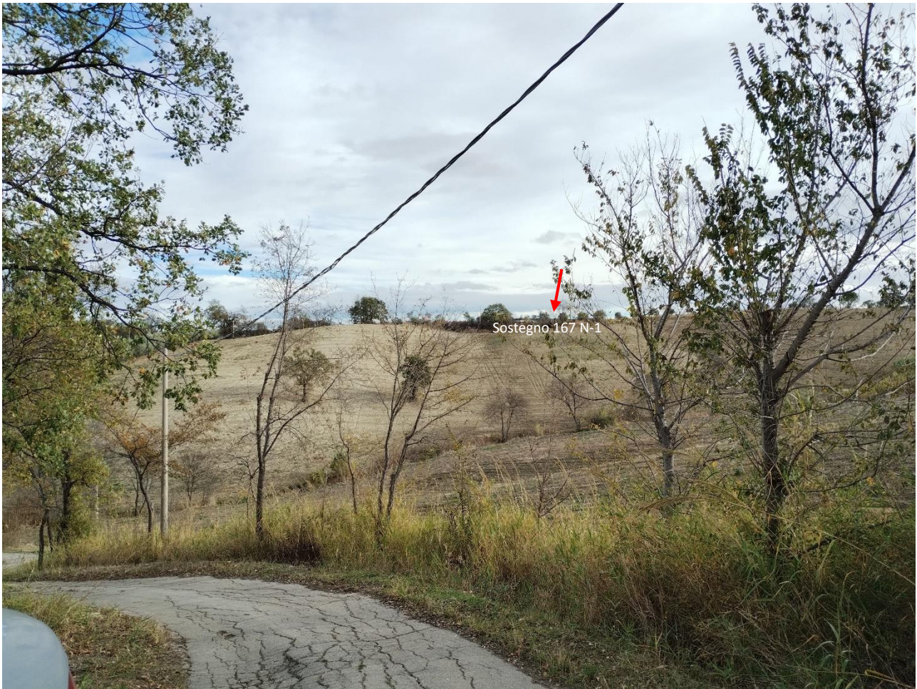
Foto 14: PV14 - Inquadramento con indicazione del posizionamento del sostegno 167 N-1 e attraversamento dei raccordi a 380 kV con interferenza linea bT (Coordinate: 483387.08 m E; 4639188.23 m N)
