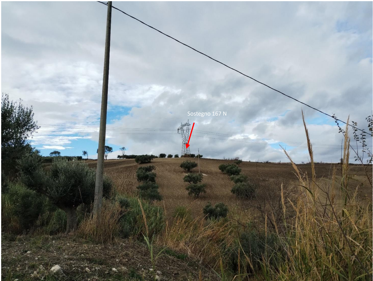
Foto 15: PV15 - Inquadramento con indicazione del posizionamento del sostegno 167 N da sostituire al sostegno esistente e attraversamento dei raccordi a 380 kV con interferenza linea bT (Coordinate: 483361.53 m E; 4639151.10 m N)
