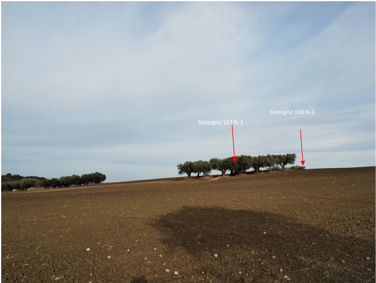
Foto 6: PV6 - Inquadramento con indicazione del posizionamento dei sostegni 167 N-3 su ulivi e 168 N-3 su terreno agricolo e attraversamento dei raccordi a 380 kV (Coordinate: 484231.00 m E; 4639853.70 m N)
