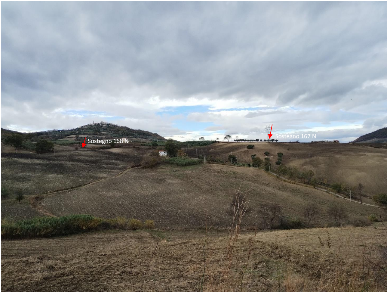
Foto 12: PV12 - Inquadramento con indicazione del posizionamento dei sostegni 167 N e 168 N e attraversamento dei raccordi a 380 kV (Coordinate: 483659.72 m E; 4639264.10 m N)
