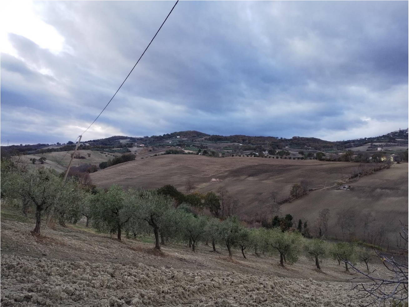
Foto 10: PV10 - Inquadramento dell'attraversamento dei raccordi aerei a 380 kV con interferenza linea bT (Coordinate: 483849.58 m E; 4639851.33 m N)
