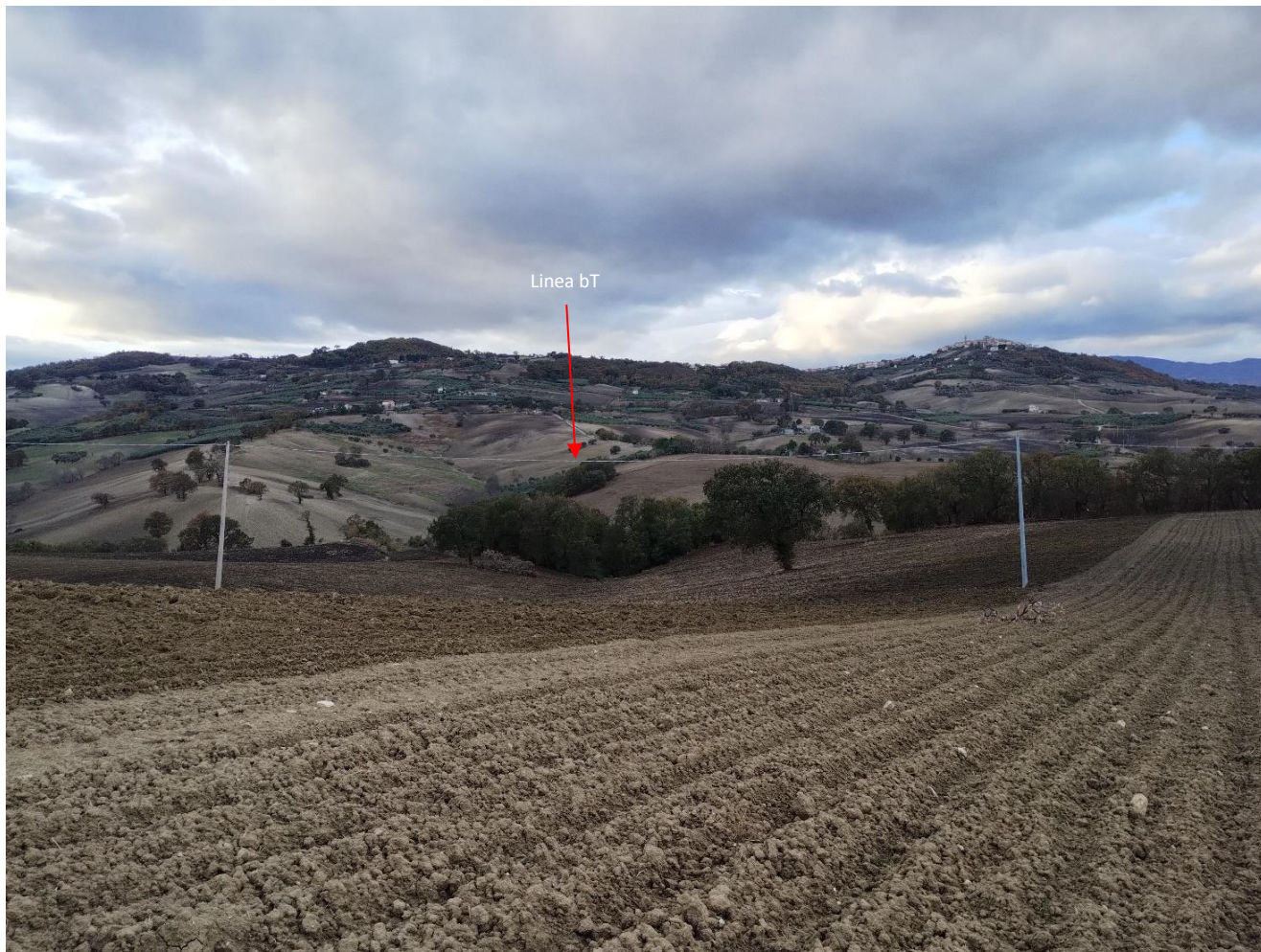
Foto 8: PV8 - Inquadramento dell'attraversamento dei raccordi aerei a 380 kV con interferenza linea bT (Coordinate: 484223.25 m E; 4639835.62 m N)
