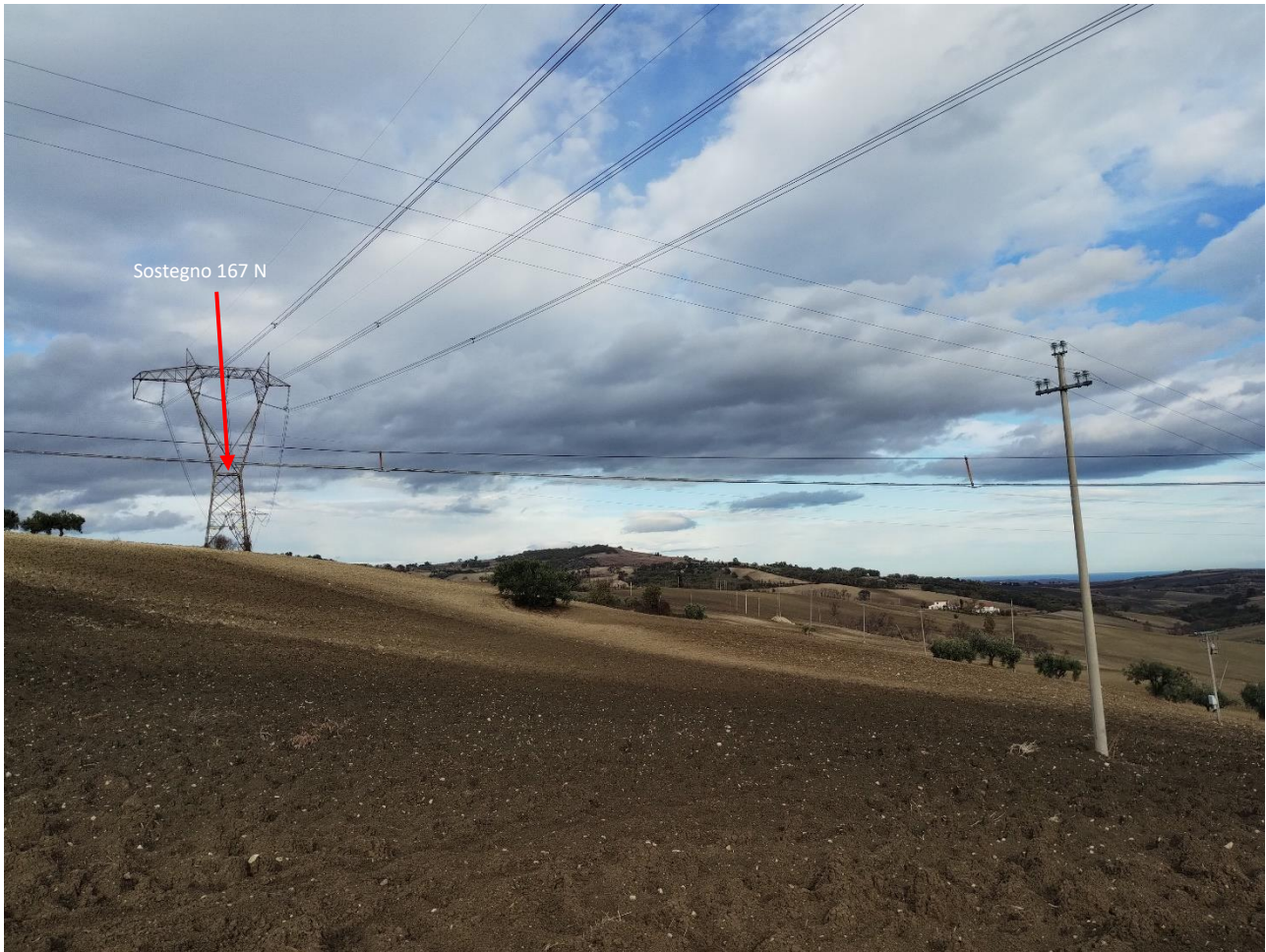
Foto 17: PV17 - Inquadramento con indicazione del posizionamento del sostegno 167 N da sostituire al sostegno esistente (Coordinate: 483243.06 m E; 4638961.52 m N)
