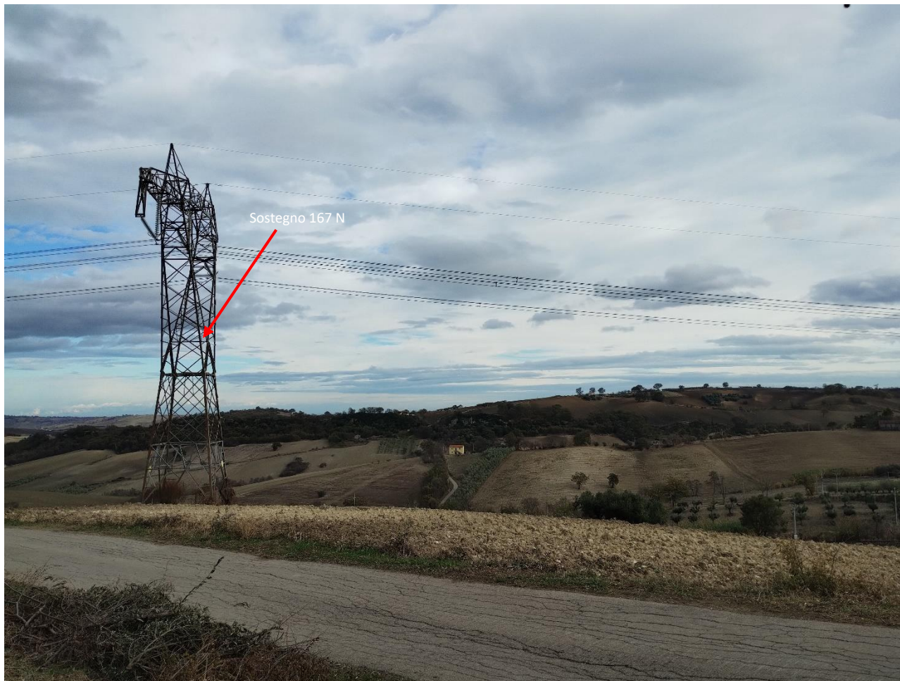
Foto 18: PV18 - Inquadramento con indicazione del posizionamento del sostegno 167 N da sostituire al sostegno esistente (Coordinate: 483095.99 m E; 4639025.70 m N)
