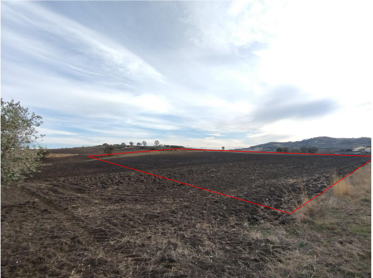
Foto 1: PV1 - Inquadramento con indicazione del posizionamento della futura SE RTN 380/150 kV (in rosso) su terreno agricolo
