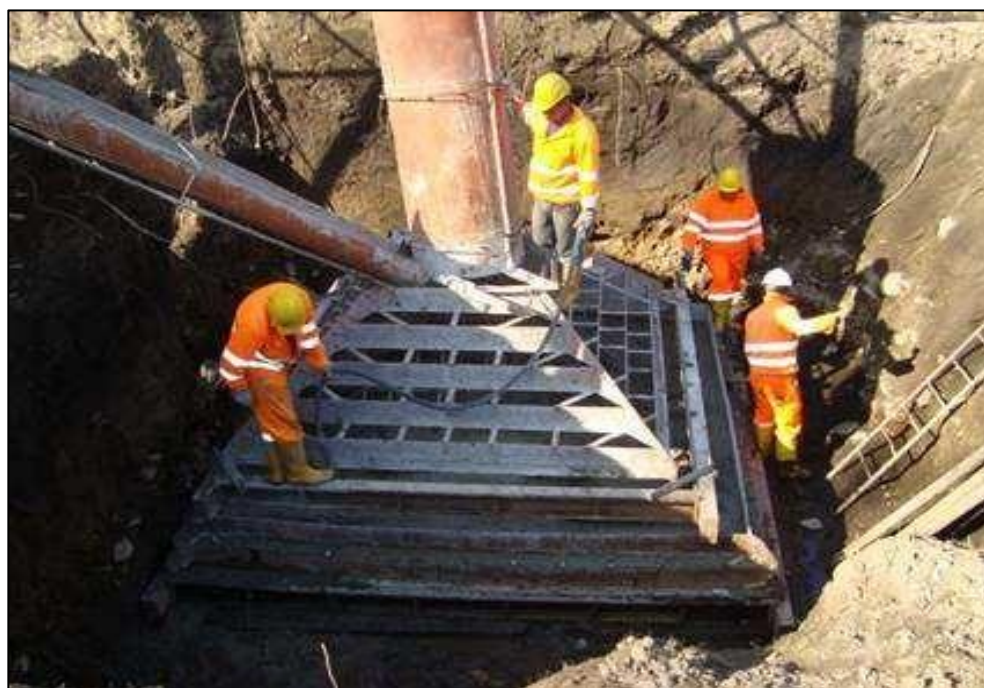
Figura 45 – Esempio di realizzazione del piede di fondazione.
