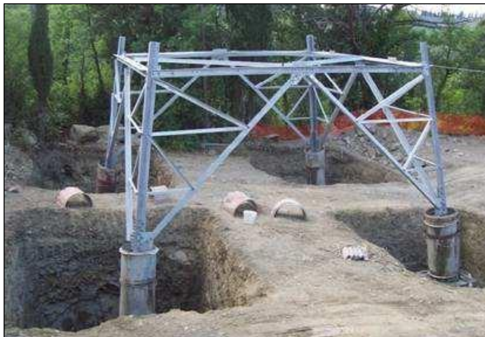
Figura 44 – Esempio di fondazione di un sostegno.
