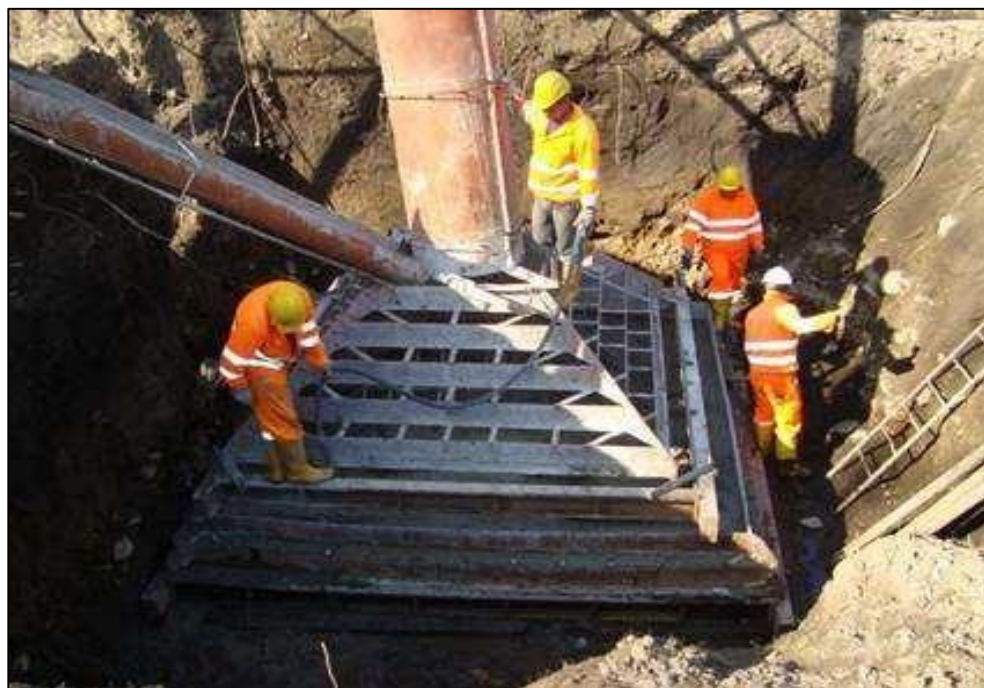
Figura 24 – Esempio di realizzazione del piede di fondazione.
