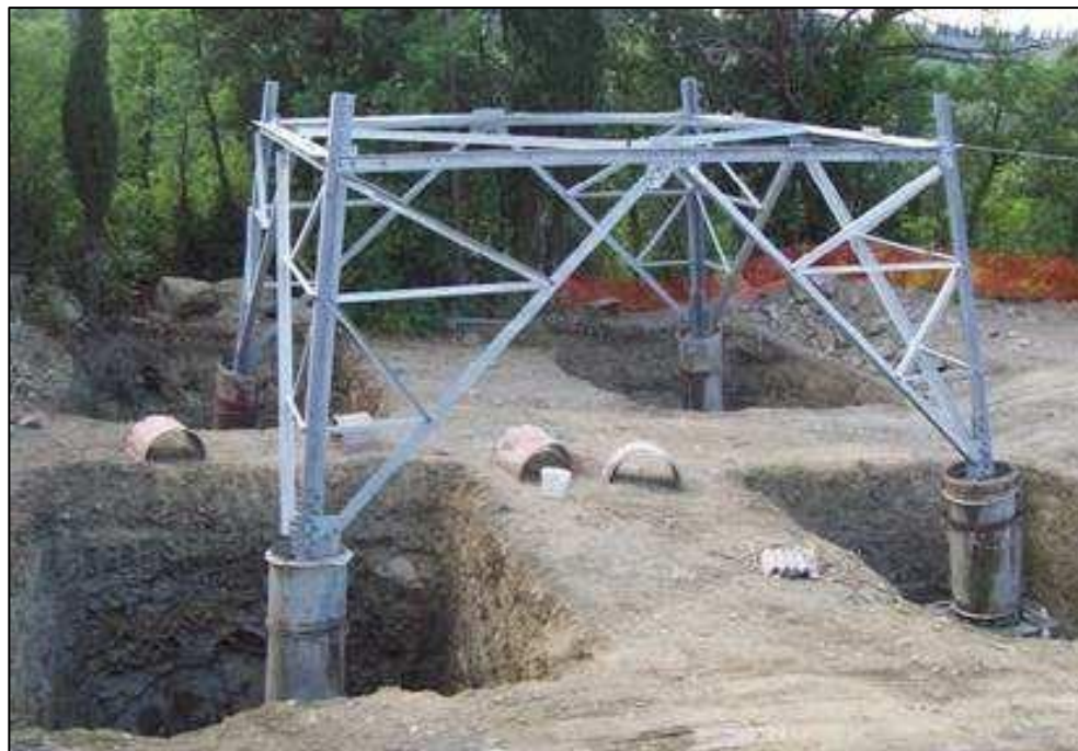
Figura 23 – Esempio di fondazione di un sostegno.
