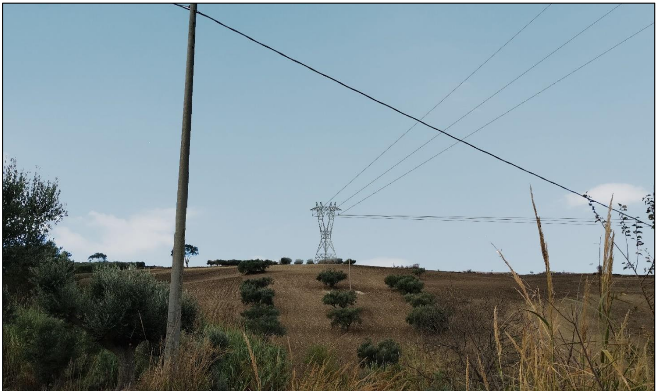
Figura 38 – PV5: Punto di ripresa in direzione dell'area prevista per la realizzazione del sostegno 167 N. Post – operam. (Coordinate: 483369.00 m E; 4639152.00 m N).
