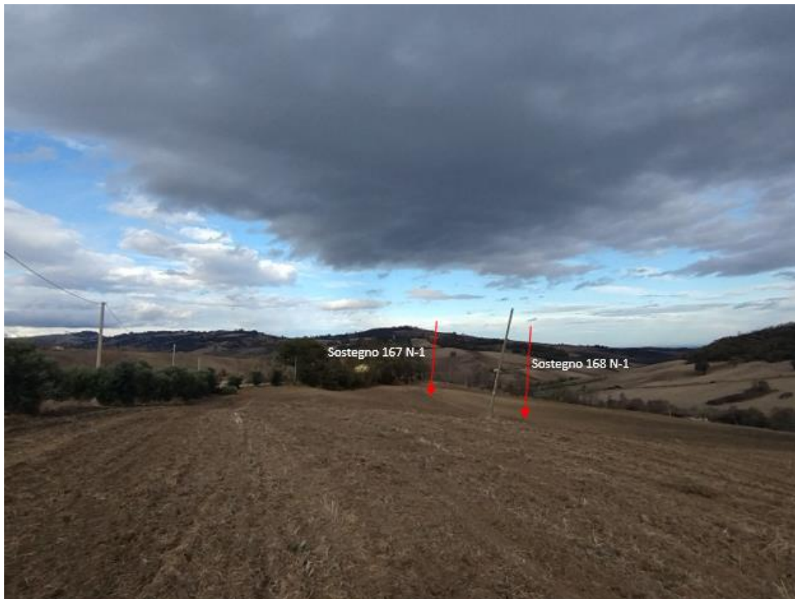
Figura 35: PV11 - Inquadramento con indicazione del posizionamento dei sostegni 167 N-1 e 168 N-1 su terreno agricolo e interferenza linea bT del passaggio dei raccordi a 380 kV (Coordinate: 483708.27 m E; 4639238.56 m N)
