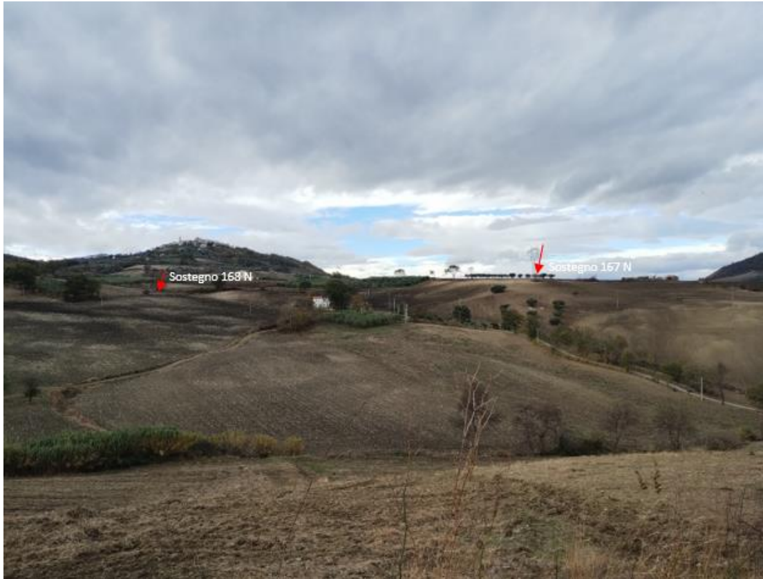
Figura 36: PV12 - Inquadramento con indicazione del posizionamento dei sostegni 167 N e 168 N e attraversamento dei raccordi a 380 kV (Coordinate: 483659.72 m E; 4639264.10 m N)
