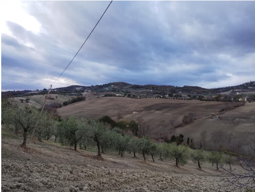
Figura 34: PV10 - Inquadramento dell'attraversamento dei raccordi aerei a 380 kV con interferenza linea bT (Coordinate: 483849.58 m E; 4639851.33 m N)
