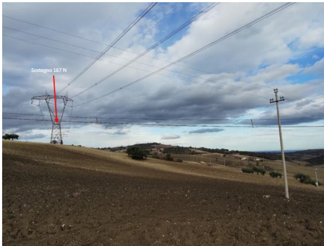
Figura 41: PV17 - Inquadramento con indicazione del posizionamento del sostegno 167 N da sostituire al sostegno esistente (Coordinate: 483243.06 m E; 4638961.52 m N)
