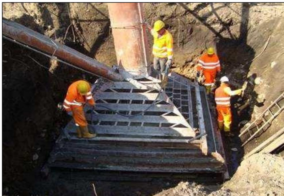
**Figura 24 – Esempio di realizzazione del piede di fondazione.**
