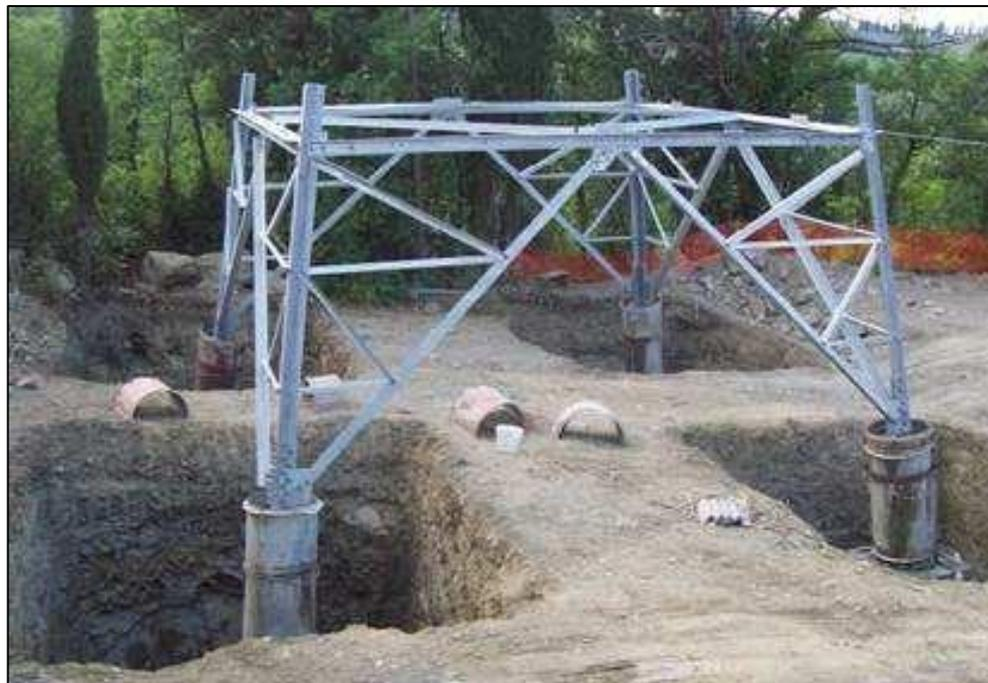
**Figura 23 – Esempio di fondazione di un sostegno.**
