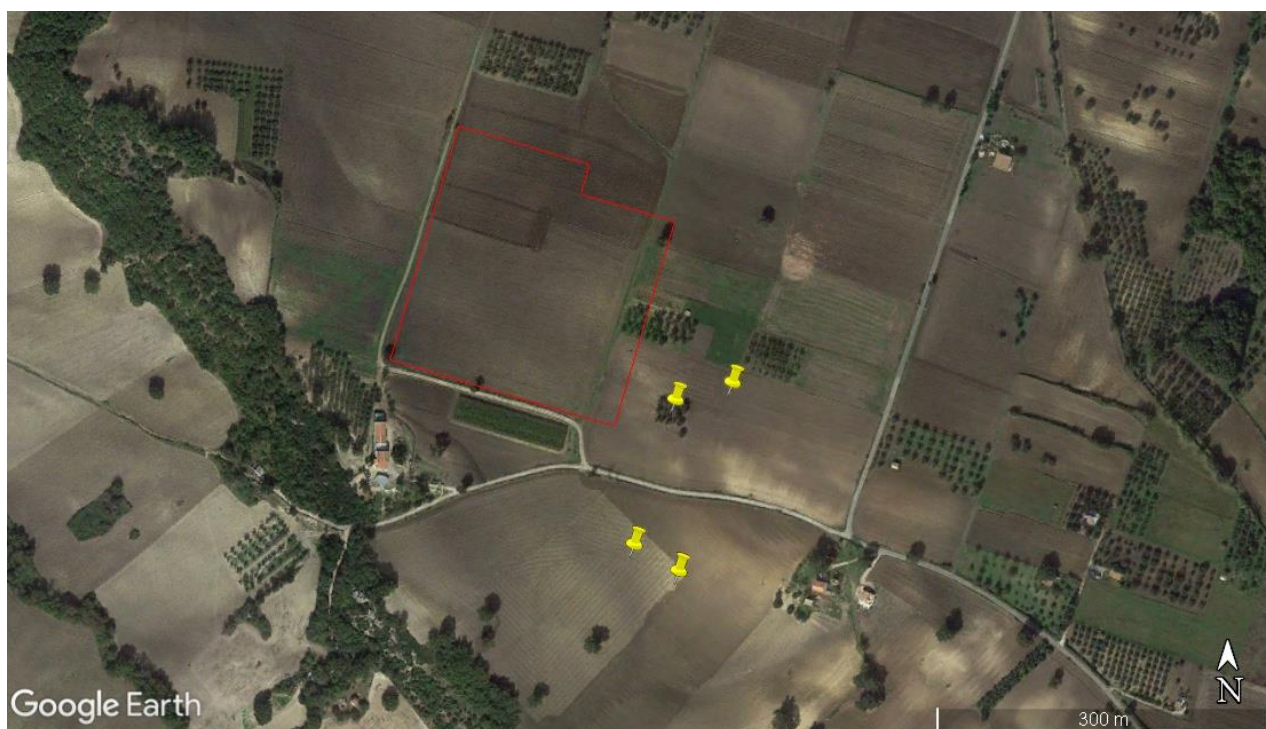
Figure 9. Immagine satellitare del 2014. In rosso la stazione RTN, in giallo i sostegni (da Google Earth).
