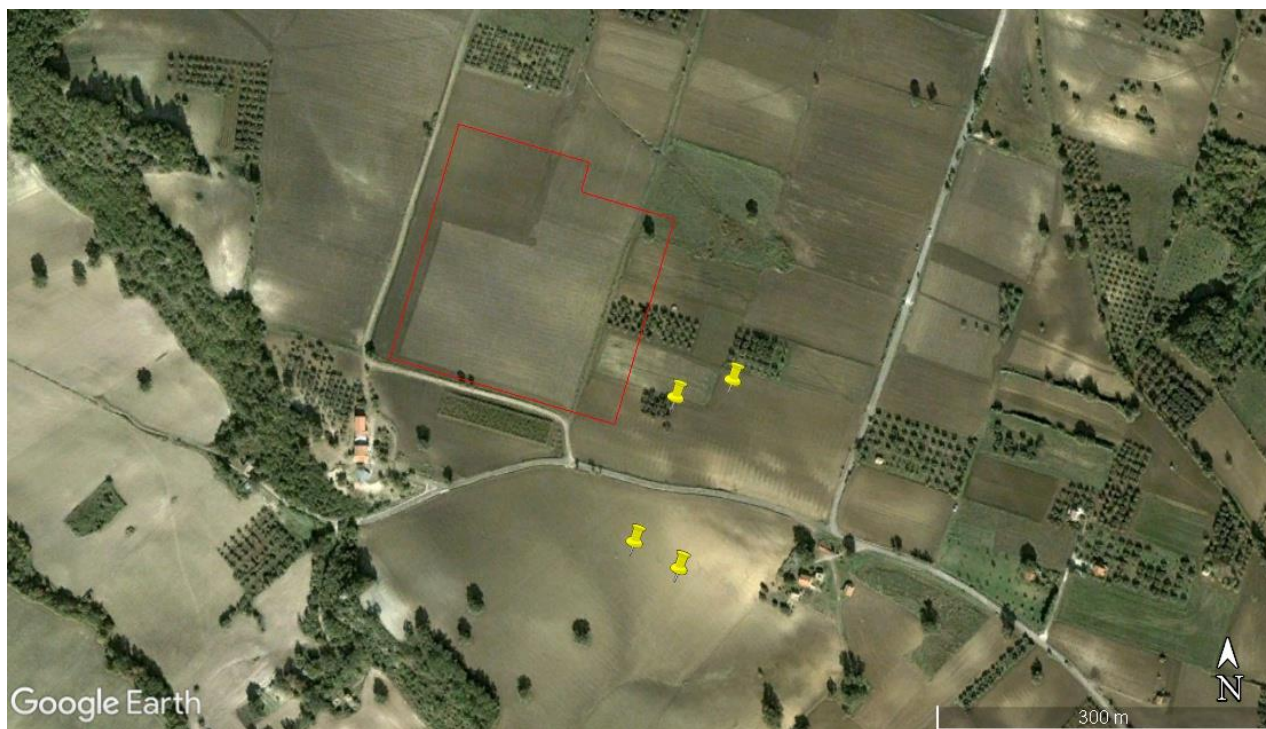
Figura 11. Immagine satellitare del 2006. In rosso la stazione RTN, in giallo i sostegni (da Google Earth).
