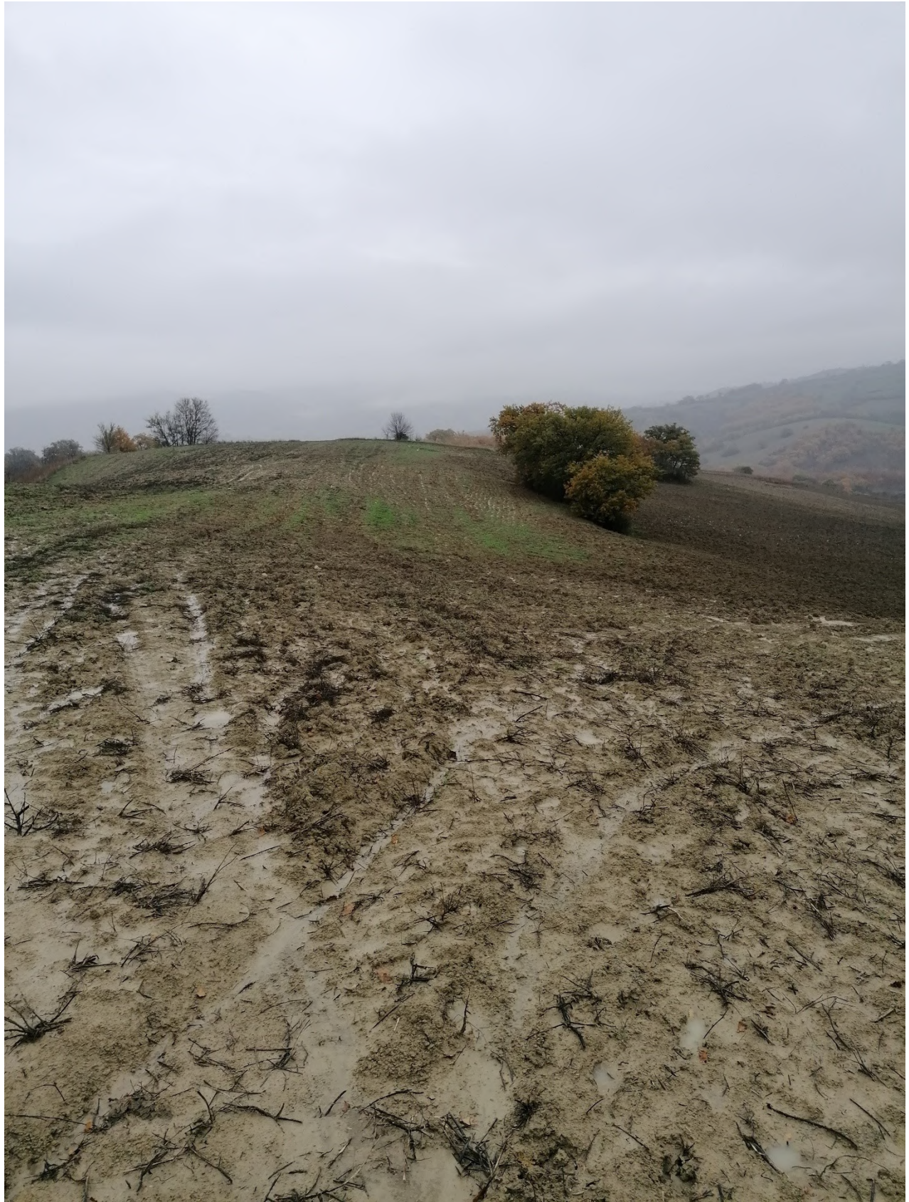
Foto 4: Area di passaggio con evidenza dei terreni argillosi, verso la WTG1.
