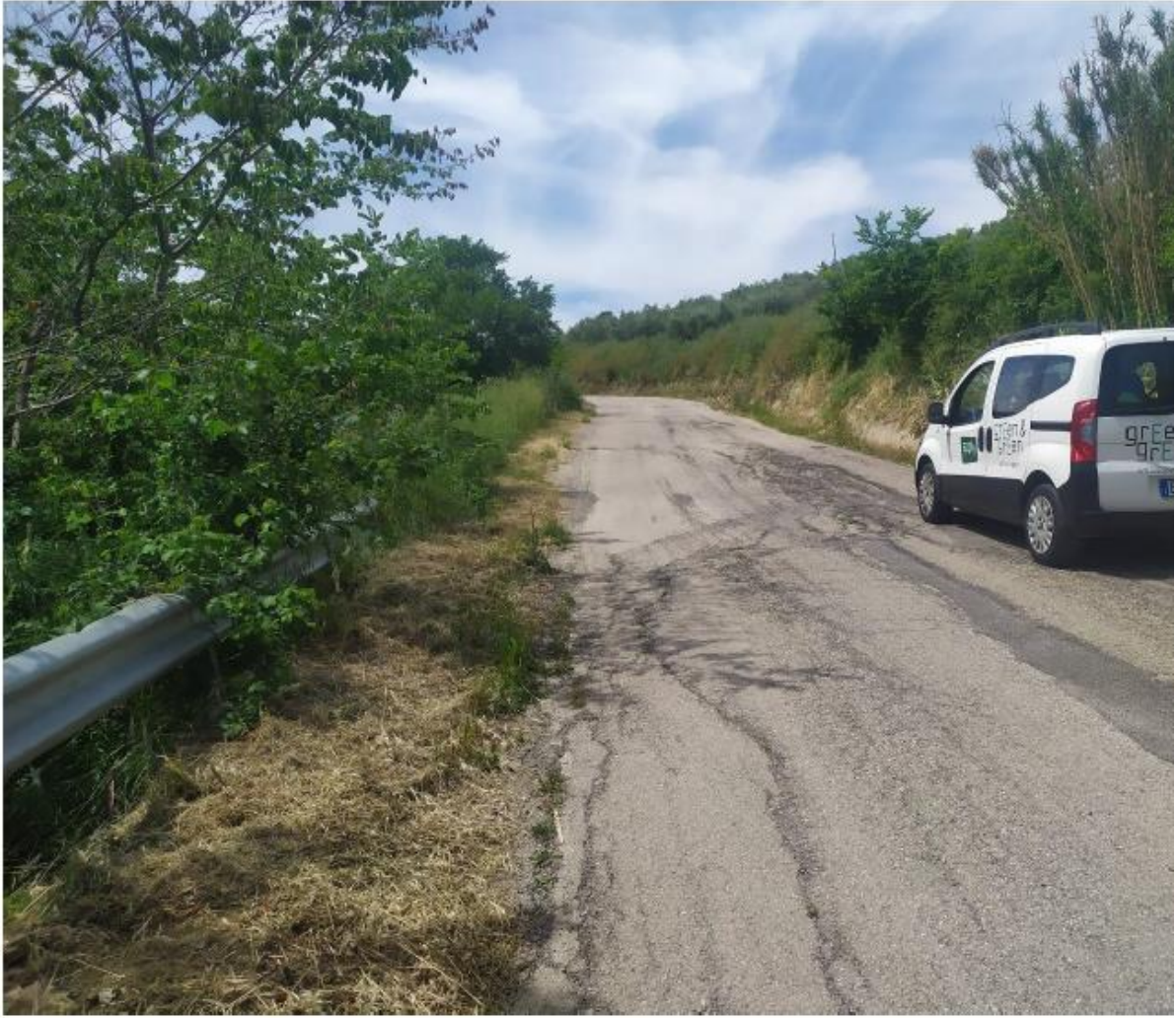
Figura 43- Vista dal punto P28: stato dei luoghi dove verrà posto il cavidotto in MT. Il cavidotto si svilupperà lungo la strada esistente SP13
