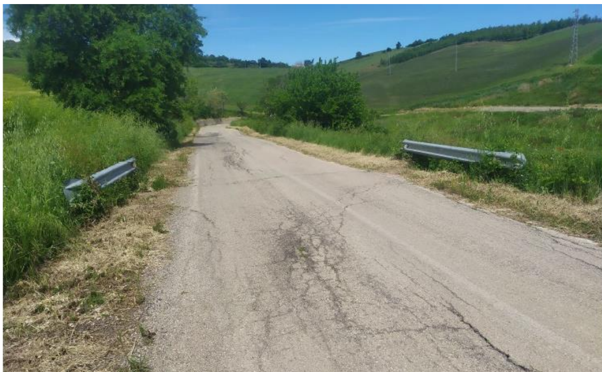
Figura 42- Vista dal punto P27: stato dei luoghi dove verrà posato il cavidotto in MT. Il cavidotto si svilupperà lungo la strada esistente SP13
