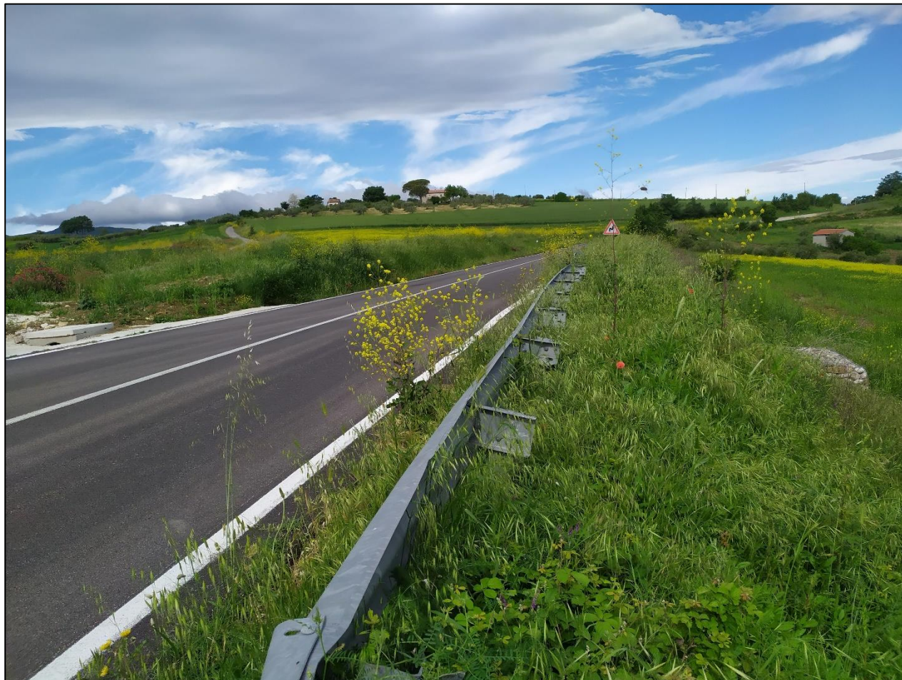
Foto 5: Inquadramento del sito dove verrà posto il cavidotto in MT, su asse stradale (punto di ripresa P9)
