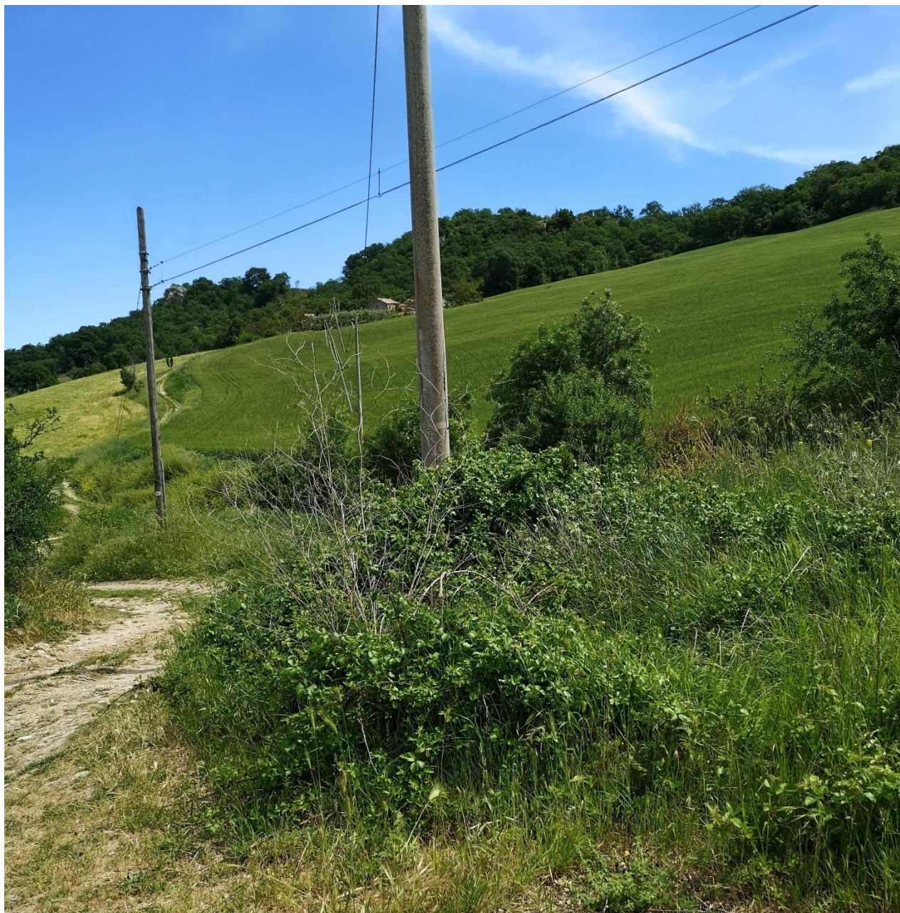
Figura 44- Vista dal punto P29: stato dei luoghi in prossimità dell'area interessata dal passaggio del cavidotto in MT.
