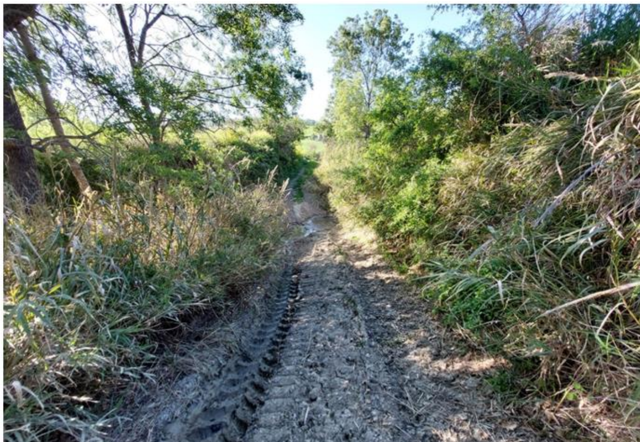
Figura 50: Inquadramento del sito dove verrà posto il cavidotto in MT, su sterrato (punto di ripresa PV13)
