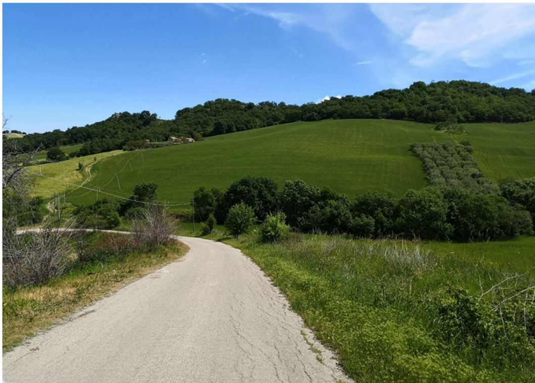
Cavidotto nei pressi della Futura Stazione RTN
