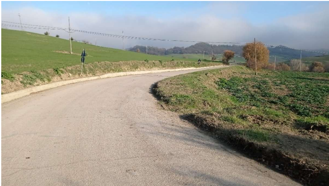
Cavidotto lungo la SP 13 loc. Masseria della Corte
