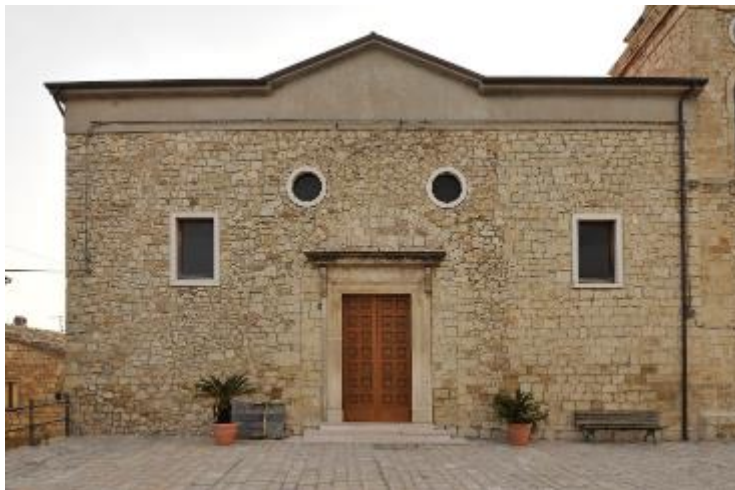
Figura 30: Chiesa di S. Rocco (Fonte: https://www.beweb.chiesacattolica.it/edificidiculto/edificio/26629/Chiesa+di+San+Rocco )
