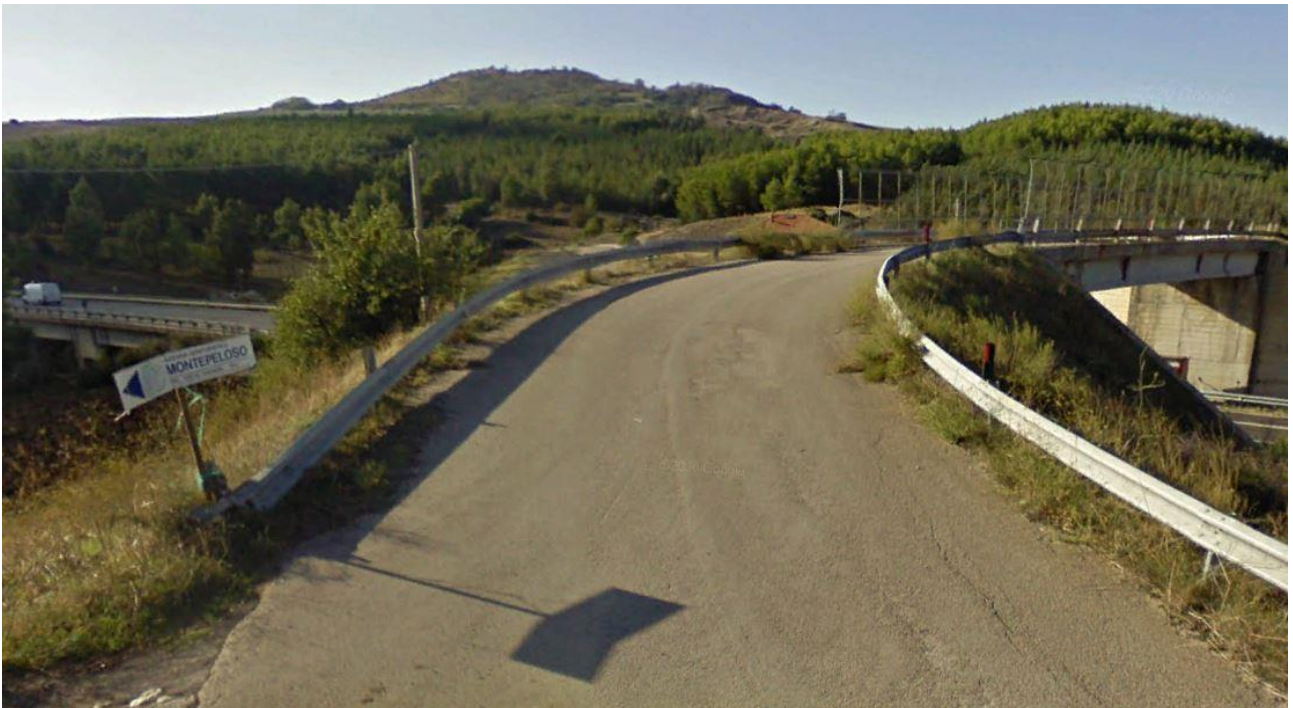
Foto 39 - Post-operam: inquadramento nella direzione del posizionamento dell'impianto (visuale da Punto di ripresa P15 - Coordinate: 485425.95m E; 4630015.07 m N - Angolo: 315° N. Fonte: Google Street View)
