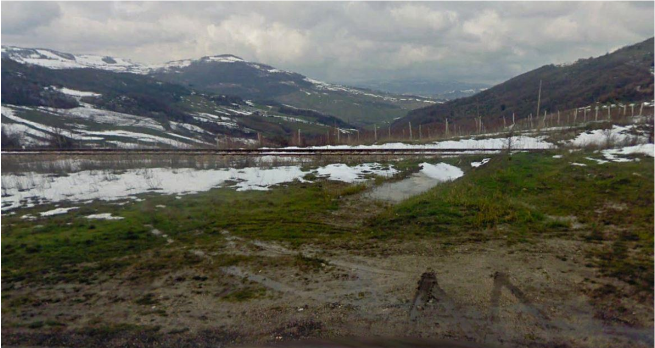
Foto 51 - Ante-operam: Inquadramento dell'area di posizionamento delle WTG (Visuale da Punto di ripresa P22 – Coordinate: 489403.97 m E; 4622673.00 m N – Angolo: 320° N. Fonte: Google Street View)
