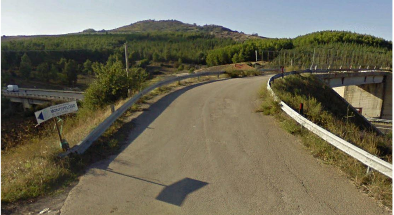
Foto 38 - Ante-operam: inquadramento nella direzione del posizionamento dell'impianto (visuale da Punto di ripresa P15 - Coordinate: 485425.95m E; 4630015.07 m N - Angolo: 315° N. Fonte: Google Street View)
