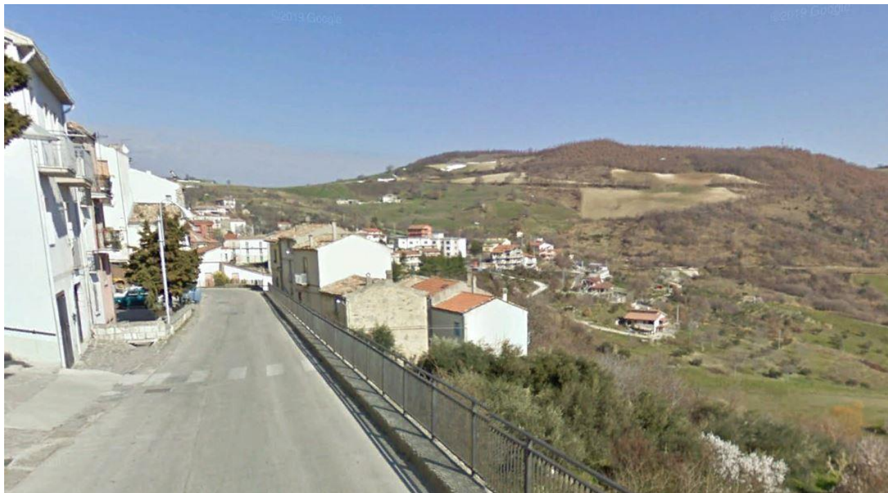
Foto 61 - Ante-operam: Inquadramento dell'area di posizionamento delle WTG (Visuale da Punto di ripresa P27 – Coordinate: 476403.82 m E; 4741850.46 m N – Angolo: 0° N. Fonte: Google Street View)
