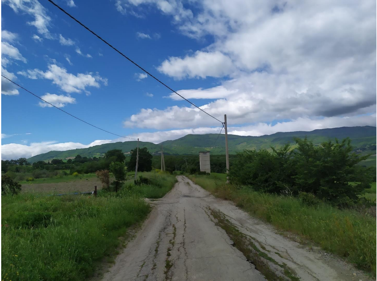
Figura 33. Attraversamento di linea elettrica BT e MT lungo il tracciato da adeguare per di collegamento con le WTG (477998.53 m E, 4635655.40 m N)
