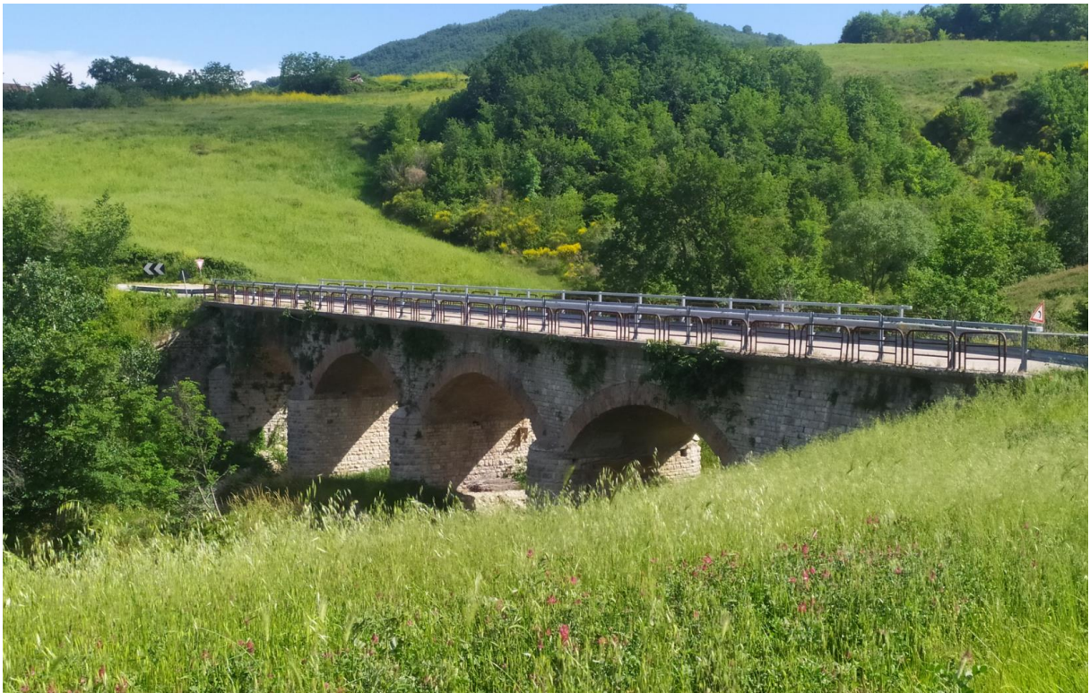
Figura 42. Opera di attraversamento in corrispondenza della viabilità esistente per il collegamento con la WTG 1 (475663.97 m E, 4634568.01 m N)
