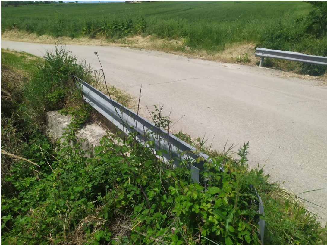
Figura 50. Opera di attraversamento in corrispondenza della viabilità esistente sulla strada provinciale Frentana per la connessione alla stazione multiutente 150/33 kV (481597.30 m E, 4638940.38 m N)
