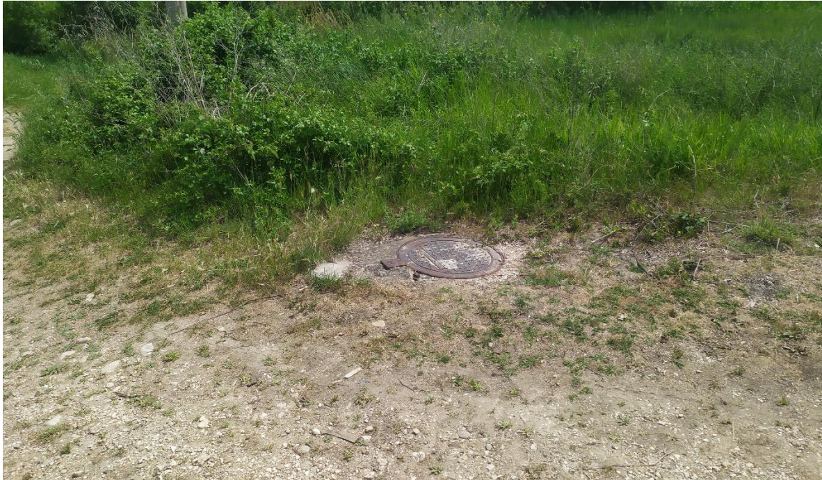
Figura 19. Pozzetto rilevato in corrispondenza del punto di coordinate (483324.25 m E 4640193.96 m N).
