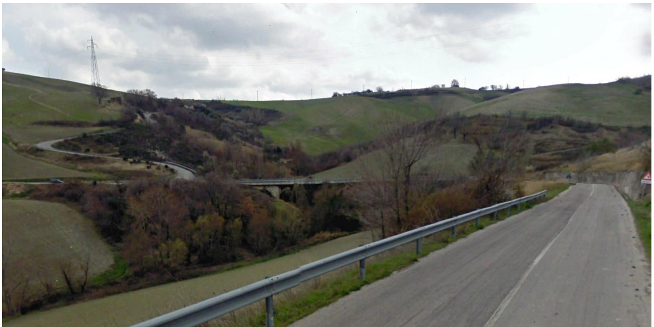
Figura 31. Interferenza della linea elettrica aerea e la viabilità stradale di collegamento (477834.72 mE 4633843.00 mN)
