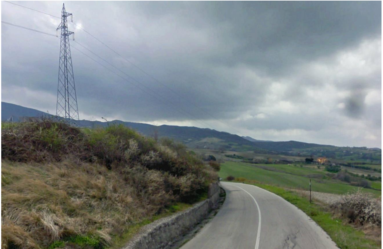
Figura 30. Interferenza della linea elettrica aerea e la viabilità stradale esistente di collegamento (477282.35 mE, 4634091.12 mN)
