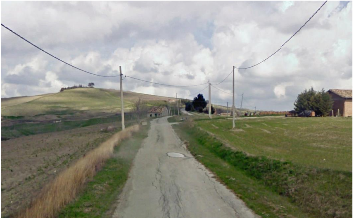
Figura 34. Attraversamento di linea elettrica BT e MT lungo il tracciato di collegamento con le WTG (477934.57 m E, 4635558.95 m N) lato Nord.
