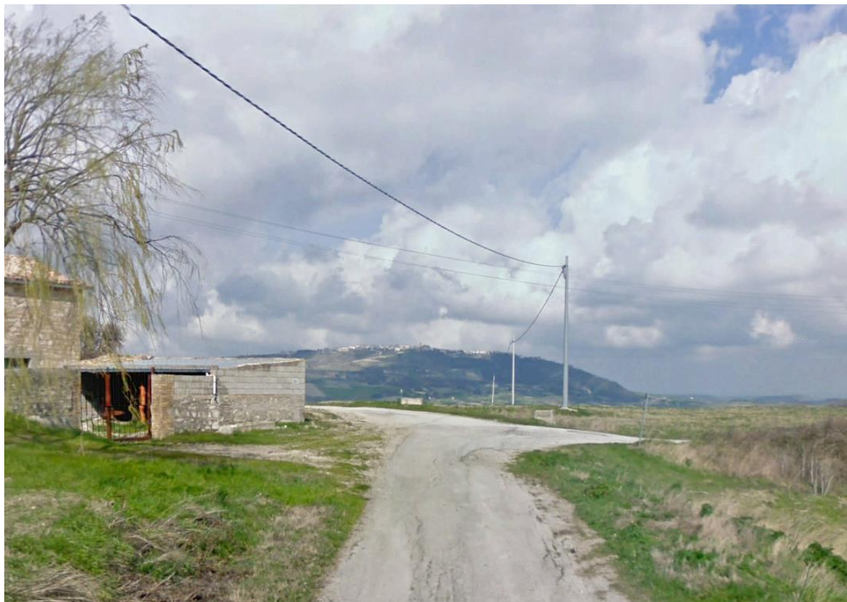
Figura 37. Attraversamento di linea elettrica lungo il tracciato di collegamento con le WTG (478598.59 m E, 4636362.91 m N)
