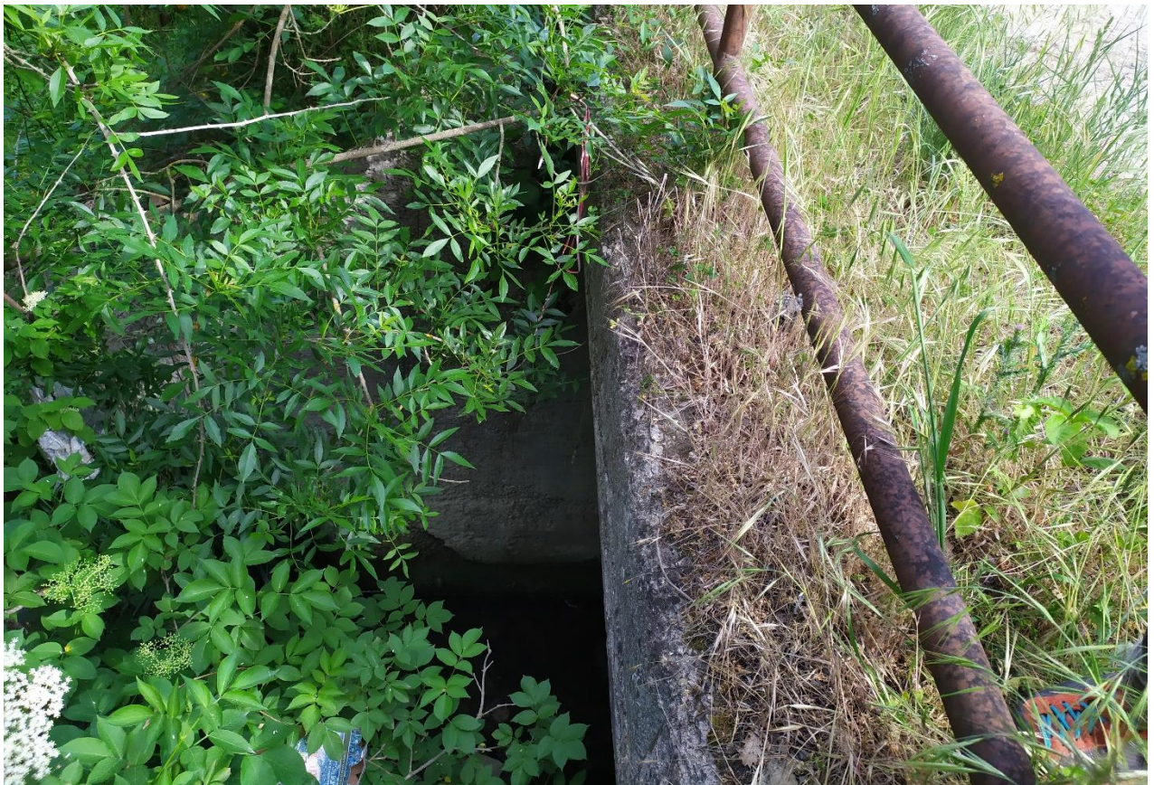
Figura 48. Opera di attraversamento in corrispondenza della viabilità esistente sulla strada comunale "macchialonga" per il collegamento delle WTG 6 e WTG 7 (478981.29 m E, 4635839.15 m N)
