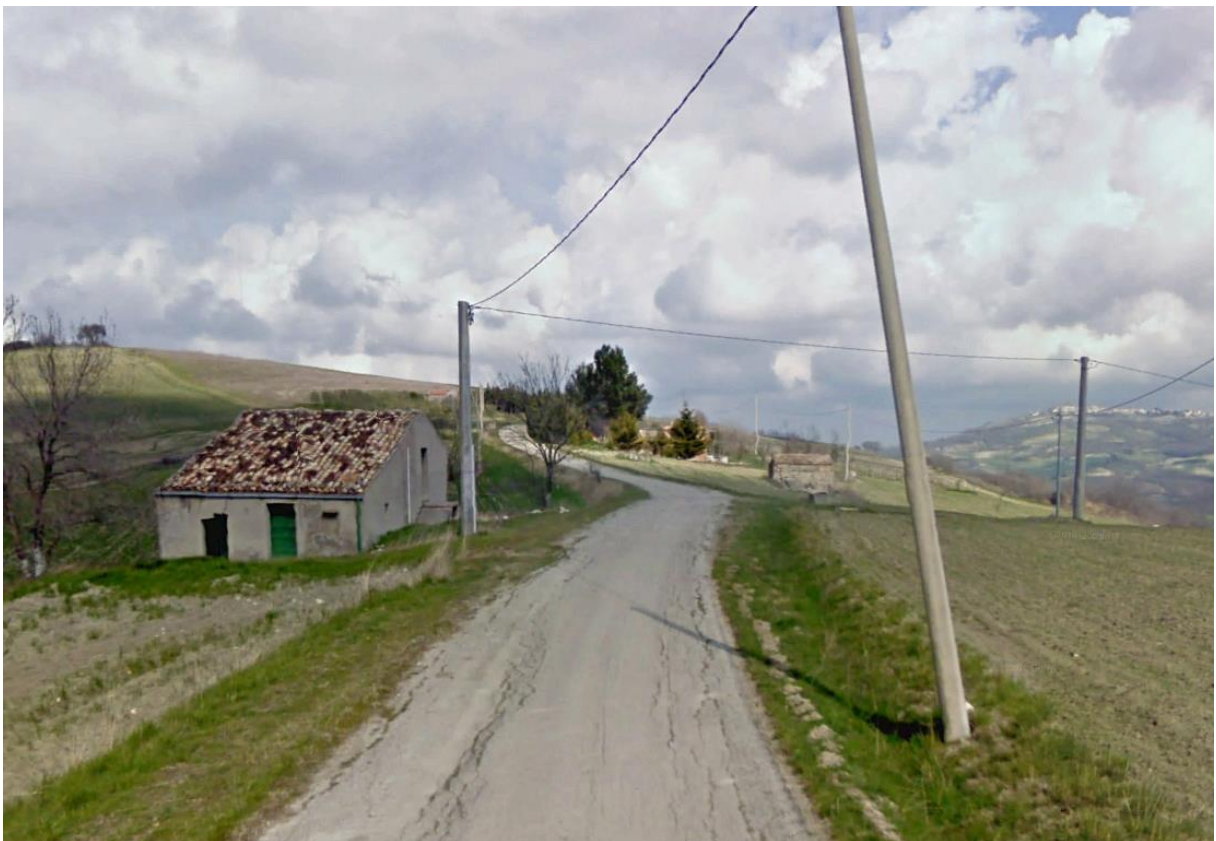
Figura 35. Attraversamento di linea elettrica BT lungo il tracciato di collegamento con le WTG (477980.64 m E, 4635628.60 m N)
