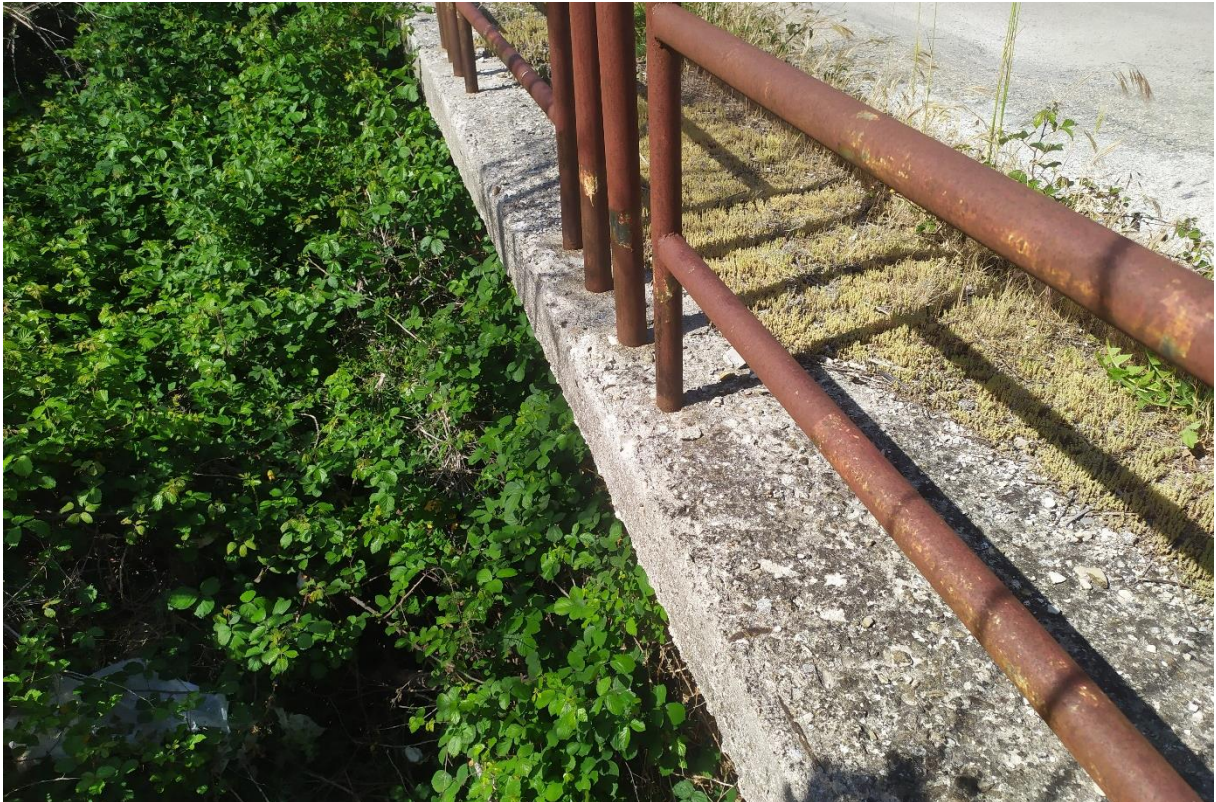
Figura 45. opera di attraversamento in corrispondenza della viabilità esistente per il collegamento con la WTG 1 (475992.01 m E, 4634406.83 m N).
