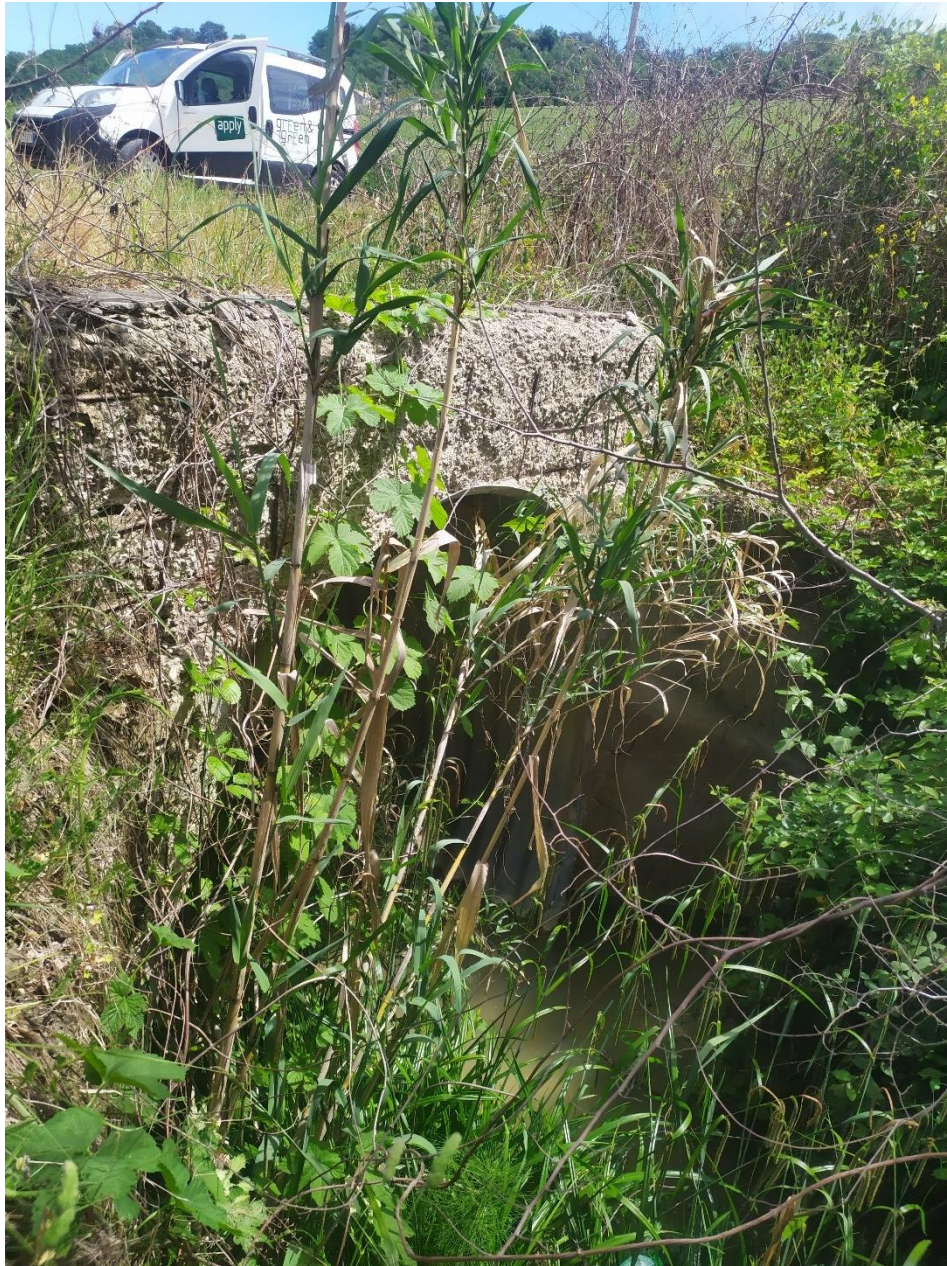
Figura 52. Opera di attraversamento in corrispondenza della viabilità esistente sulla strada provinciale Frentana per la connessione alla stazione multiutente 150/33 kV (483302.84 m E, 4640188.90 m N)
