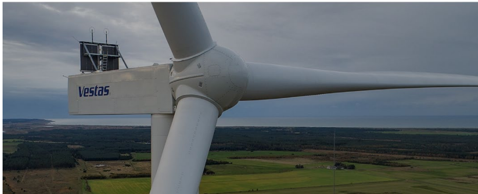
Figura 2: Tipico aerogeneratore Vestas V162-5,6 MW
