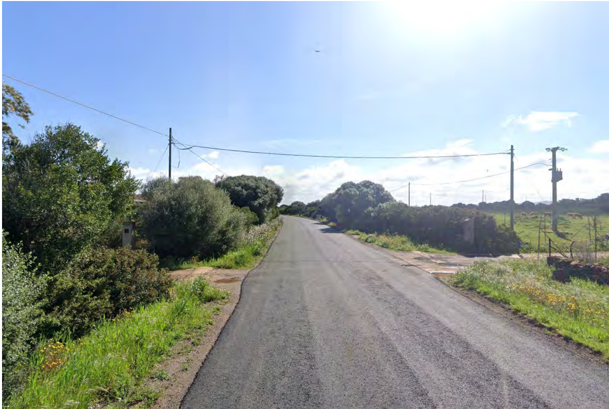
Figura 22 – Tratto D-E - Interferenza aerea
