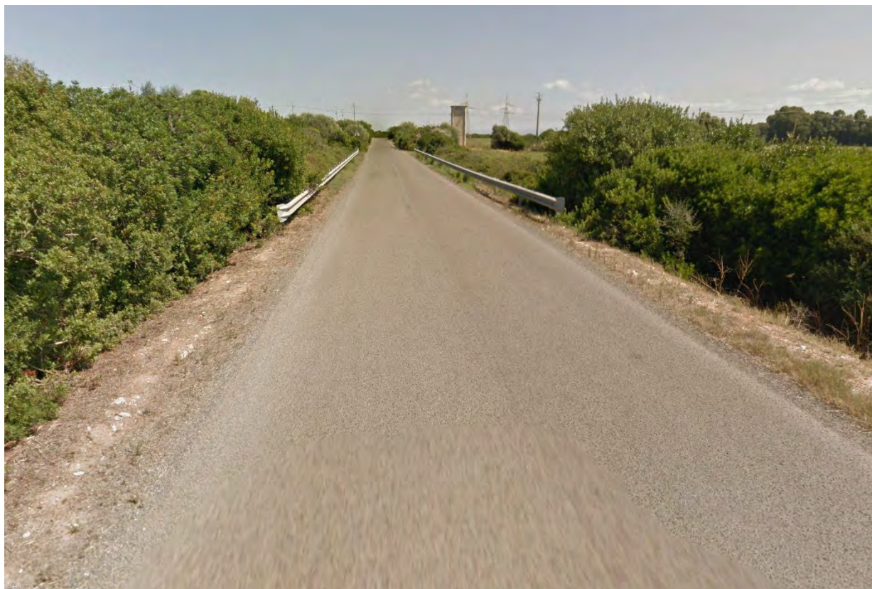
Figura 9 – Tratto B-C - Interferenza superficiale
