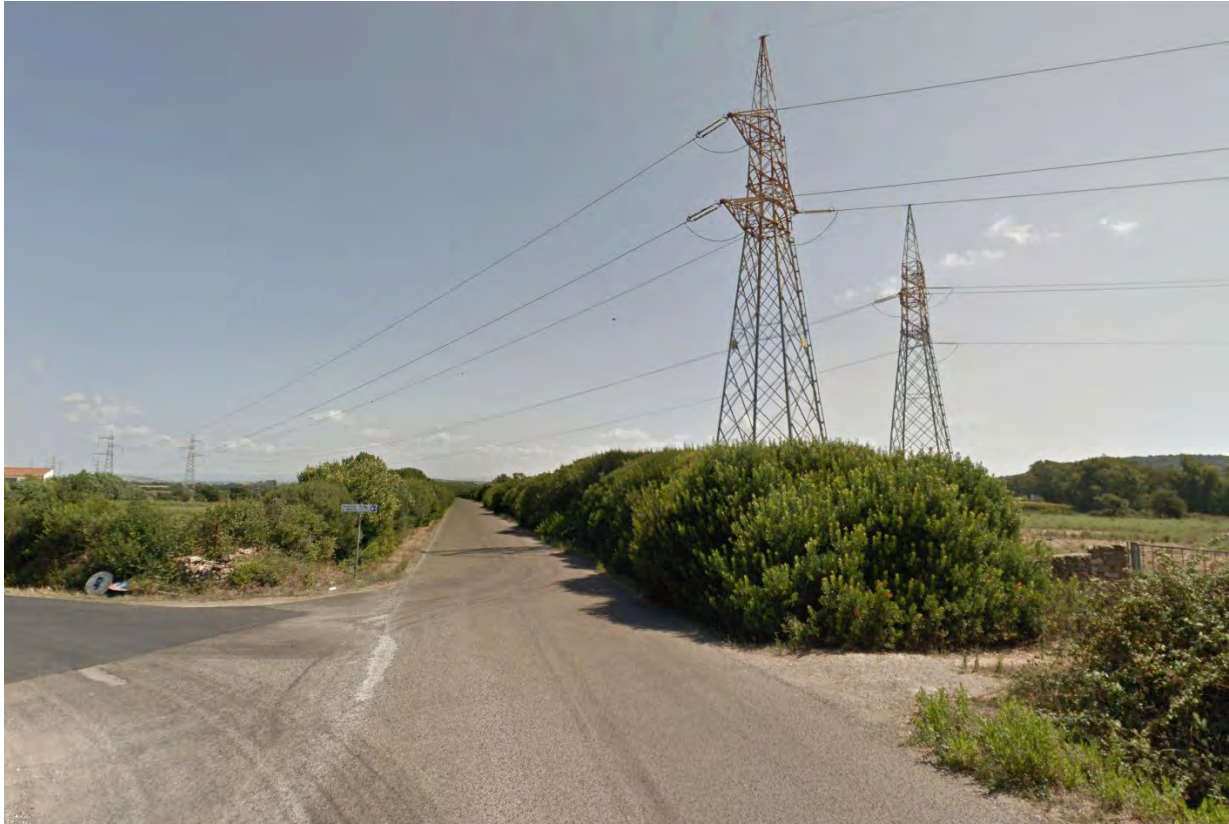
Figura 12 – Tratto B-C - Interferenza aerea
