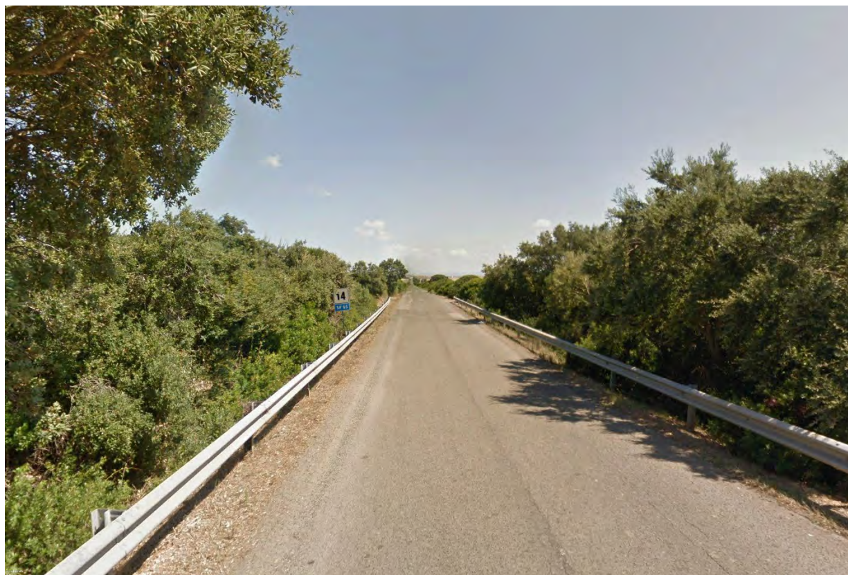
Figura 17 – Tratto B-C - Interferenza superficiale
