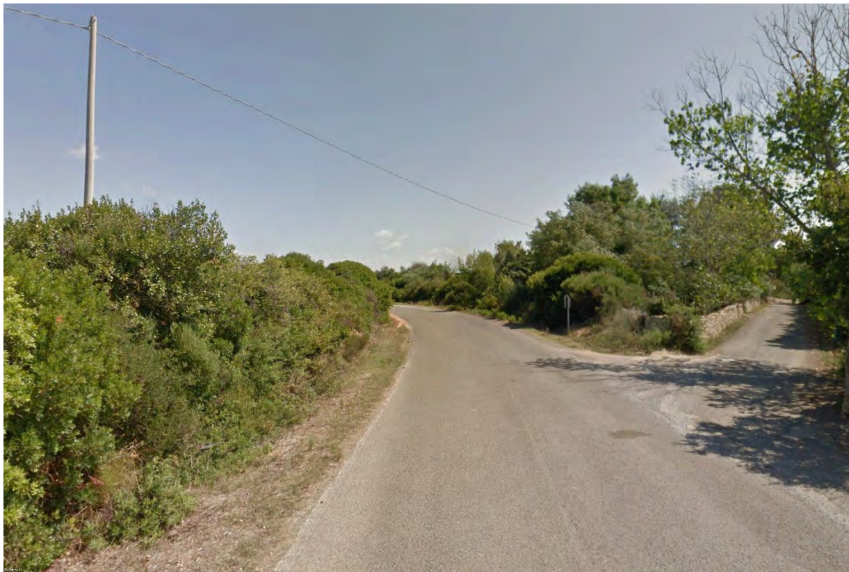
Figura 16 – Tratto B-C - Interferenza aerea
