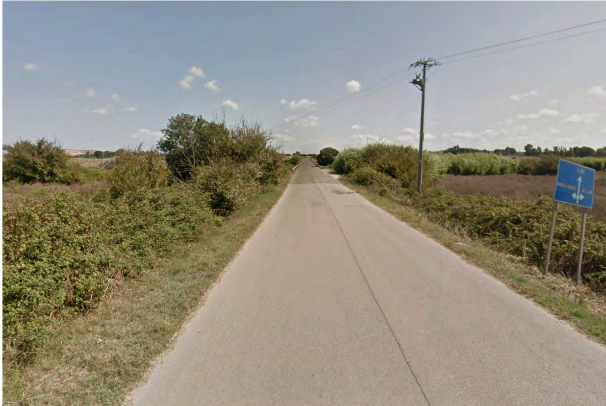
Figura 20 – Tratto C-D Interferenza aerea
