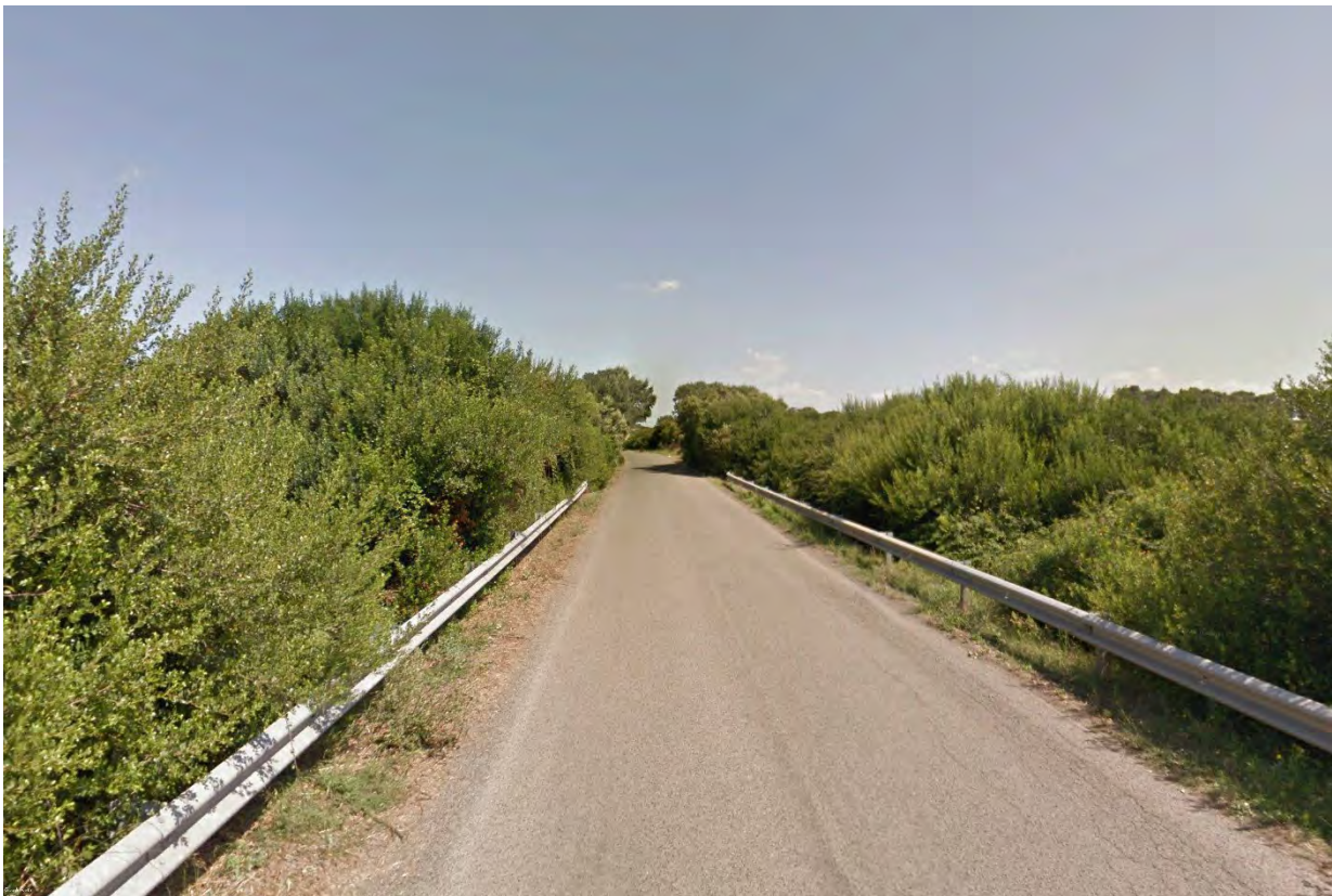
Figura 13 – Tratto B-C - Interferenza superficiale
