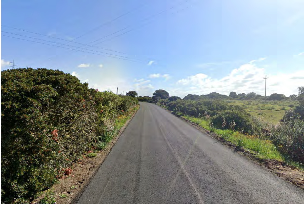
Figura 26 – Tratto D-E - Interferenza aerea
