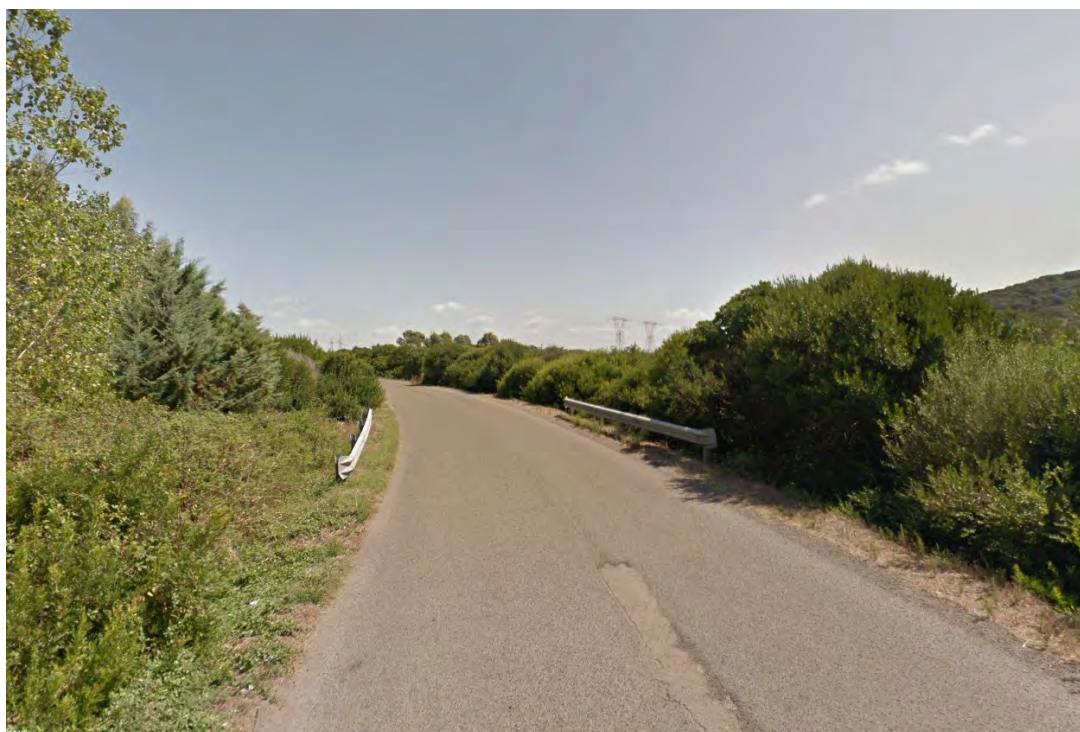
Figura 7 – Tratto B-C - Interferenza superficiale
