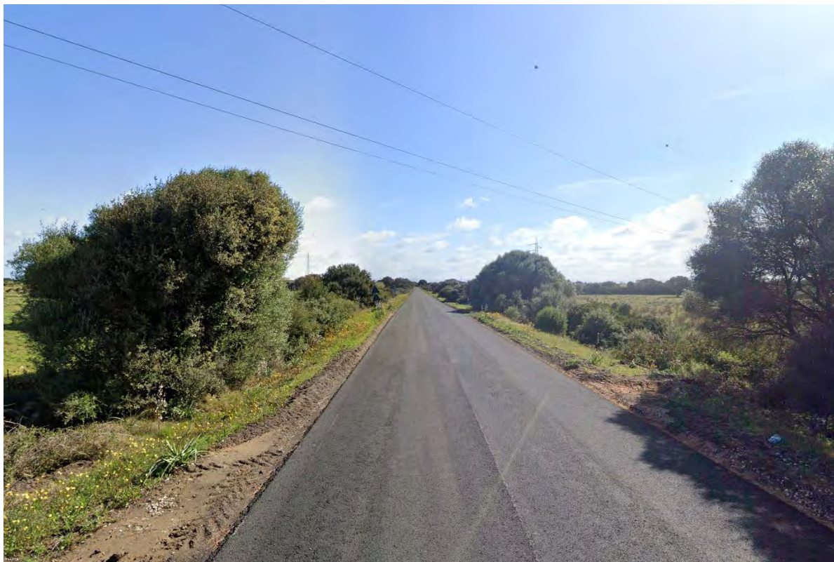
Figura 23 – Tratto D-E - Interferenza aerea
