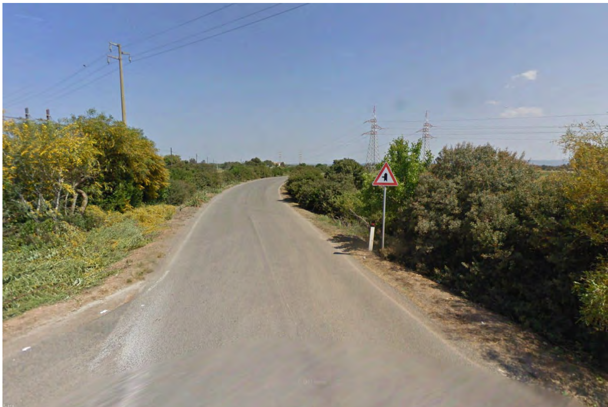
Figura 11 – Tratto B-C - Interferenza aerea
