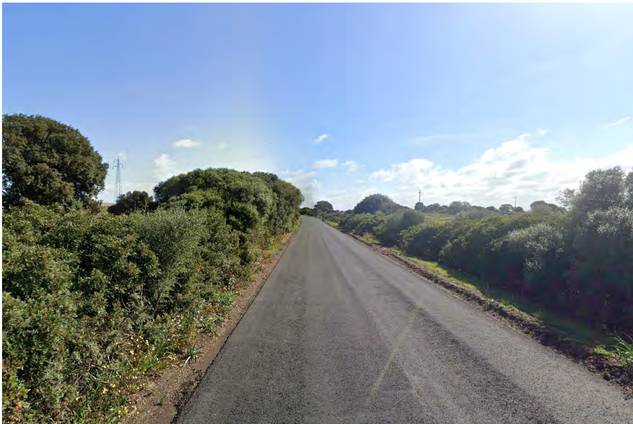
Figura 25 – Tratto D-E - Interferenza aerea
