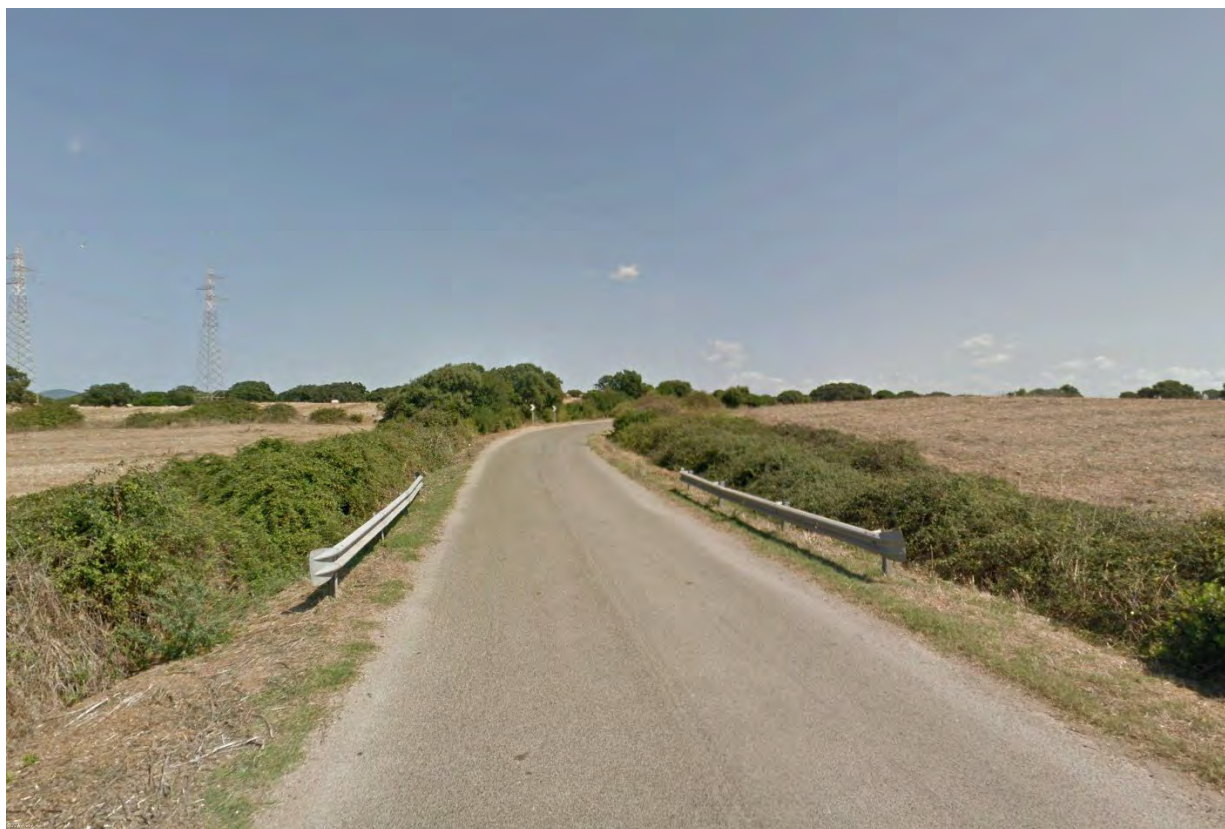
Figura 15 – Tratto B-C - Interferenza superficiale
