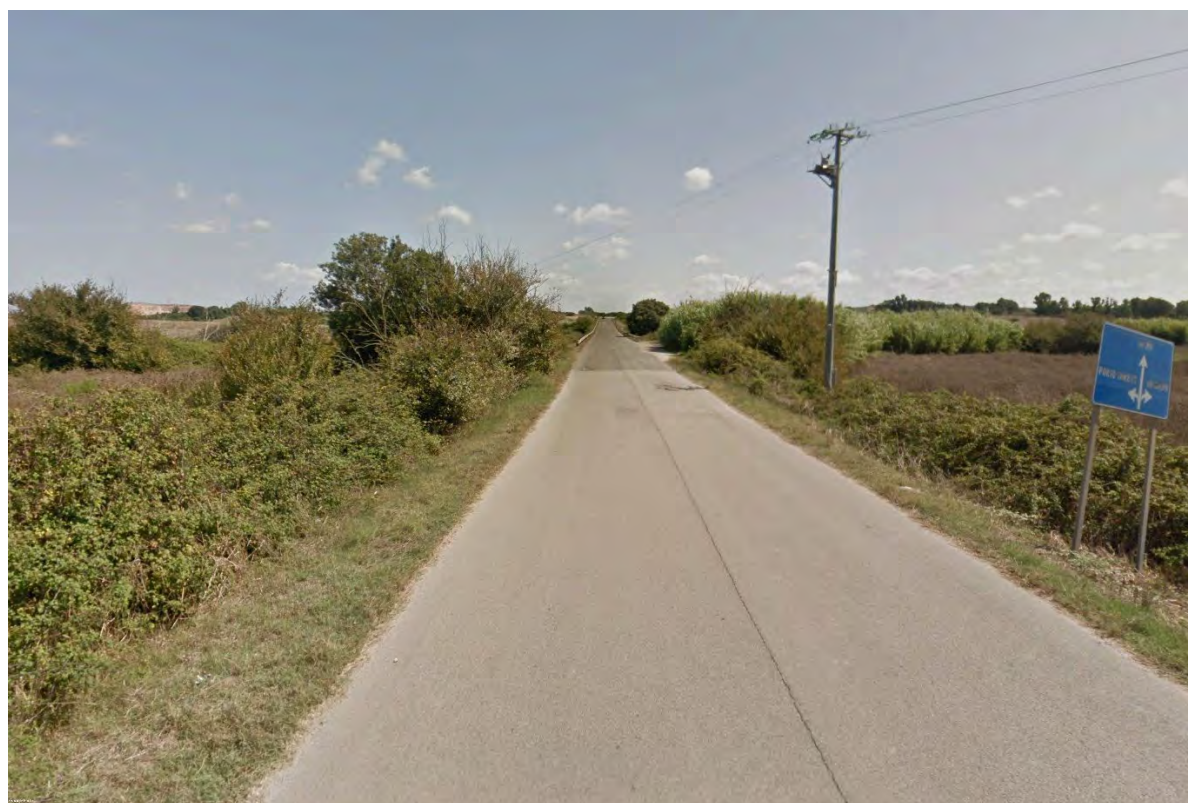
Figura 19 – Tratto C-D Interferenza aerea
