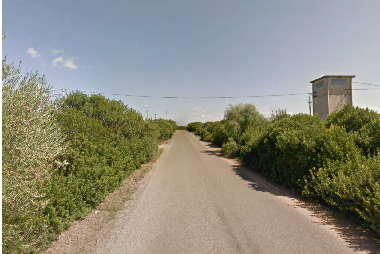
Figura 10 – Tratto B-C - Interferenza aerea
