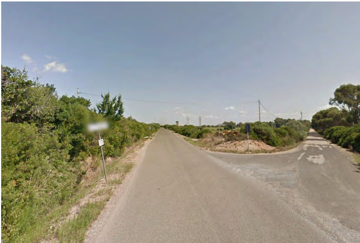
Figura 8 – Tratto B-C - Interferenza superficiale
