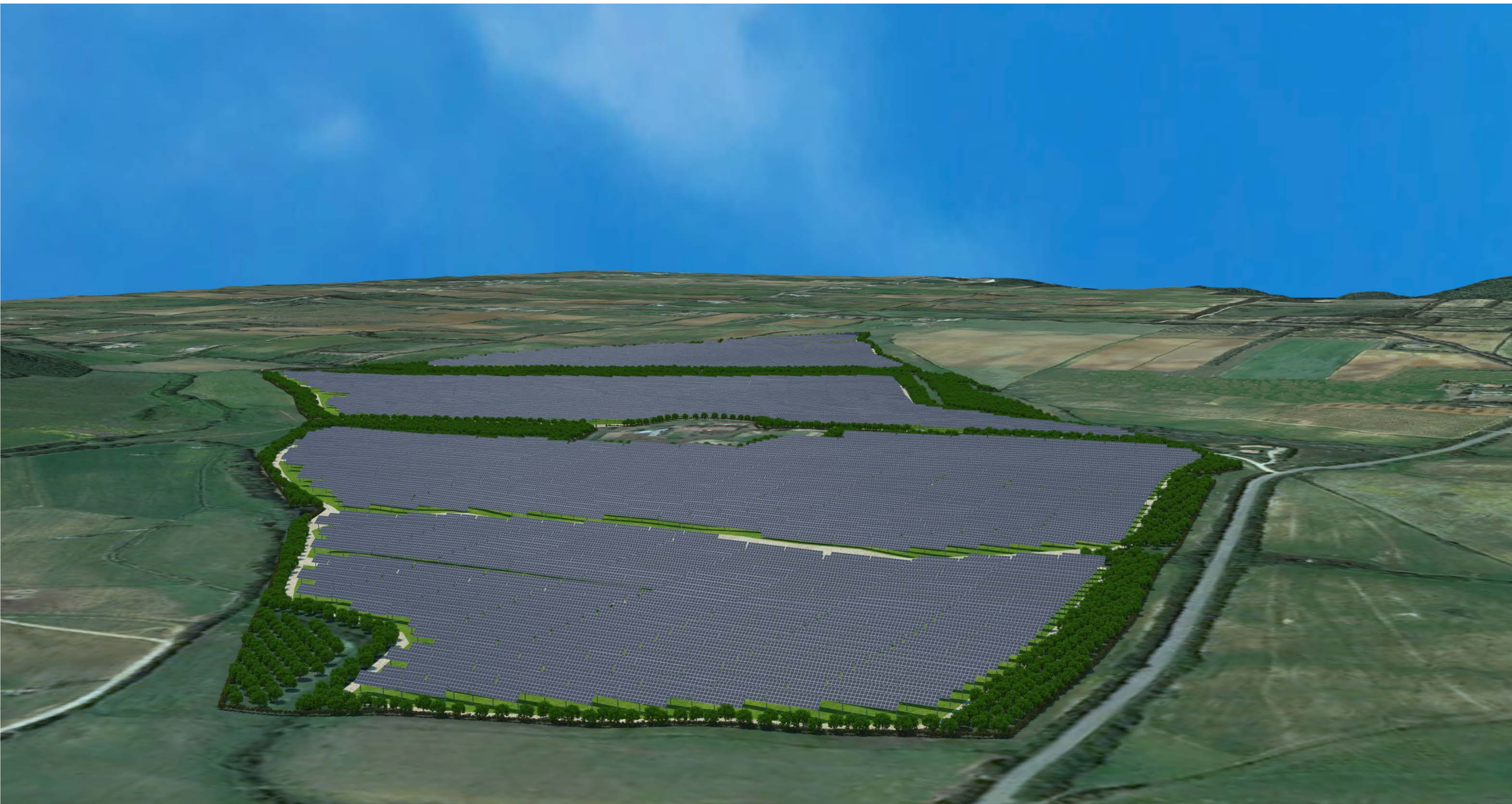
Vista Interna dell'Impianto
