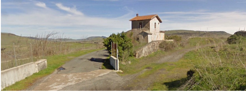
Vista dalla SP 124 in corrispondenza dell'incrocio con il sedime dismesso della ferrovia
