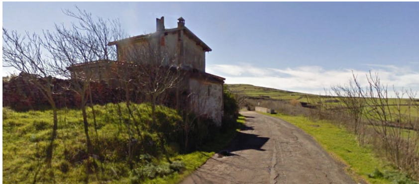
Vista da un punto di osservazione lungo la SP 124 collocato nel primo tratto a nord rispetto alla casa cantoniera
