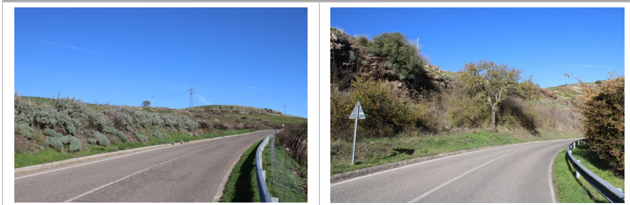
VISTA DELLA SP 8 CON LA SCARPATA LUNGO IL LATO NORD
