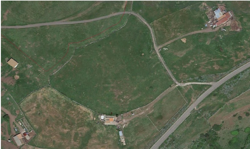
Recettori 8, 9, 10 - edifici agricoli
