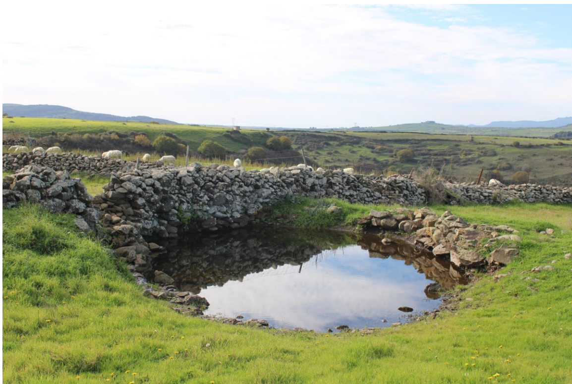
Vista di raccolta dell'acqua piovana in località Lighentosa – Foto Ambiente Italia
