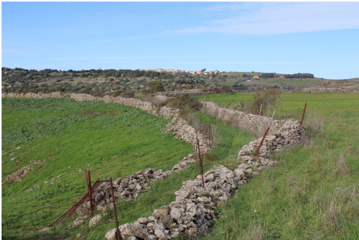
Vista dei muretti in pietra a secco in località Lighentosa con recinzione sovrapposta – Foto Ambiente Italia
