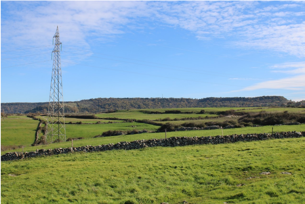
Vista di un traliccio ubicato nella zona centrale del pianoro (foto Ambiente Italia)
