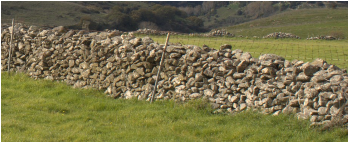
Vista dei muretti in pietra a secco in località Lighentosa con recinzione in affiancamento – Foto Ambiente Italia
