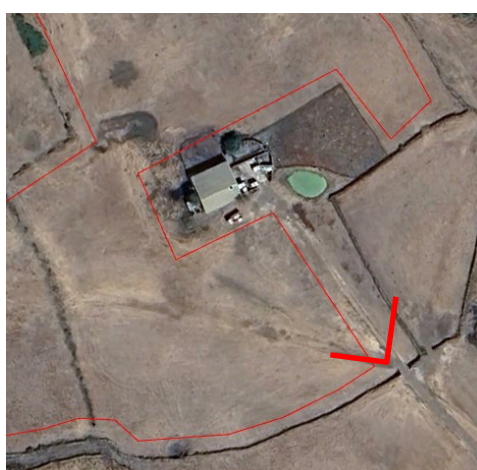
Fabbricato in località Lighentosa – Foto Ambiente Italia
