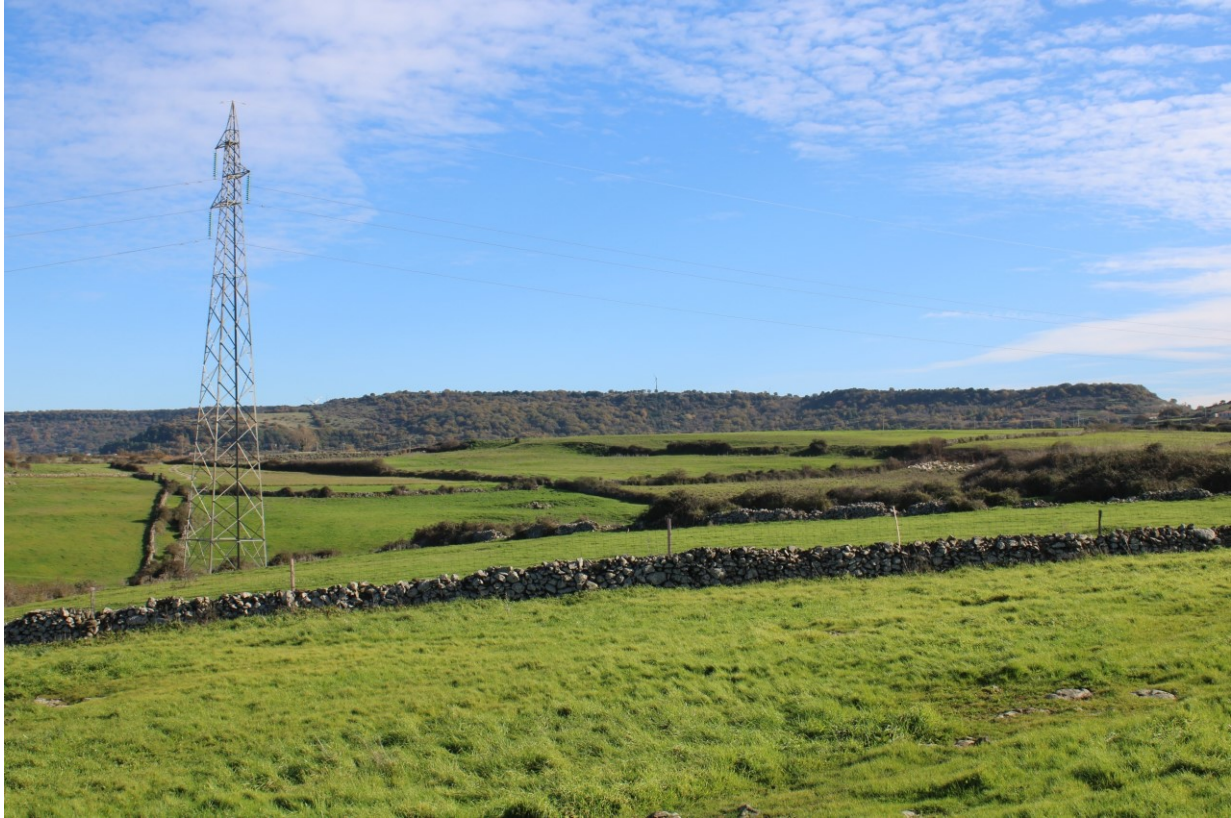
Vista di un traliccio ubicato nella zona centrale del pianoro
