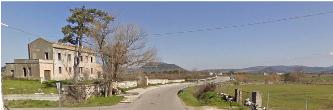
□ SP 131 - Ttratto a sud del ponte
