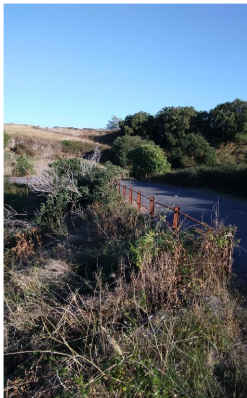
Figura s4: ponte
