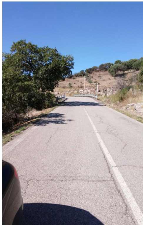
Figura s7: ponte
