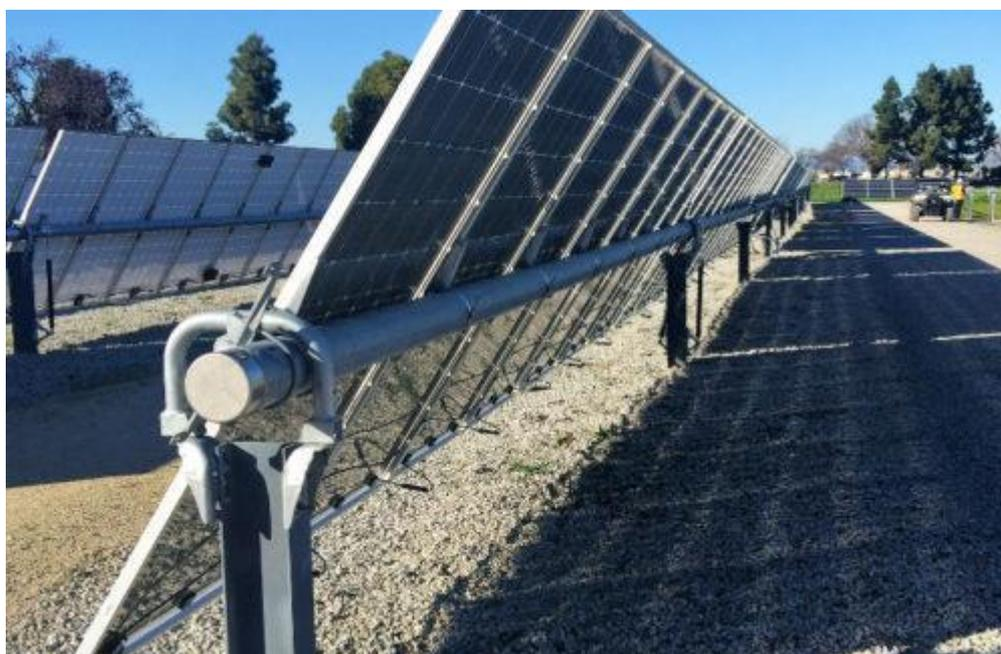
Figura 3.6 - Esempio di struttura di tipo mobile (tracker) monoassiale con configurazione 1p
