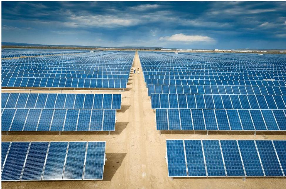
Figura 4.3 - Esempio di struttura di tipo fisso
