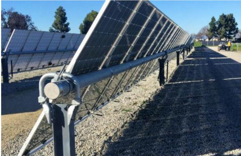
Figura 4.5 - Esempio di struttura di tipo mobile (tracker) monoassiale con configurazione 1p
