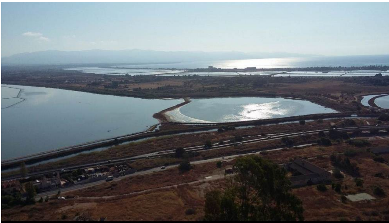
Infrastrutture nei pressi dello Stagno di Santa Gilla.
