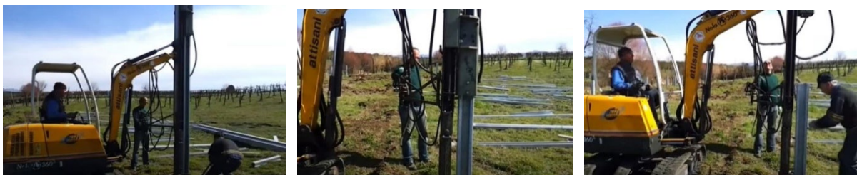
Sequenza fotografica che mostra l'infissione eseguita con battipalo di pali in acciaio ad omega per pannelli fotovoltaici.
