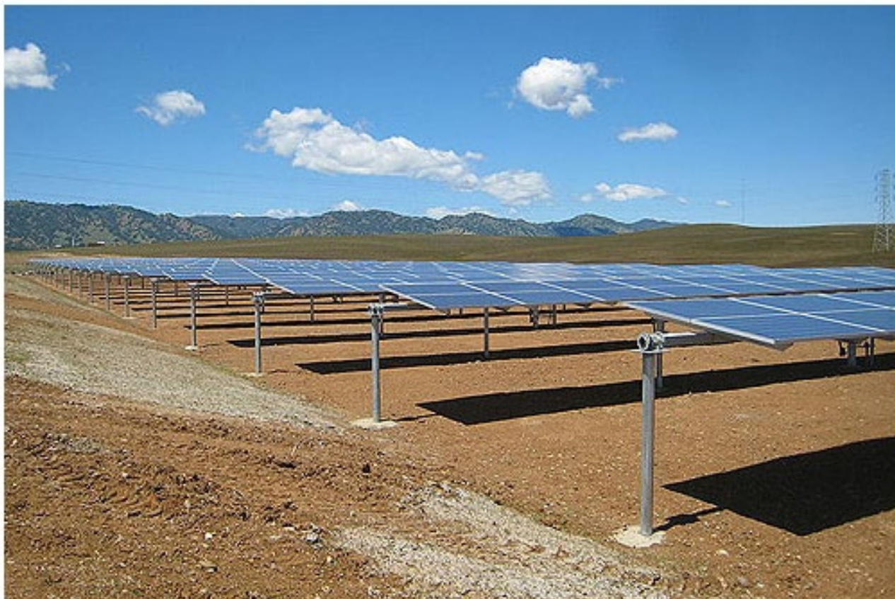
Fig. 15 – Foto tipo trackers monoassiali a inseguimento solare.
