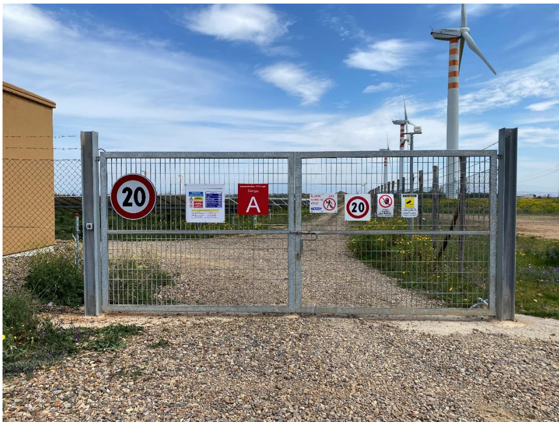
Figura 20: Tipologia cancello d'ingresso
