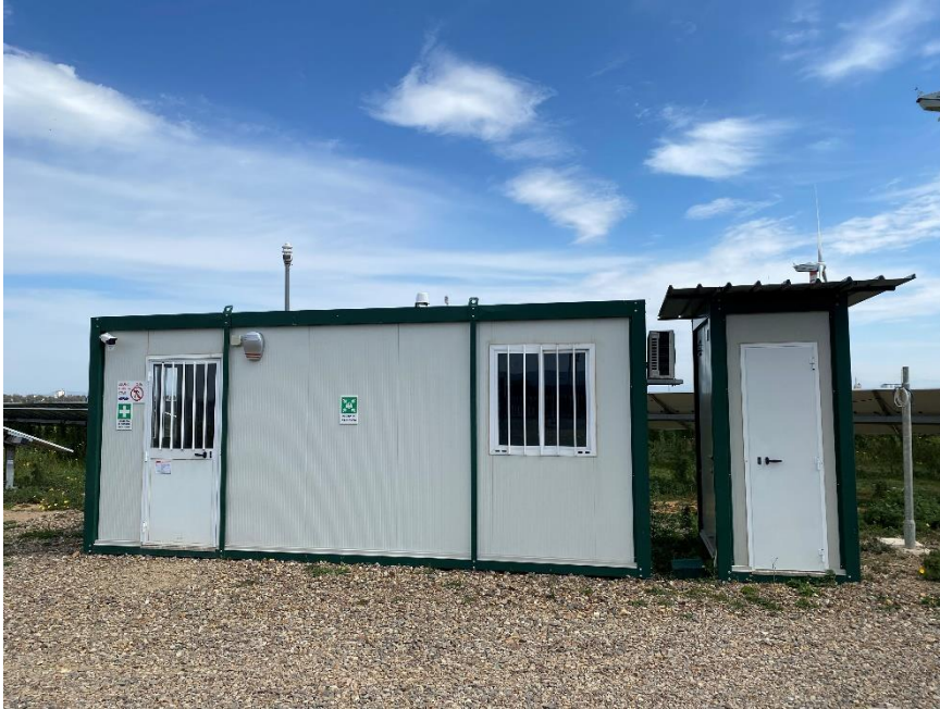
Figura 17: control room e wc chimico
