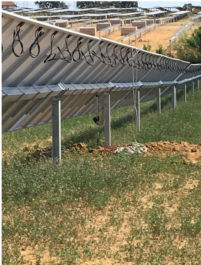
Figure 3-4 – Rappresentazione tipodella struttura di supporto
