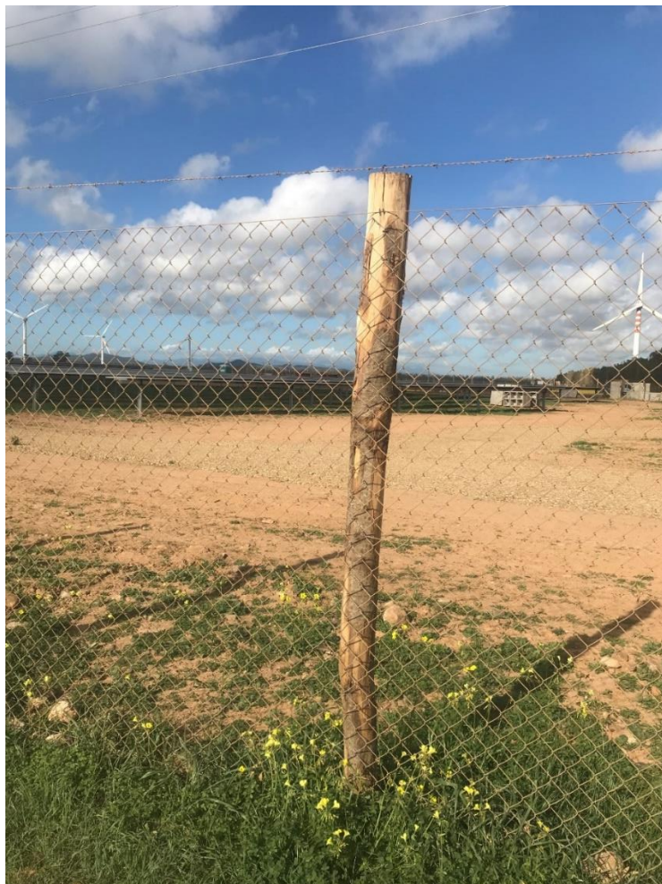
Figura 14: Tipologia di recinzione utilizzata
