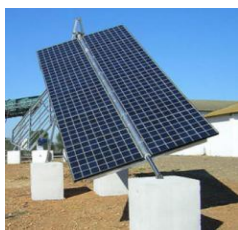
Impianto monoassiale (Inseguitore ad asse polare)
