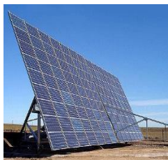
Impianto monoassiale (inseguitore di azimut)
