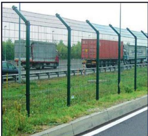
La recinzione continua lungo il perimetro dell'area d'impianto sarà costituita da elementi modulari rigidi in tondini di acciaio elettrosaldati di diverso diametro che conferiscono una particolare resistenza e solidità alla recinzione. Essa offre una notevole protezione da eventuali atti vandalici, lasciando inalterato un piacevole effetto estetico e costituisce un sistema di fissaggio
