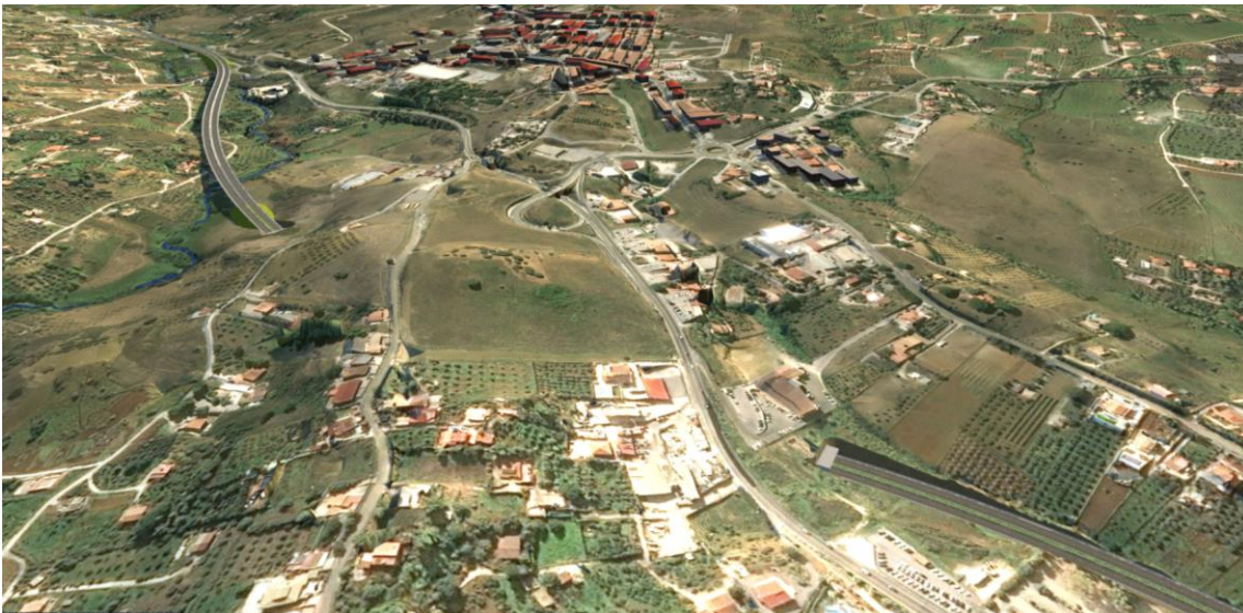
Figura 27: Galleria Bolognetta; al di sopra, lo svincolo esistente tra SP77 e SS121
