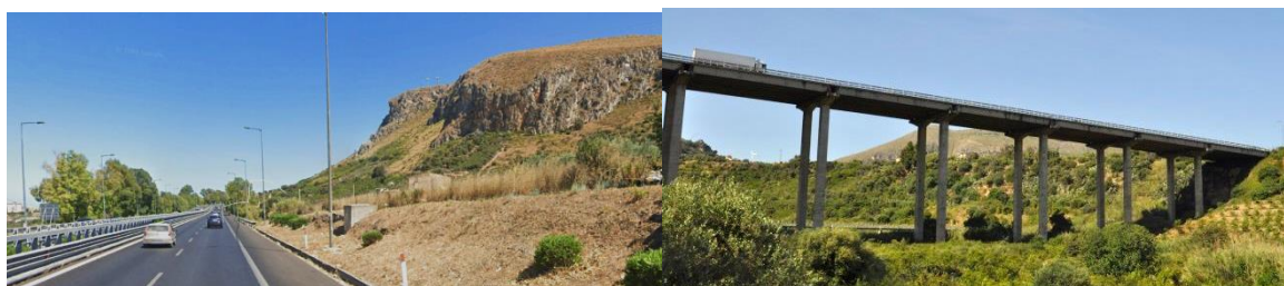
Figura 25. Zona montagnosa a Sud della A19 (sinistra); ponte A19 su fiume Eleuterio (destra).
