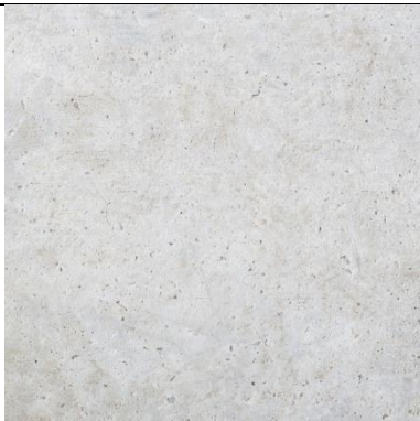
Pile viadotti in cemento
