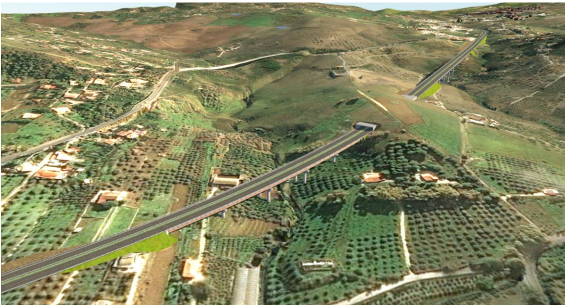
Figura 26: Viadotto 8, Galleria Artificiale Amari e Viadotto 9
