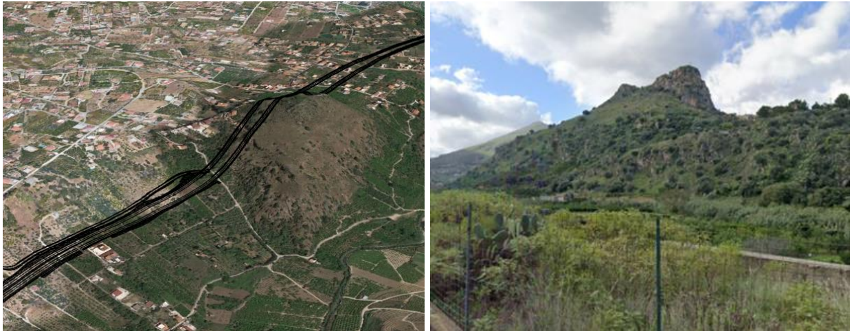
Figura 4-6: Pizzo Cannita. A sinistra, attraversamento del tracciato nel tratto previsto in galleria, a destra immagine dell'area
