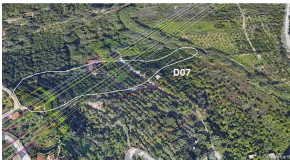
Figura 4-13: Stralcio di foto aerea da Google Earth con ubicazione del dissesto e del tracciato.
