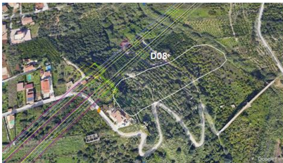
Figura 8-14: Stralcio di foto aerea da Google Earth con ubicazione del dissesto e del tracciato.
