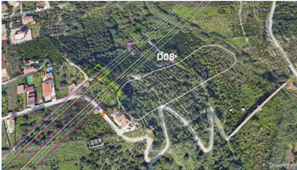
Figura 4-15: Stralcio di foto aerea da Google Earth con ubicazione del dissesto e del tracciato.
