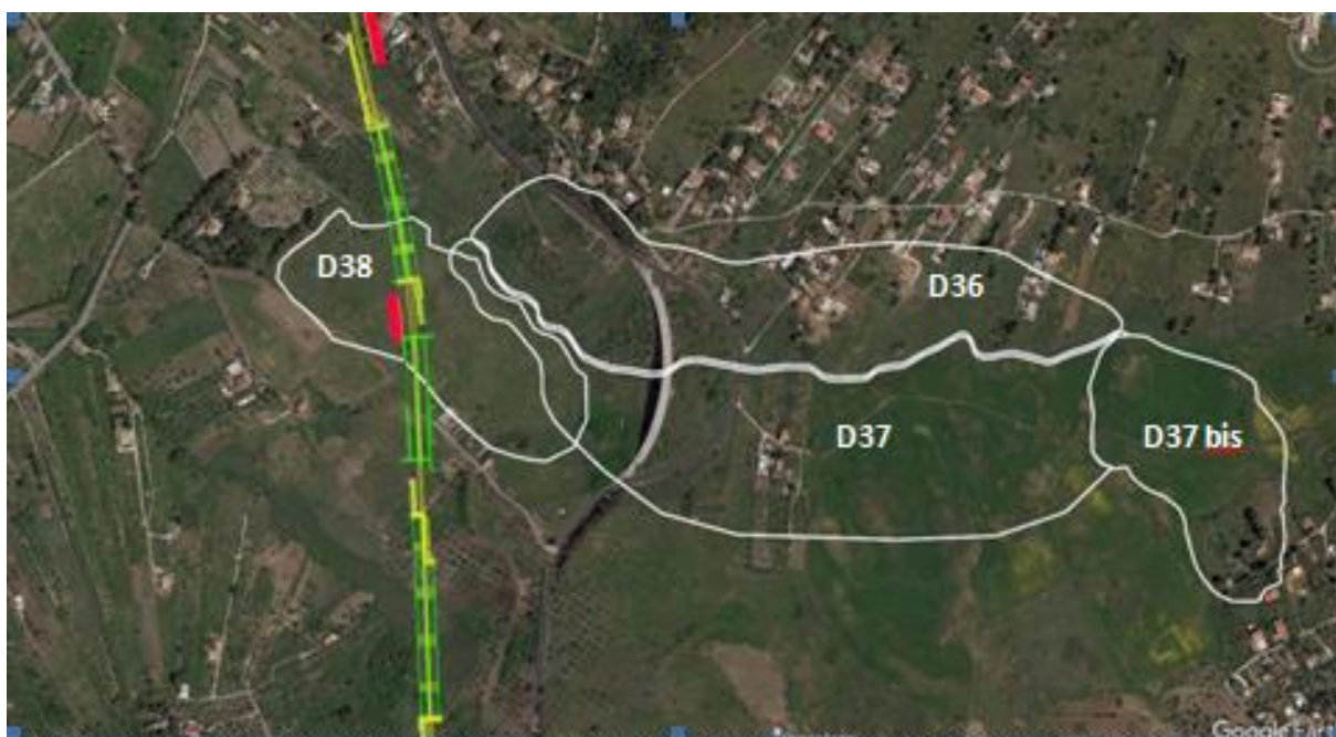
Figura 4-43: Stralcio di foto aerea da Google Earth con ubicazione dei dissesti e del tracciato.
