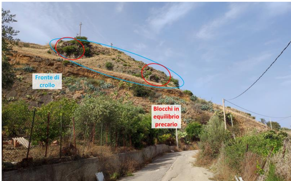
Figura 4-28: Particolare dei dissesti del versante nell'area del dissesto D25
