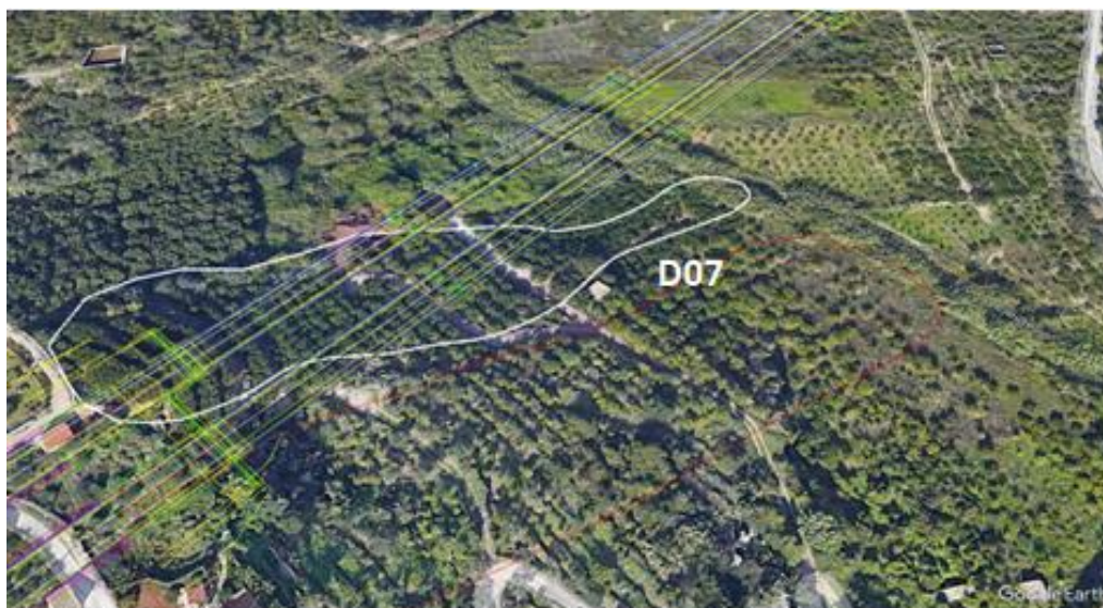
Figura 8-13: Stralcio di foto aerea da Google Earth con ubicazione del dissesto e del tracciato.
