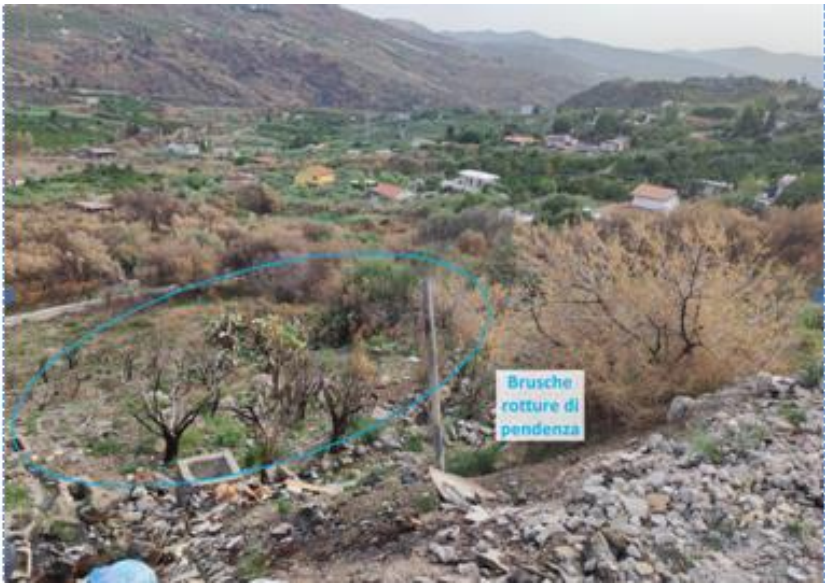
Figura 4-21: Panoramica del versante nell'area del dissesto D17
