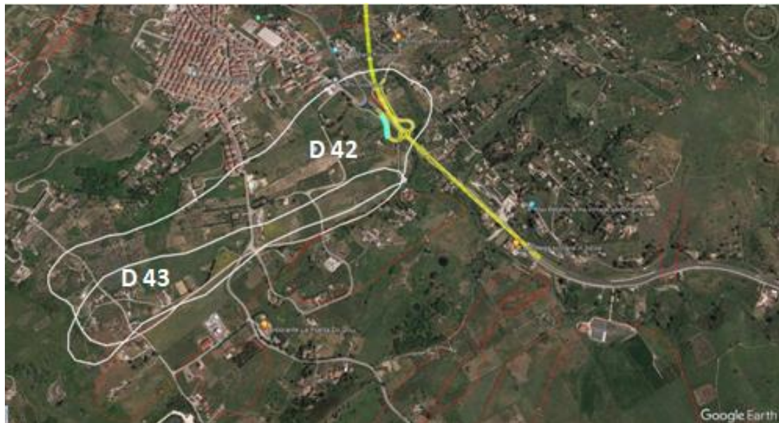
Figura 8-104: Stralcio di foto aerea da Google Earth con ubicazione dei dissesti e del tracciato.
