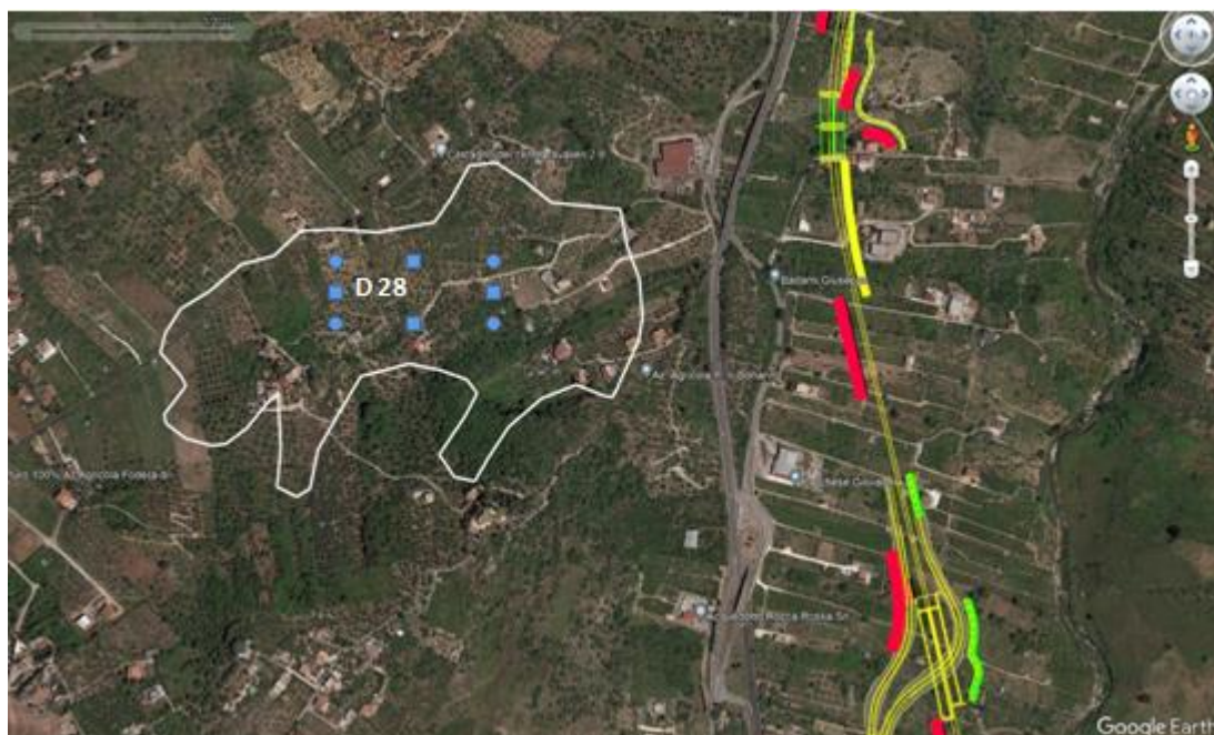
Figura 4-32: Stralcio di foto aerea da Google Earth con ubicazione del dissesto e del tracciato.
