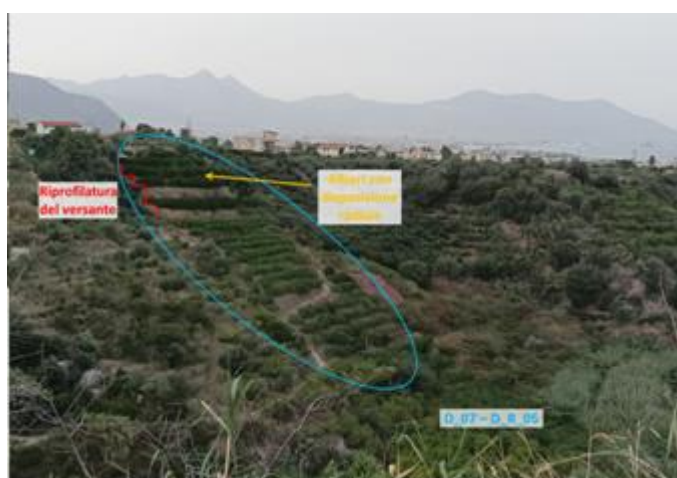
Figura 4-14: Panoramica del versante nell'area del dissesto D07
