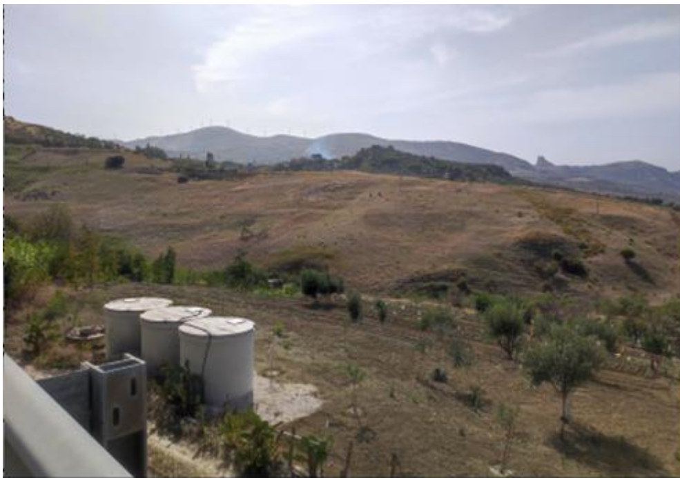
Figura 4-45: Panoramica dei dissesti del versante nell'area del dissesto D38
