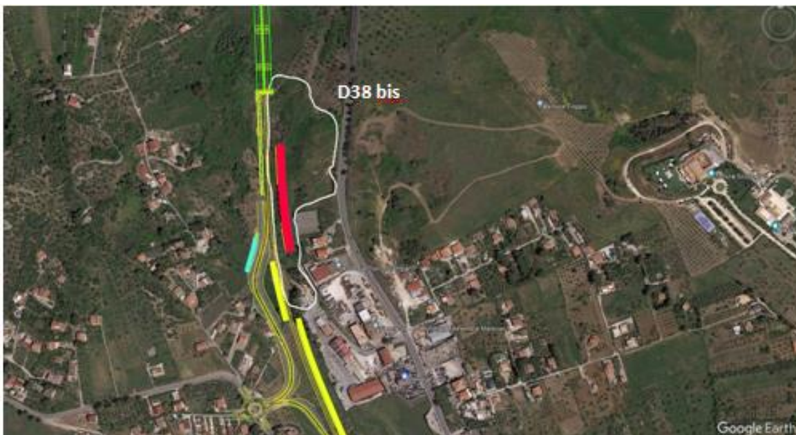
Figura 8-85 Stralcio di foto aerea da Google Earth con ubicazione del dissesto e del tracciato.
