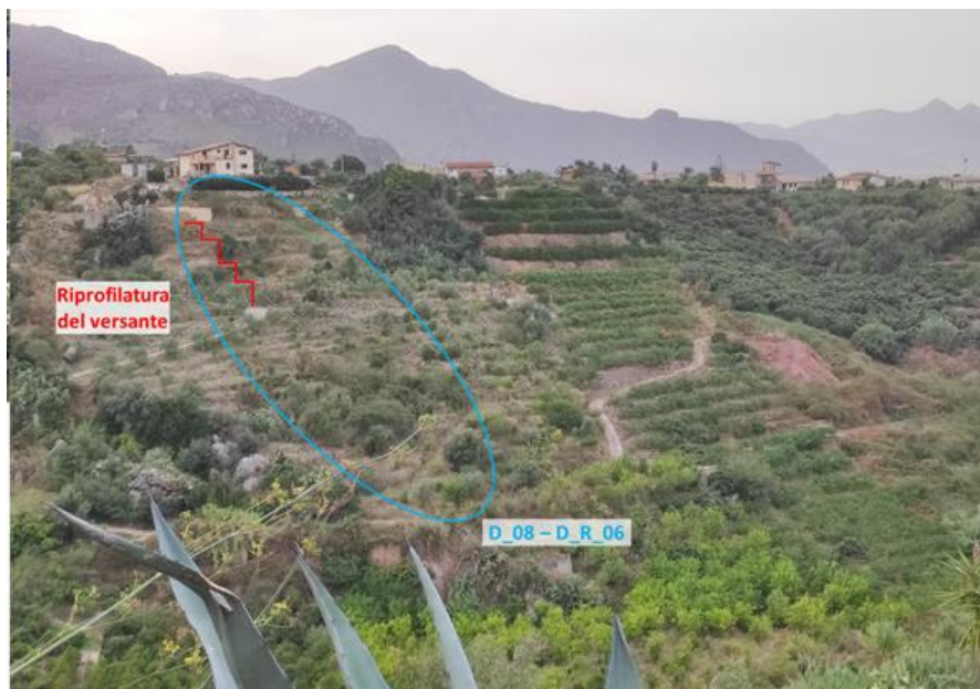
Figura 4-16: Panoramica del versante nell'area del dissesto D07
