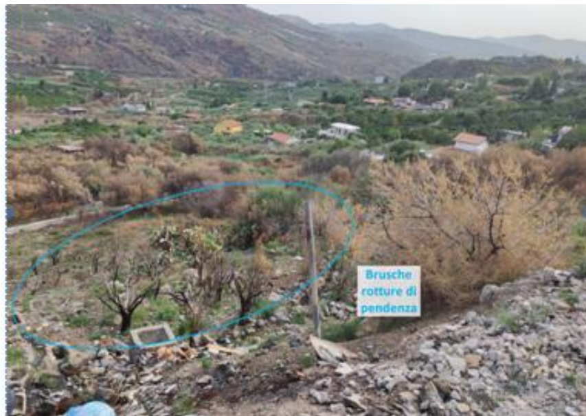
Figura 8-28: Panoramica del versante nell'area del dissesto D17
