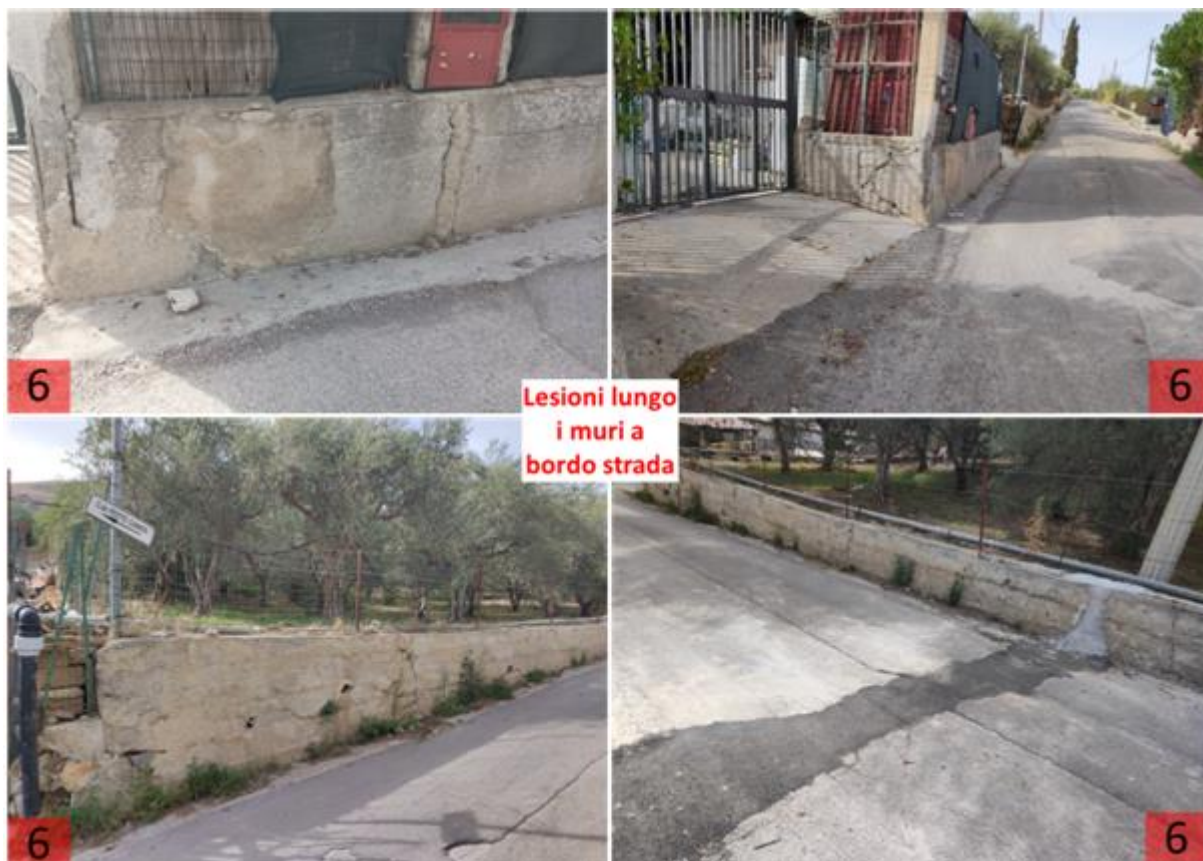
Figura 4-23tris : particolare del dissesto D20 nell'area di corona
