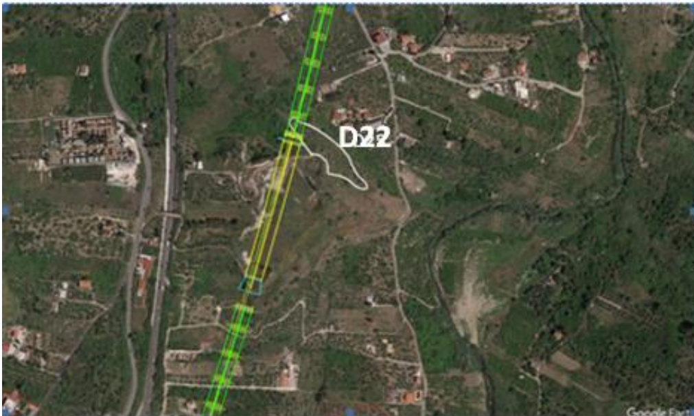
Figura 4-26: Stralcio di foto aerea da Google Earth con ubicazione del dissesto e del tracciato.
