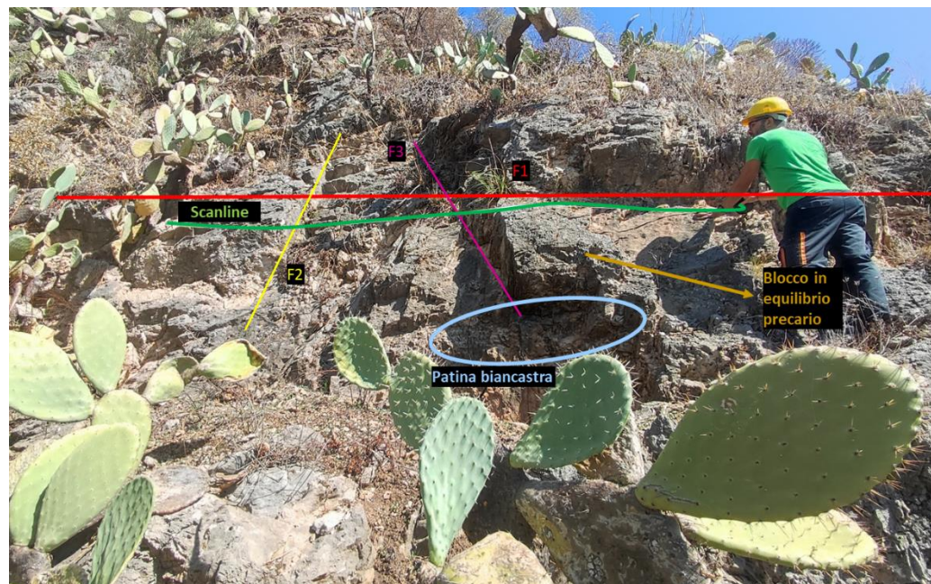
Fig. 7.17 Vista della Scan Line del rilievo geo-meccanico Stop 3.
