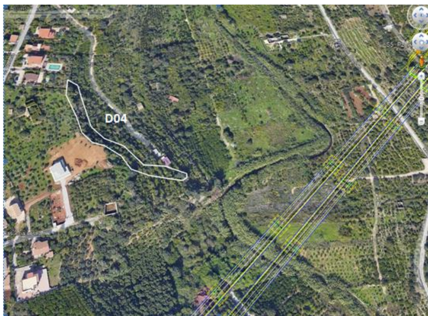
Figura 4-9: Stralcio di foto aerea da Google Earth con ubicazione del dissesto e del tracciato.
