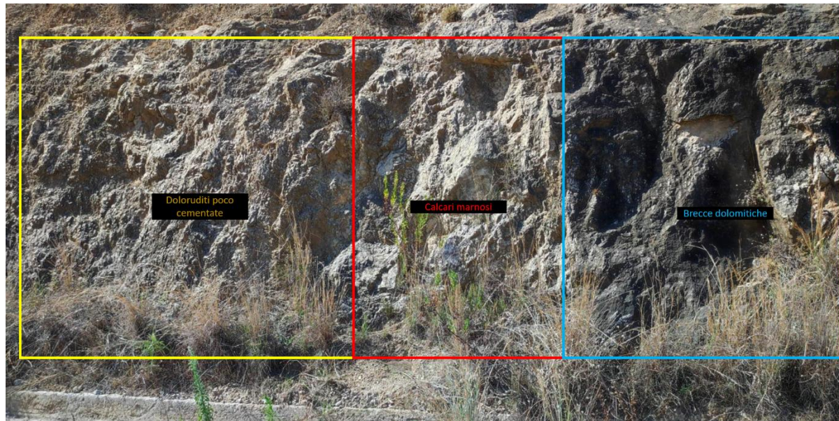
Fig. 7.11 Particolare rilievo geo-meccanico Stop 1. Brecce dolomitiche massive
