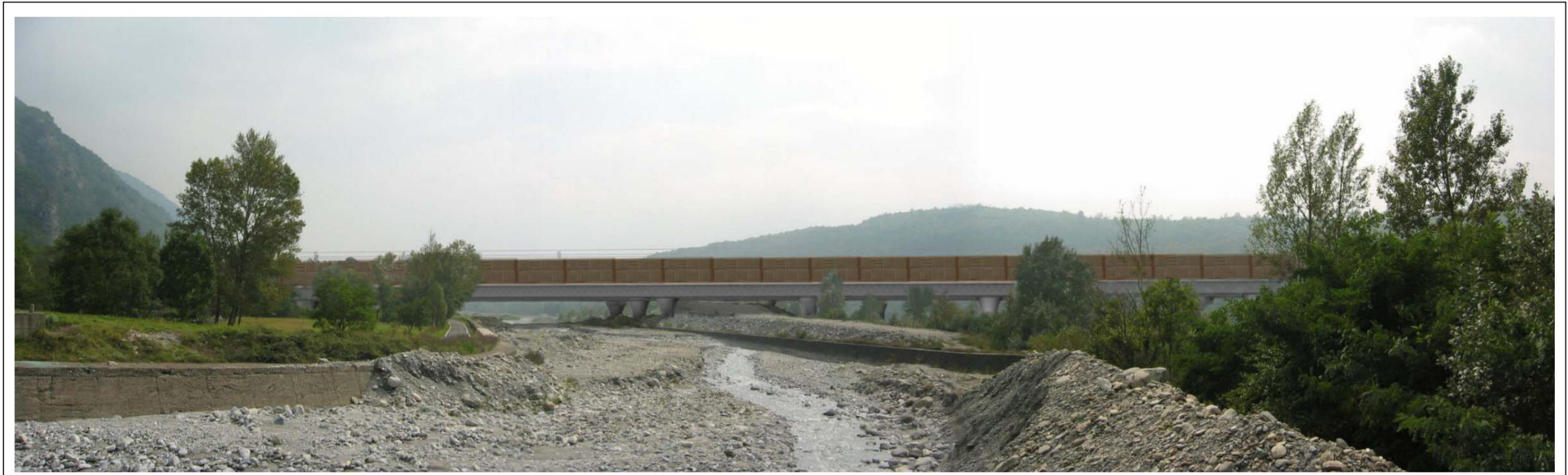
Val Cenischia. Vista dal ponte sul Cenischia della strada comunale per Monpantero fotosimulazione di ingombro volumetrico sul paesaggio (ipotesi Italferr con pilastri/pulvini, cassone e barriere fonoassorbenti in legno)
