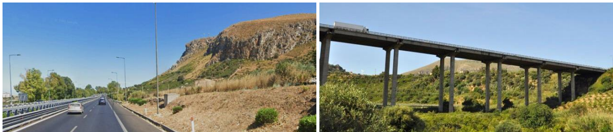
Figura 2-9 Zona montagnosa a Sud della A19 (sinistra); ponte A19 su fiume Eleuterio (destra).
