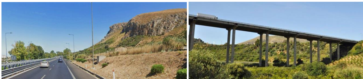
Figura 1-11 Zona montagnosa a Sud della A19 (sinistra); ponte A19 su fiume Eleuterio (destra).
