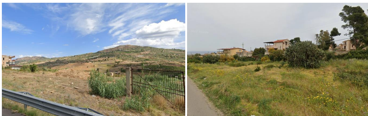
Figura 1-36 Aree di cantiere deposito: a sinistra DEP04, a destra DEP05
