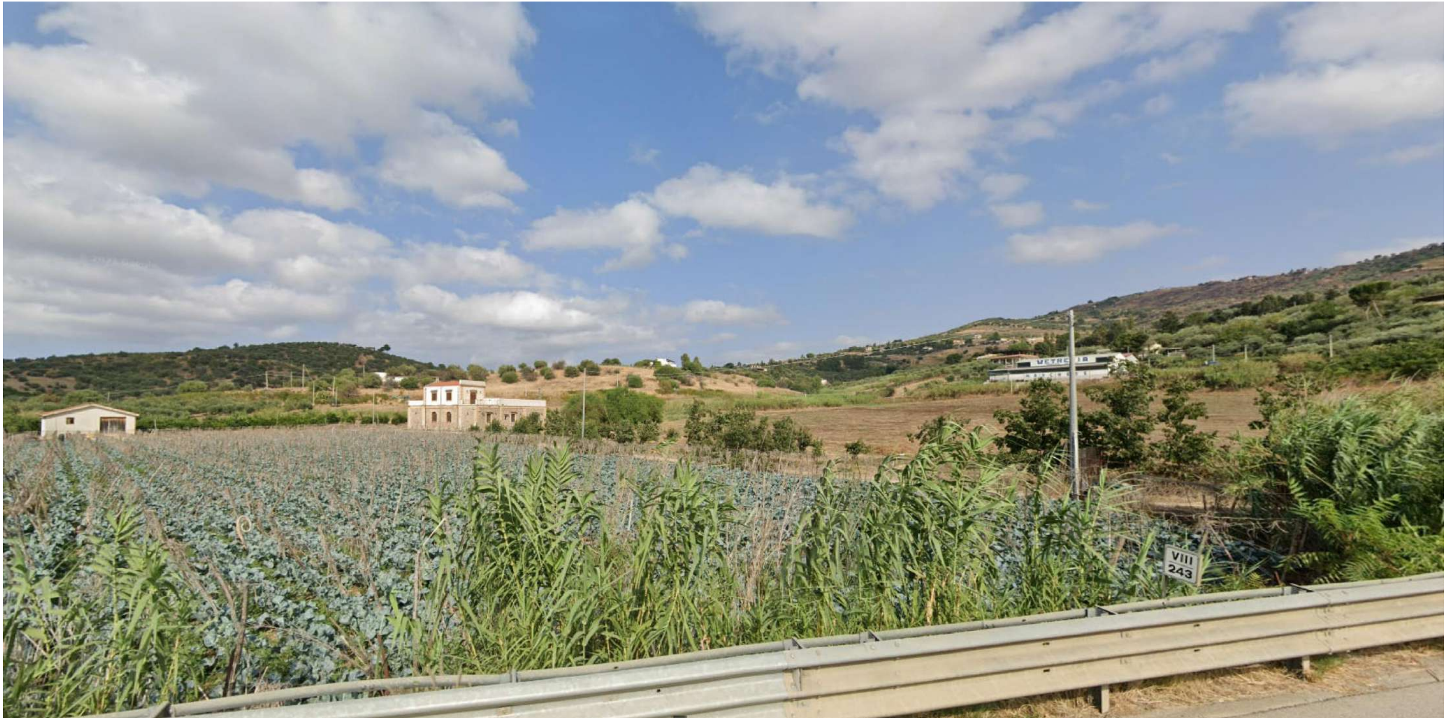
Punto 22: Vista da SS121 in direzione nord-est. Il tracciato di progetto, proveniente da nord, esce dal tratto in galleria in corrispondenza della collina al centro dell'immagine, attraversando l'area agricola a destra dell'immagine con il viadotto VI10 "Feotto". L'edificio in secondo piano è un'antica masseria, denominata Casa Savona. Il punto di vista fotografico ricade nella fascia di rispetto del fiume Eleuterio, vincolato ai sensi dell'art. 142 D. Lgs. 42/2004 comma 1 lett. c).
