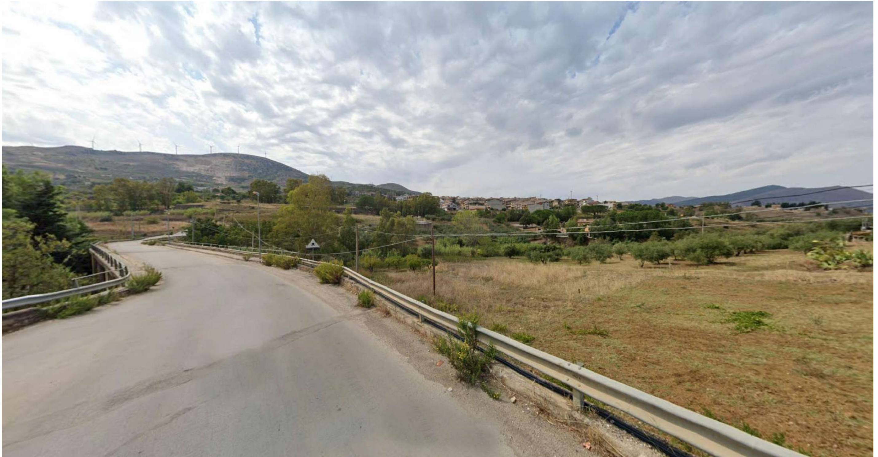
Punto 34: vista da via Baucina in direzione dello svincolo di progetto. La strada di progetto, proveniente da destra della foto con una soluzione in viadotto, attraversa il fiume Milicia proseguendo in secondo piano in direzione di Villafrati. Sul vallone del Milicia si affaccia l'abitato di Bolognetta. Sia il punto di vista fotografico che il viadotto di progetto, ricadono nella fascia di rispetto del fiume Milicia, vincolato ai sensi dell'art. 142 D. Lgs. 42/2004 comma 1 lett. c).
