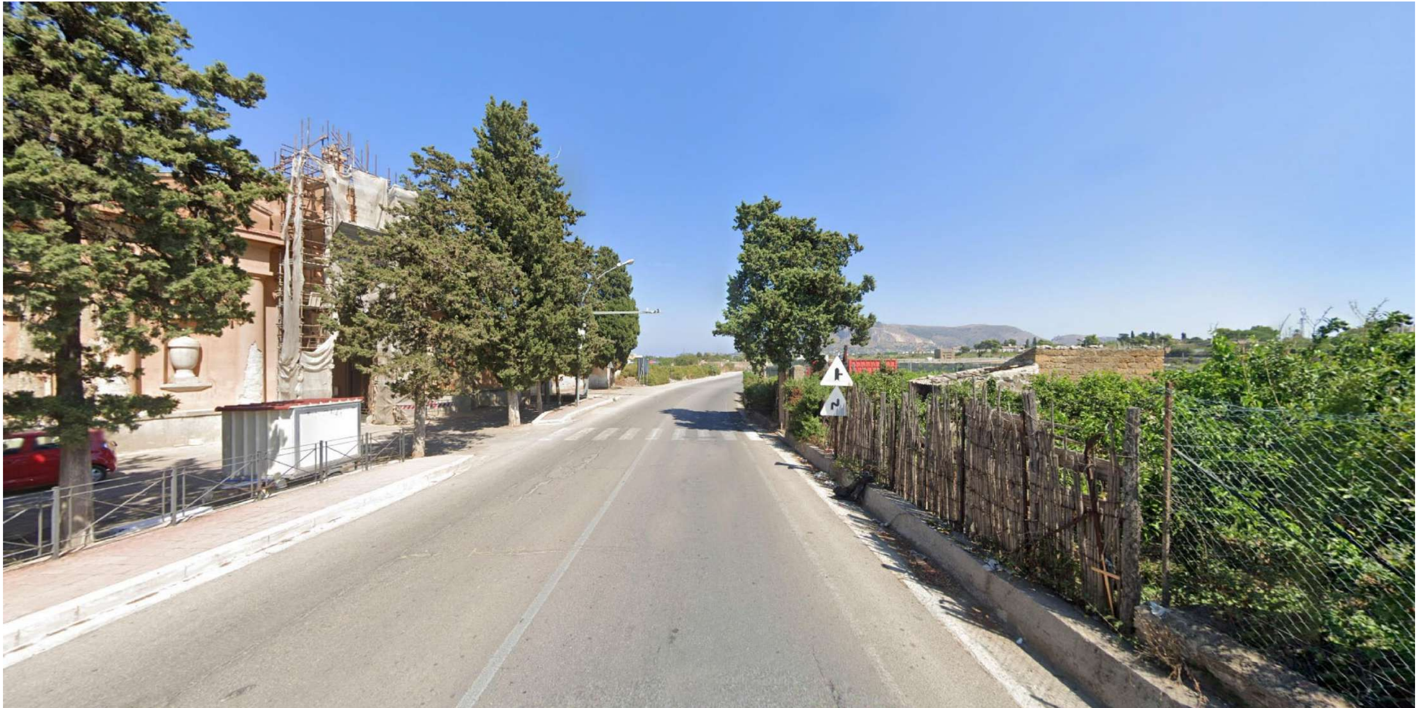
Punto 1: visuale lungo SS113 in direzione dell'intervento. L'inizio dell'intervento è caratterizzato da una nuova rotatoria posta al confine tra i comuni di Ficarazzi e Bagheria: tale intervento, così come tutta la tratta che attraversa il comune di Bagheria, ricade all'interno del bene paesaggistico "Aree contermini, le ville storiche" tutelato ai sensi dell'art.136 D.Lgs. 42/2004 "Immobili e aree di notevole interesse pubblico".
