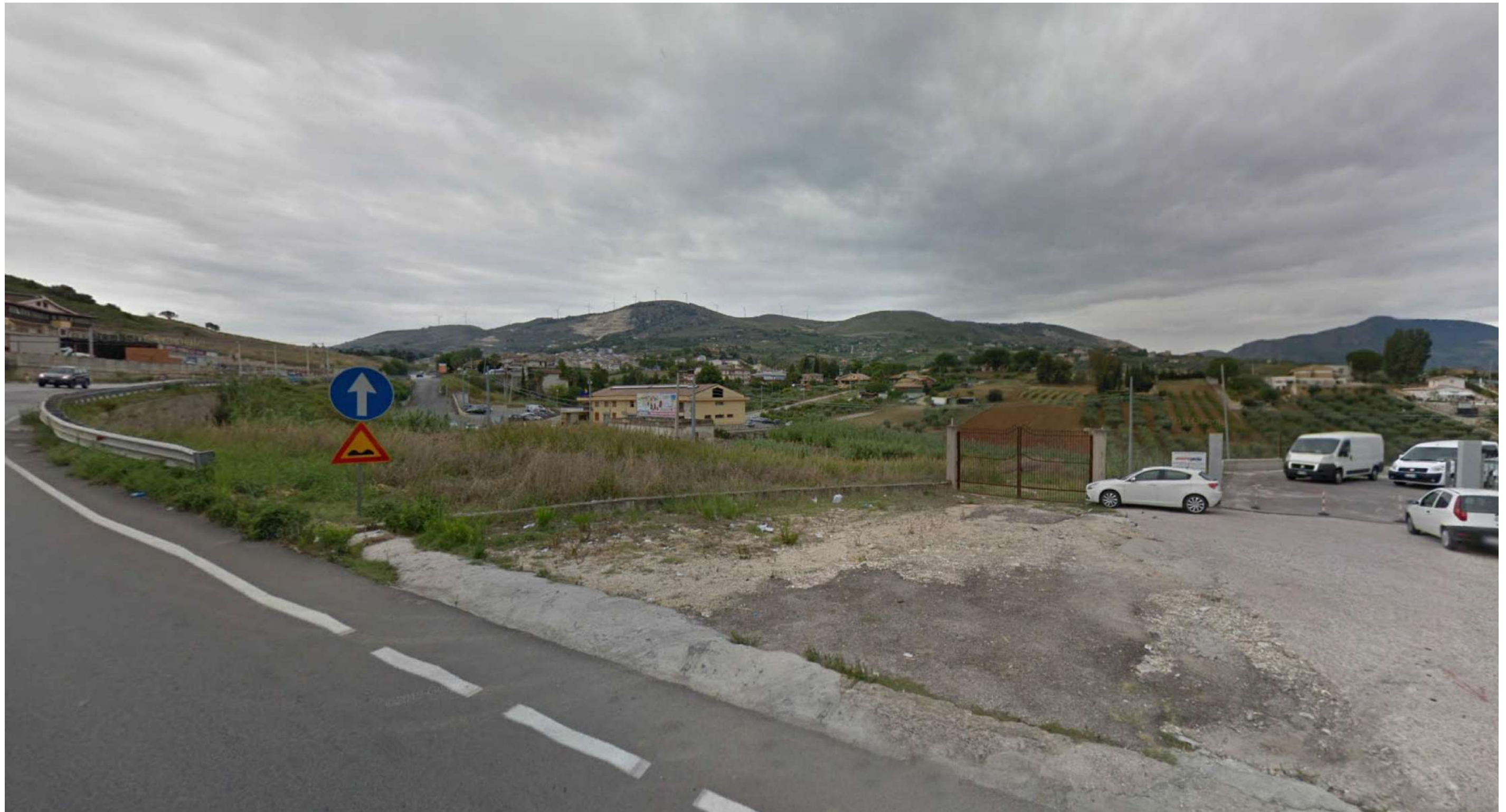
Punto 30: vista dalla SS121 in direzione sud- sud-ovest. L'infrastruttura di progetto, proveniente da nord (a destra dell'immagine) presenta alternanza di trincea/rilevato/muro prima di entrare in galleria naturale (GN03 "Bolognetta"). L'ambito risulta urbanizzato anche se permangono alcuni caratteri agricoli legati alle colture degli ulivi e degli agrumi, connessi ai poderi del tessuto residenziale sparso.
