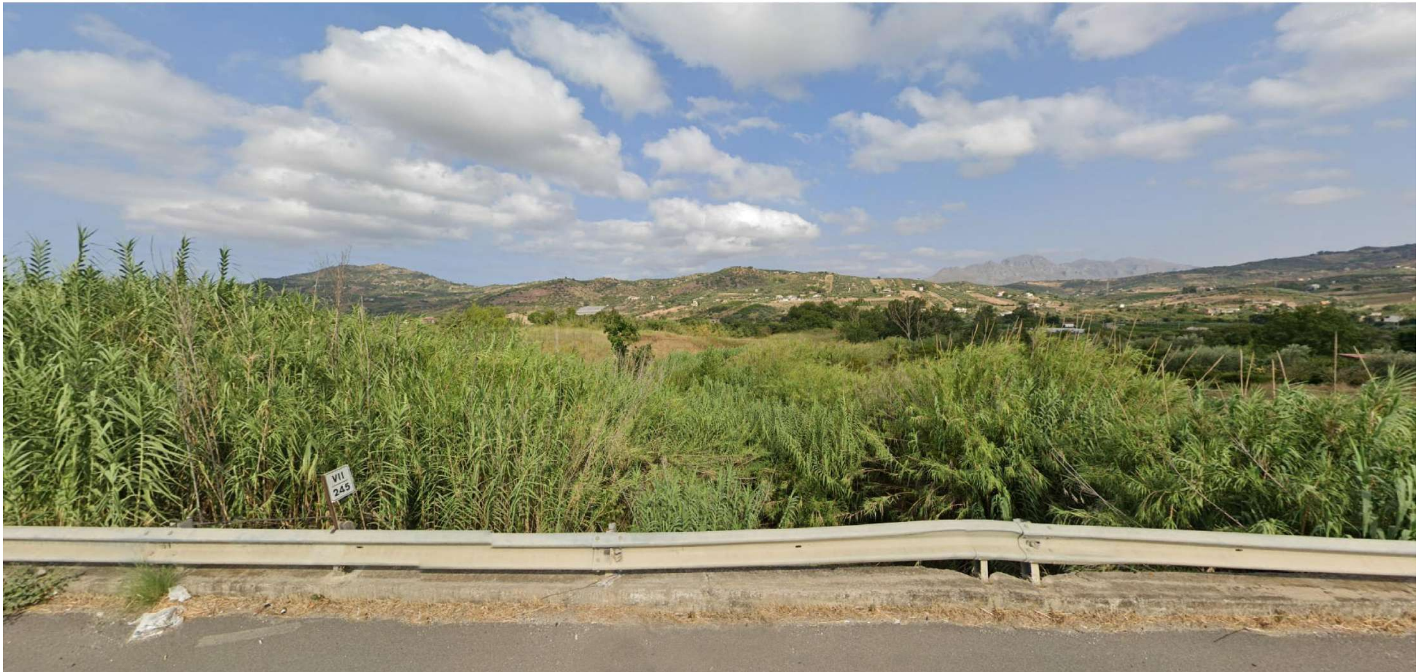
Punto 19: Visuale dalla SS121 in direzione est. Il punto fotografico è localizzato nel tratto in cui la SS121 sovrappassa il vallone Rigano, un corso d'acqua che alimenta il fiume Eleuterio percepibile al centro dell'immagine. La vista risulta parzialmente ostruita dalla presenza di vegetazione ripariale, tipica degli ambienti umidi (canneti). L'infrastruttura di progetto, proveniente da nord (a sinistra dell'immagine), attraversa la scena curvando in prossimità della SS121. In corrispondenza dello scavalco del Rigano, è previsto il viadotto VI08 "Rigano". Sia il punto di vista fotografico che il viadotto di progetto ricadono in vincolo paesaggistico art. 142 D. Lgs. 42/2004 comma 1 lett. c).
