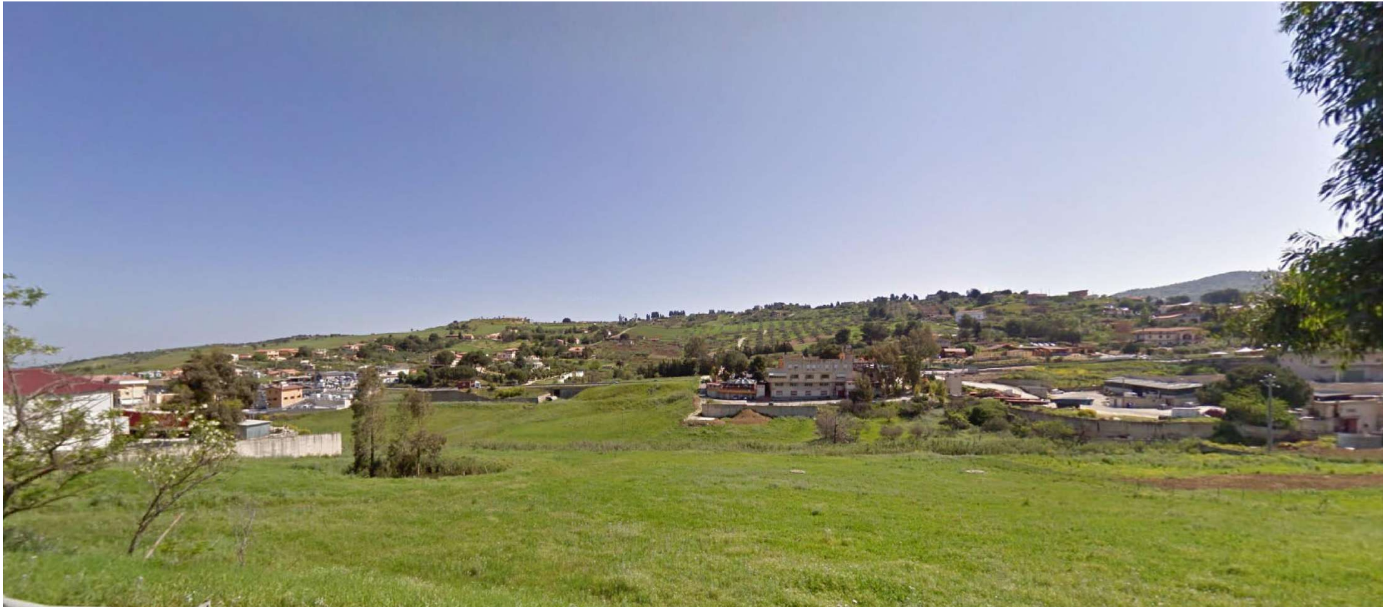
Punto 29: vista da SP77 in direzione nord-est. La visuale risulta aperta sul sistema collinare che caratterizza il territorio di Bolognetta. L'infrastruttura di progetto si sviluppa in corrispondenza del fosso individuabile dalla bassa fascia di vegetazione in secondo piano, che marca il limite tra i territori comunali di Misilmeri e Bolognetta. In lontananza è visibile la SS121 su cui il progetto prevede un nuovo svincolo con una rotatoria in corrispondenza del terrazzamento. Questo tratto dell'infrastruttura prevede una configurazione in leggero rilevato. Il paesaggio risulta fortemente urbanizzato.
