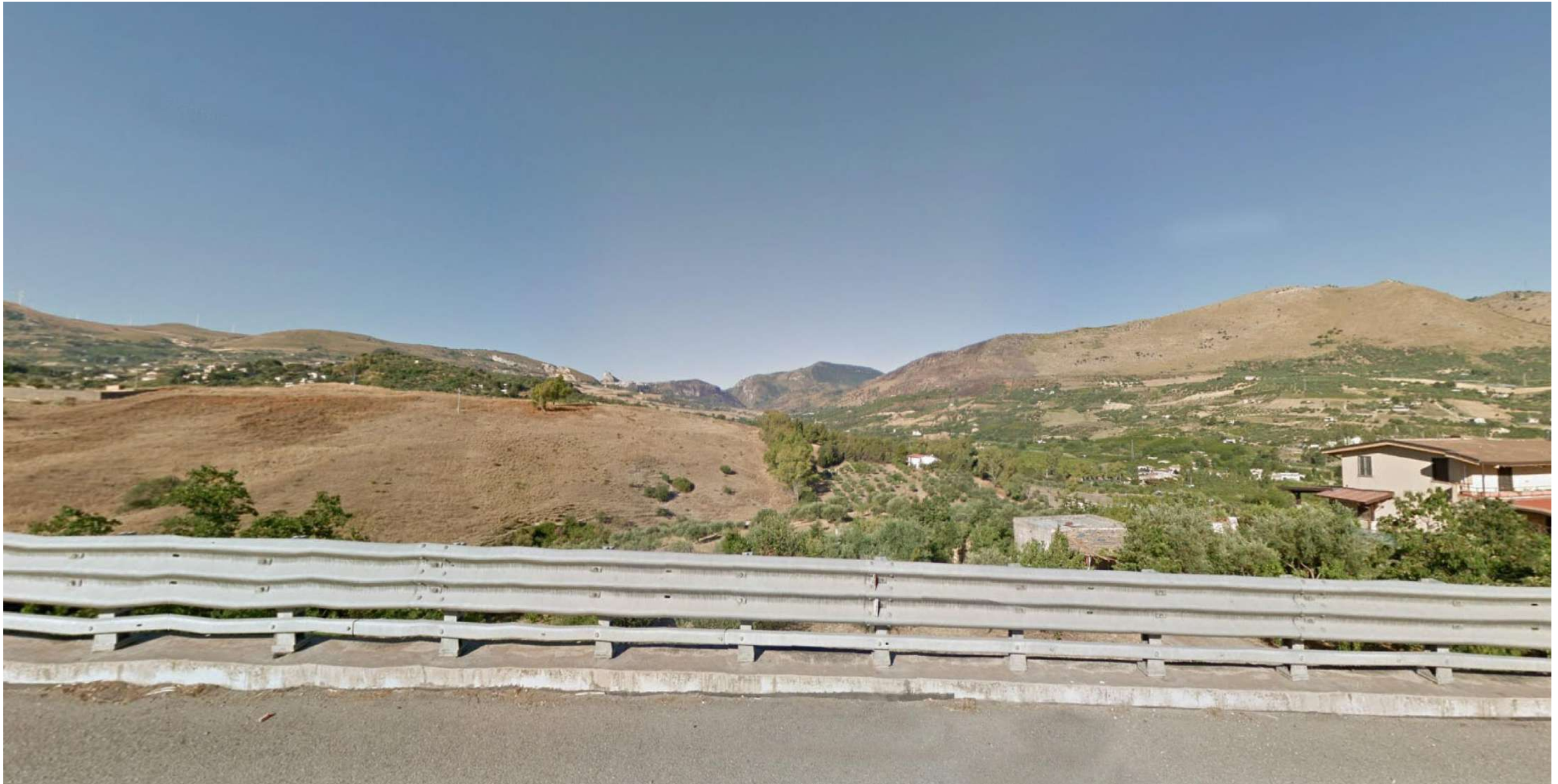
Punto 25: vista da SS121 in direzione sud-ovest. Questo tratto della statale si caratterizza per una forte panoramicità sulla valle del fiume Eleuterio. L'intervento di progetto, proveniente da nord (a destra dell'immagine) prosegue in secondo piano con una soluzione in viadotto (VI12 "Coda di Volpe"), per entrare in galleria (galleria artificiale GA05 "Amari") attraversando la collina visibile a sinistra dell'immagine.
