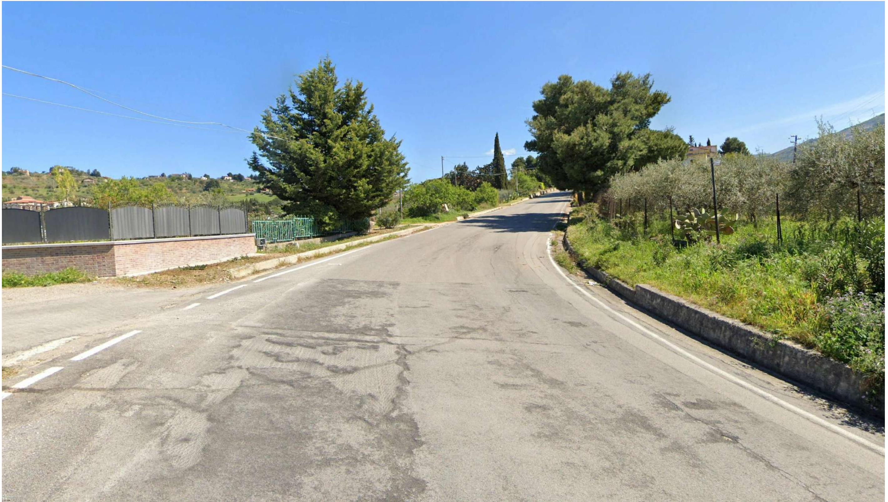
Punto 28: vista da SP77 in direzione sud-est. Il territorio a nord di Bolognetta è caratterizzato dalla presenza di piccoli agglomerati industriali frammisti a case sparse impostate sulle ortogonali delle strade principali. È il tipo di urbanizzazione che la nuova infrastruttura di progetto attraversa tra la SP77 e la SS121. Il punto di vista inquadra la rotatoria sulla SP77 in corrispondenza del nuovo svincolo di Bolognetta (SV04)
