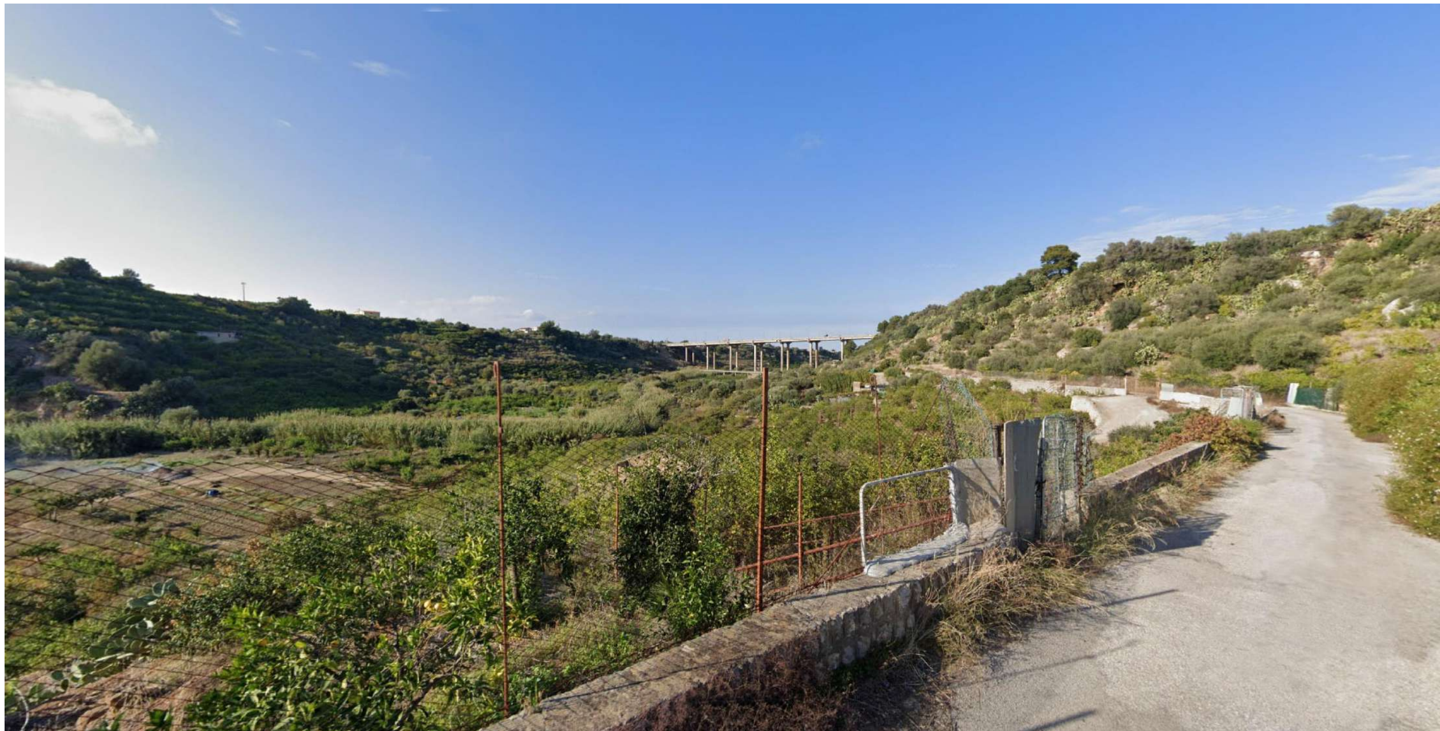
Punto 5: Visuale da strada comunale Eleuterio in direzione nord-ovest verso l'area interessata dalla realizzazione dell'opera VI02 – Viadotto Eleuterio 1. La visuale si apre sulla valle del fiume Eleuterio, e sul fondo della scena è riconoscibile il viadotto dell'autostrada A19 che attraversa la valle del fiume. Tutto il territorio visibile nell'immagine, ad esclusione del versante ovest (a sinistra) della valle, è vincolato ai sensi dell'art. 136 del D. Lgs 42/2004 "Aree di notevole interesse pubblico". Inoltre, tutta la valle ricade nella fascia di rispetto del fiume Eleuterio, tutelato ai sensi dell'art. 142 D. Lgs. 42/2004 comma 1 lett. c).
