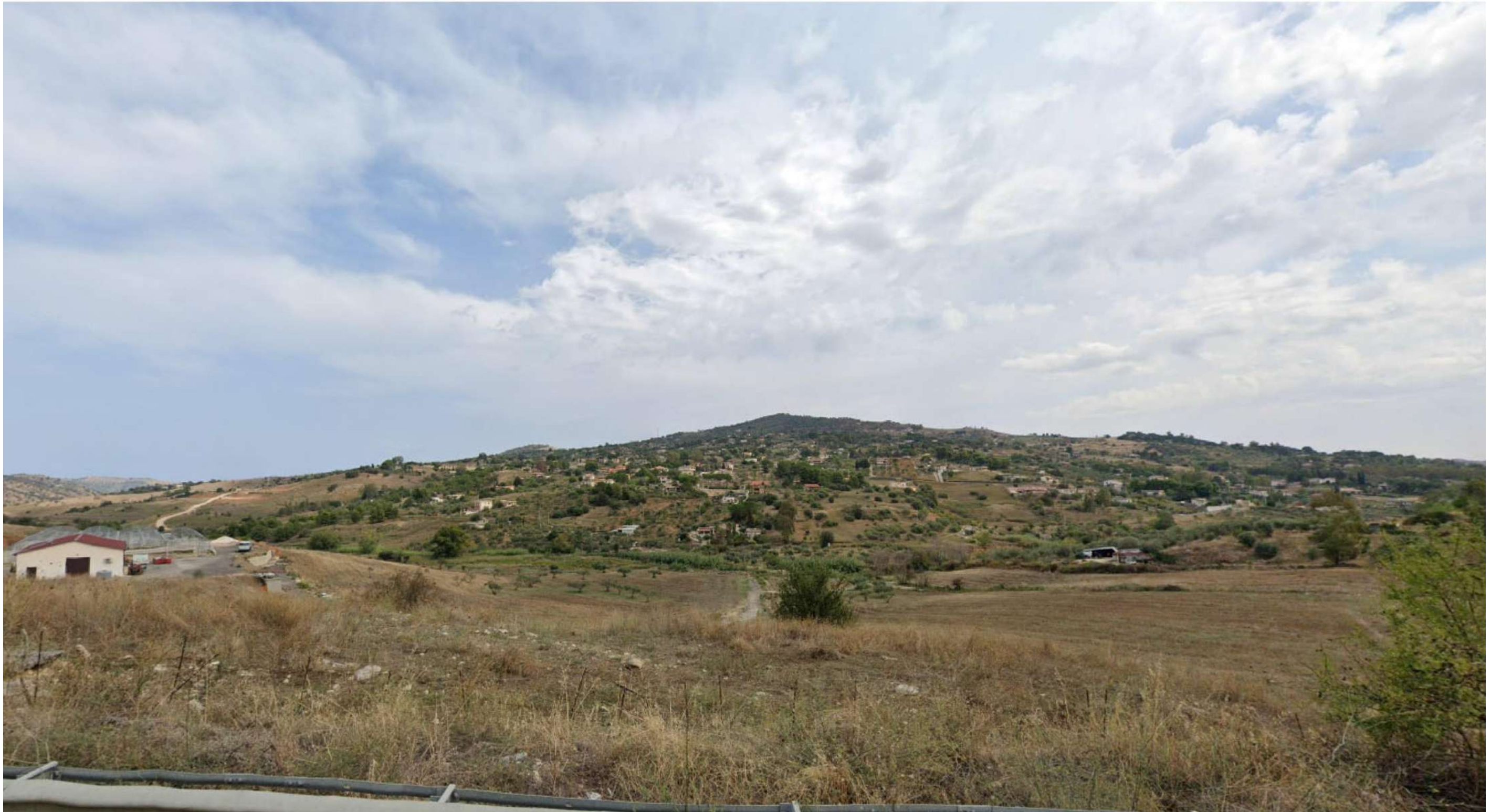
Punto 33: vista da SS121 in direzione est. L'infrastruttura di progetto attraversa il fiume Milicia con una soluzione in viadotto (VI14 "Milicia 1"), curva sul versante collinare al centro dell'immagine e prosegue in viadotto (VI15 "Milicia 2") in direzione sud verso lo svincolo di progetto. Questo tratto di strada in progetto ricade nella fascia di rispetto del fiume Milicia, vincolato ai sensi dell'art. 142 D. Lgs. 42/2004 comma 1 lett. c). il territorio attraversato risulta a vocazione agricola eccetto il versante sul fondo che si caratterizza per una urbanizzazione sparsa.
