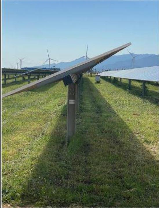
Le strutture di sostegno dei tracker sono costituite da pali verticali in acciaio al carbonio galvanizzato resistente alla corrosione che saranno infissi nel substrato e collegati da una trave orizzontale; ogni tracker è dotato di un motorino a vite senza fine, che trasmette il moto rotazionale al mozzo (Figura 4.3).
