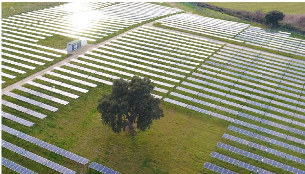
Figura 6 – esempio di impianto realizzato con i tracker proposti e pannelli in configurazione monofilare
