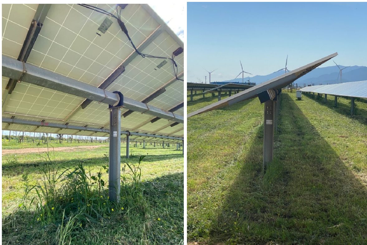
Figure 3-4 – Rappresentazione tipo della struttura di supporto
