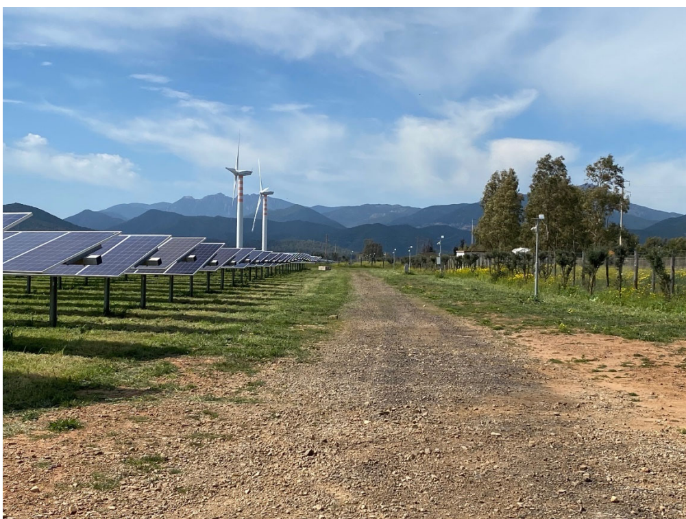
Figure 5-6 – impianti con viabilità interna
