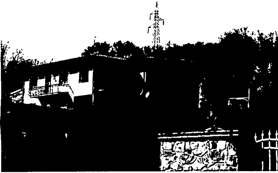
PILONE CHE VERRA' TOLTO A BALBANO, INDIFFERENTE ALLA VISTA PERCORRENDO LA STRADA SIA A PIEDI CHE IN MACCHINA
